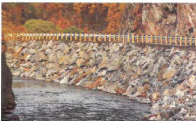
Stone-lined embankment in Drivdalen, Sør-Trøndelag. Photo: Tor Landløpet
