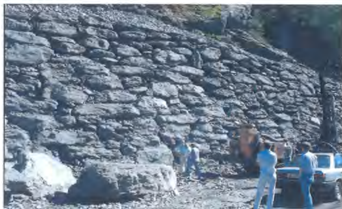
Fig. 25: Eksempel på tørrmur av fyllittstein. Muren er 8 - 10m høg.
