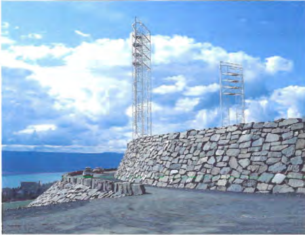
Fig. 26: Rundt sletta av Lysegårdsbakkane er det bygd fine tørrmurar med gravemaskin. Enkelte parti har dårlig forband.
