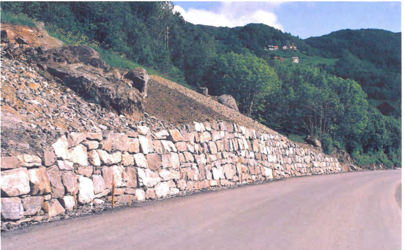
Fig. 36: Eksempel på murløysingar
