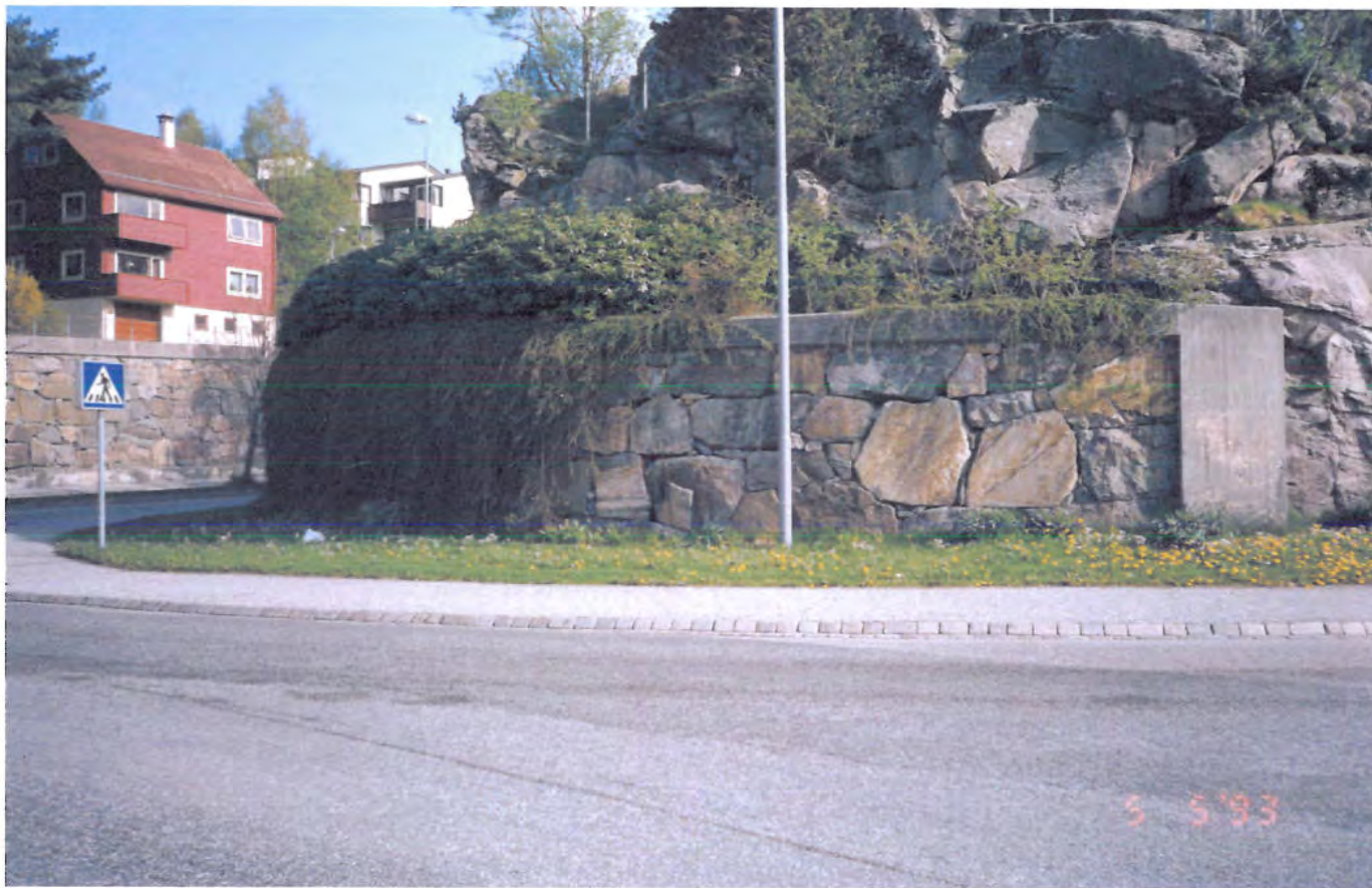
Fig. 4: Bilete av tørrmurar i tettbygd strøk i Bergen. Grove blokker vert innramma med ein betongkant på ca 0,5m. På deler av muren er det laga til bed på toppen.
