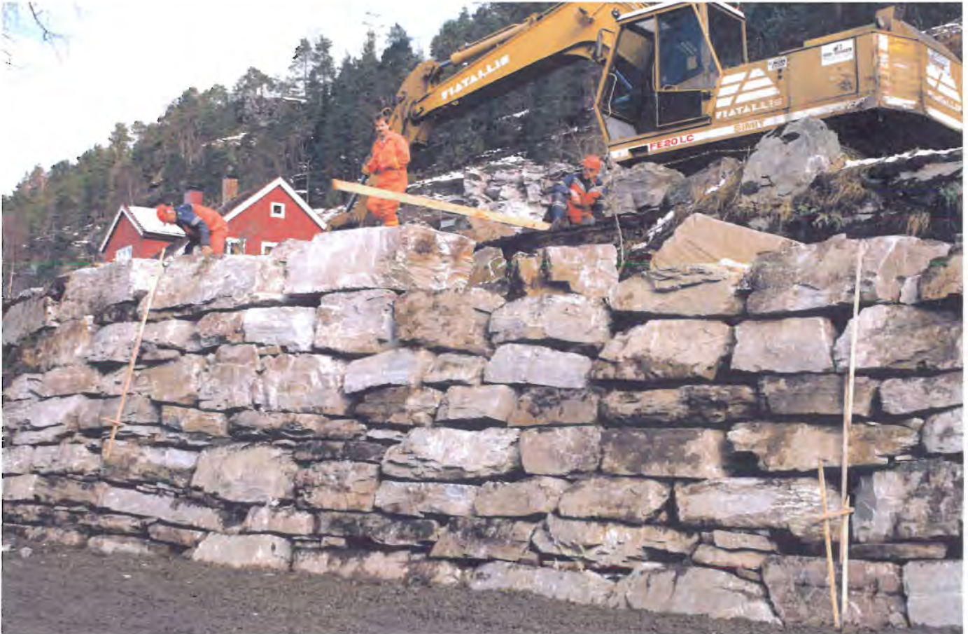
Fig. 28: Finare tørrsteinsmuring i tettbygd strøk ved Sandane. Personell er med og spettar på plass steinen.
