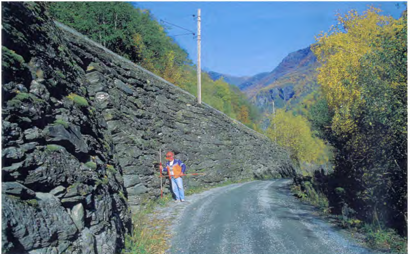
Fig. 2: Tørrmurar langs Flåmsbana. Muren er bygd i 1930-åra og er like fin og funksjonell.
