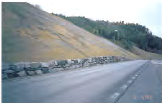
Fig. 24: Sikring av skjeringsfot med tørrmur ved Bolstadøyri.
