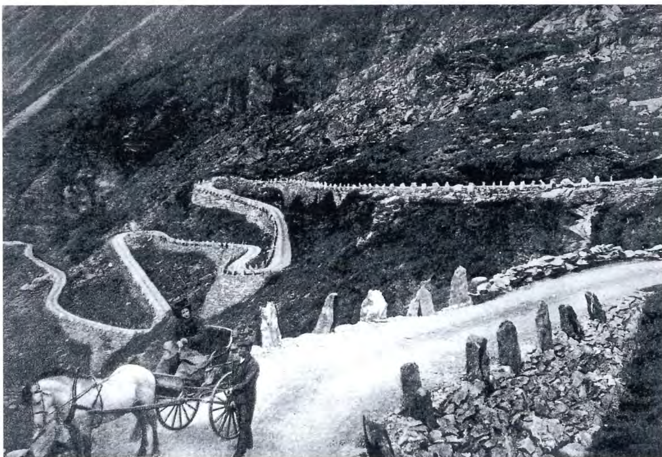
Fig. 18: Parti frå Geirangervegen, som vart opna i 1889. Det tok 300 mann 8 år å byggja vegen. Geirangervegen var ei teknologisk landvinning, funksjonell og vakker.
