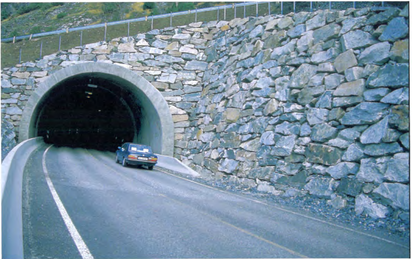
Fig. 1: Tørrmur bygd av gneisblokker og tilpassa rundt tunnel- portal i Aurland.
