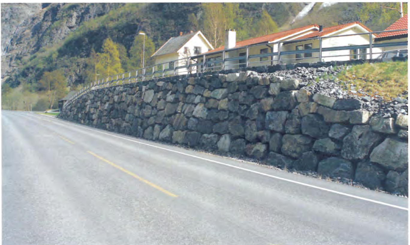
Fig. 30: Bilete av tørrmur ved oppkøyning til bustadhus i Gudvangen - detalj- og oversiktsbilete.
