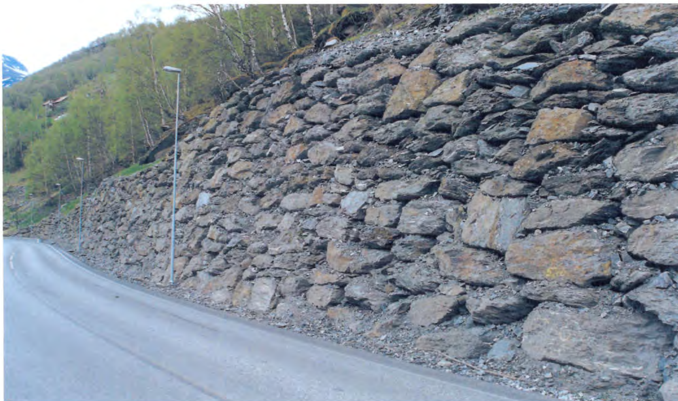
Fig. 12: Tørrmur bygd med fylitt-blokker ved Aurland. Muren er 7-8m høg.
