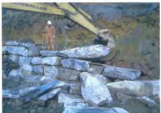
Fig. 57: Hjelpemann i trygg avstand frå maskinskuffa. God kontakt mellom hjelpemann og maskinførar er viktig
