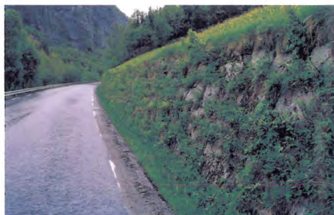
Fig. 7: Tørrmur ved Eidsdal er lagt i humusholdig sand. Gras og vegetasjon veks i fugene.
