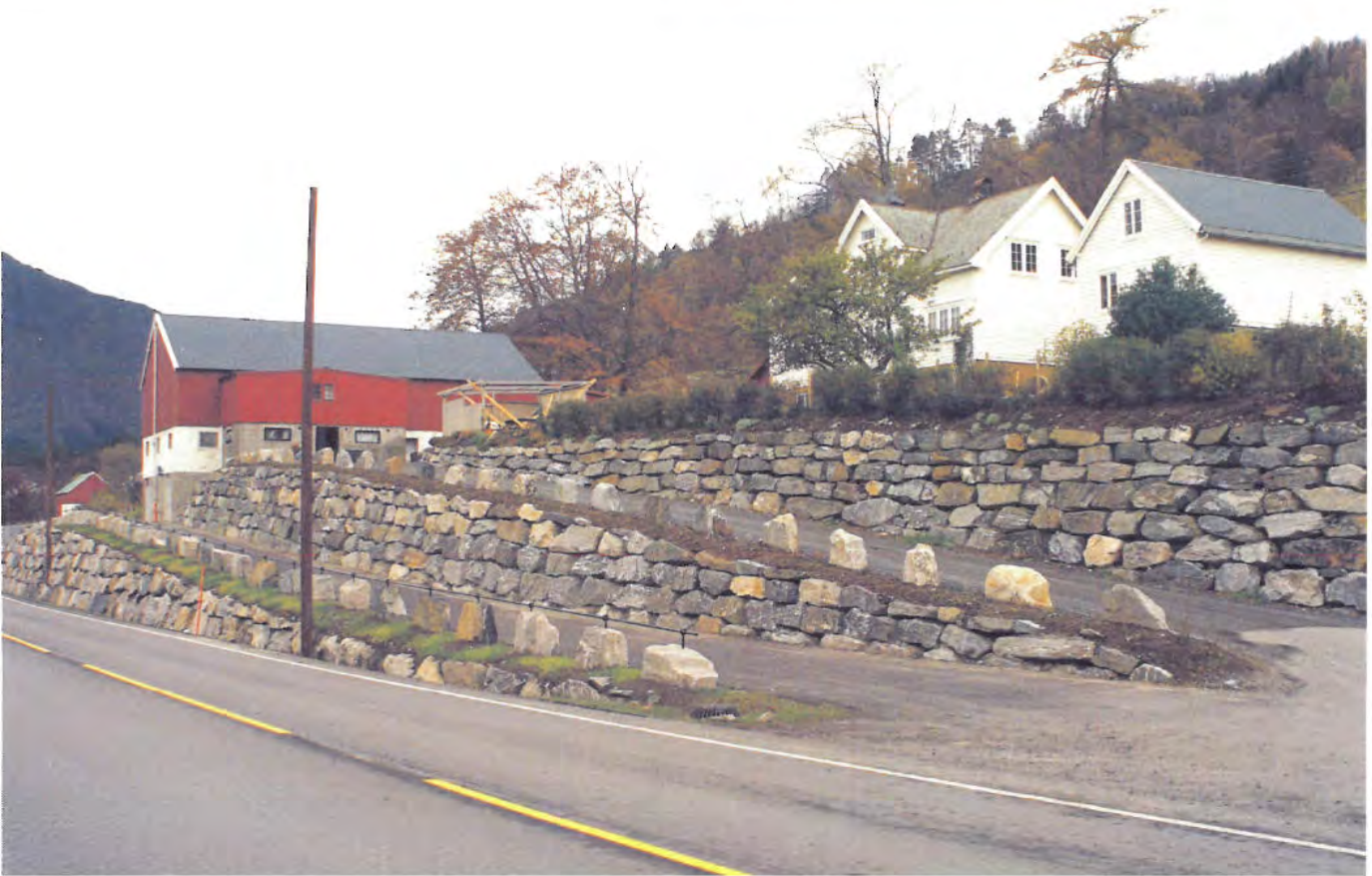
Fig. 34: Eksempel på murløysingar
