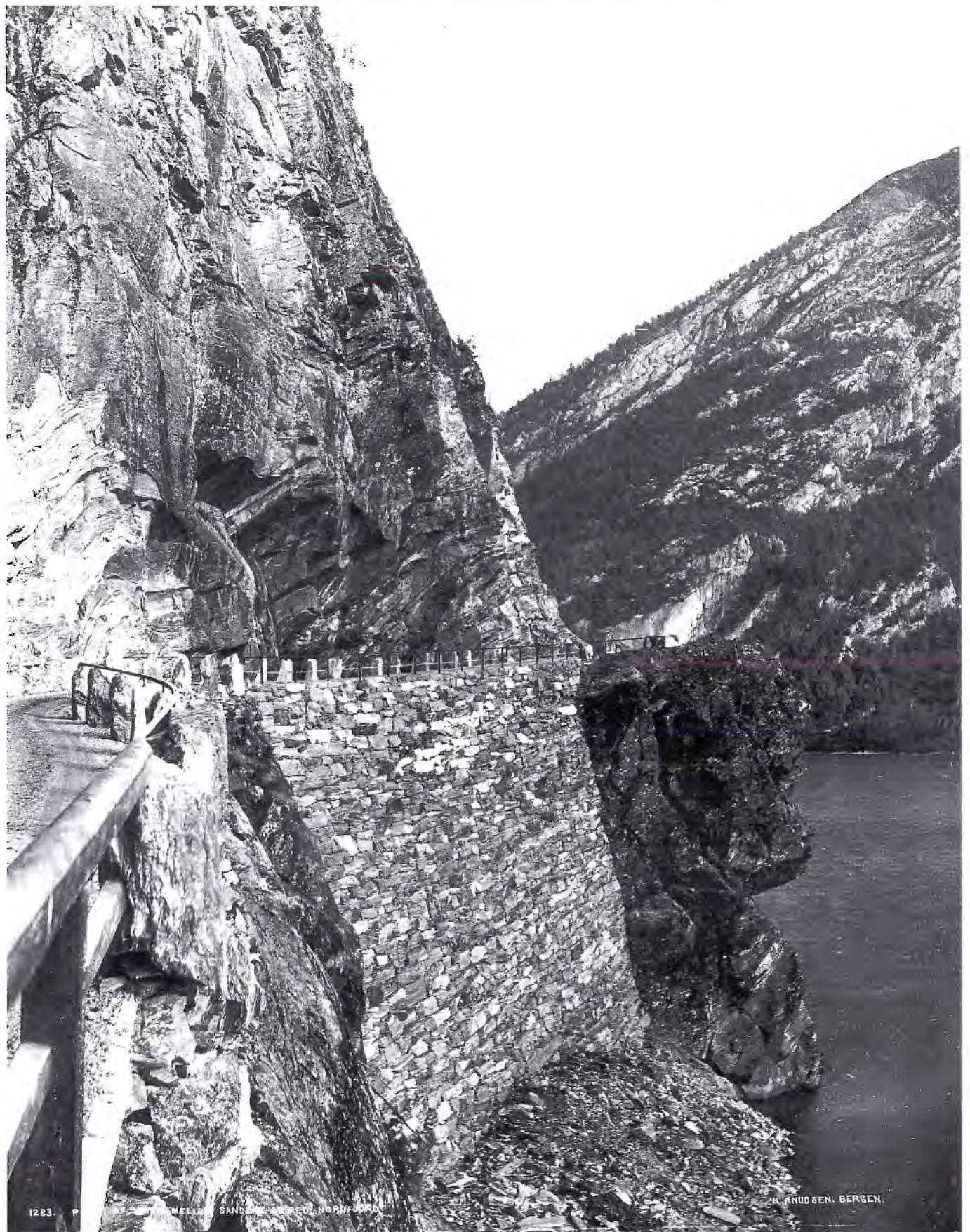
Fig. 13: «Storemuren» mellom Sandane og Reed i Nordfjord. Muren er 55 m lang og største høgd er 21 m. Muren vart bygd i 1880-åra, og er eit prov på godt handverk.
