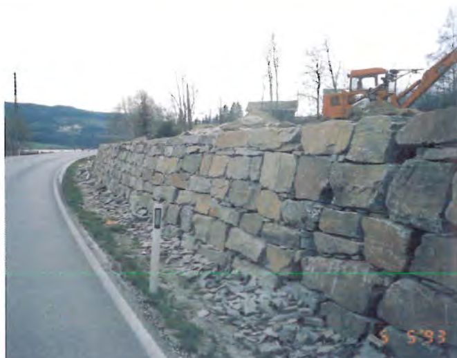
Fig. 5: Tørrmur på Voss oppsett av ein privatperson. Han har brukt gravemaskin, sleggje, spett, personleg tolmod og sjel.
