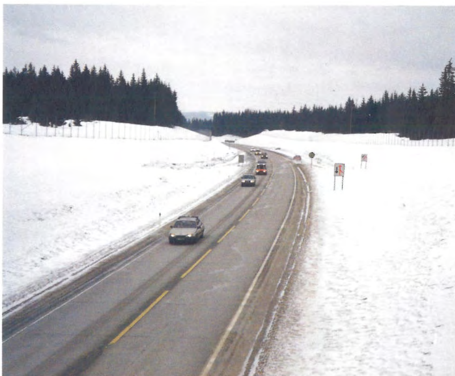
Fig. 2.6 Betongdekke på hovedveg. Ådt. ca. 10.000
