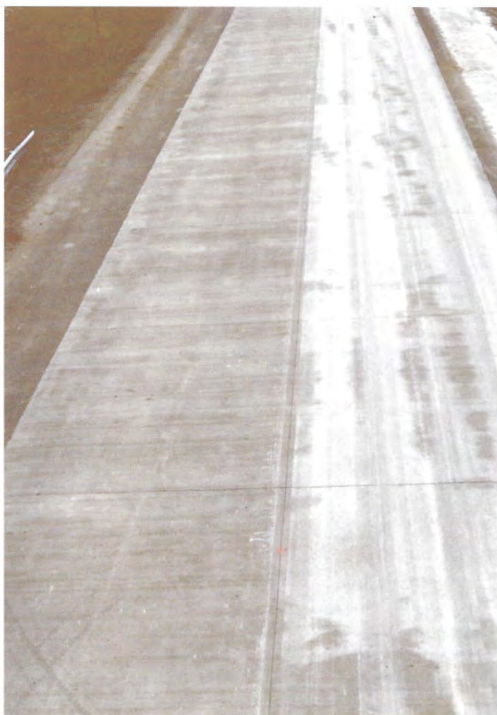
Fig. 9.1 Høyre dekkehalvdel er slipt for å oppnå jevnt nok dekke
