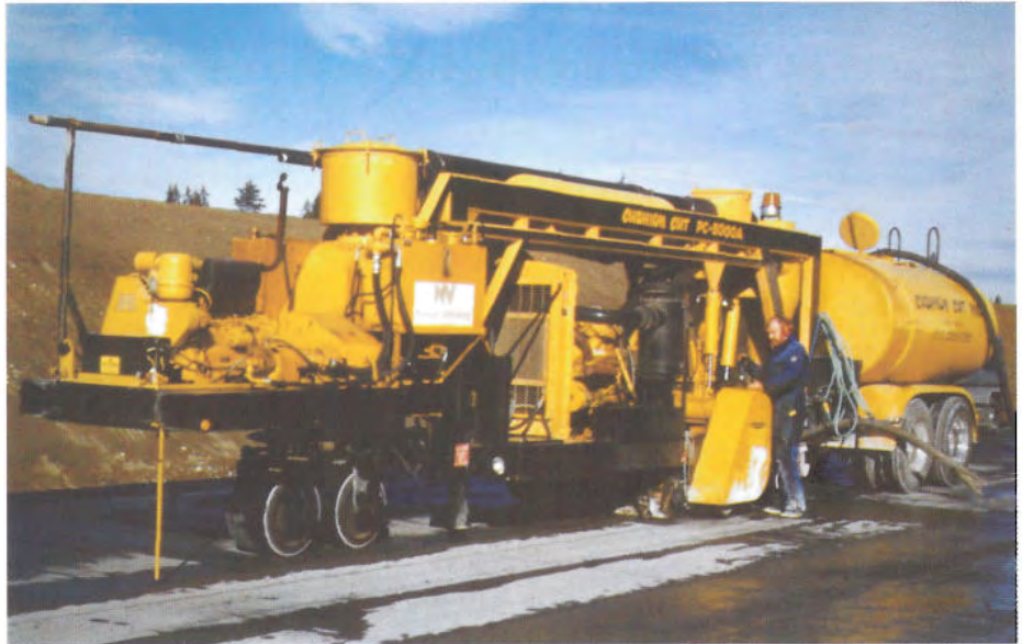
Figur 11.2 Diamantslipemaskin under arbeid
