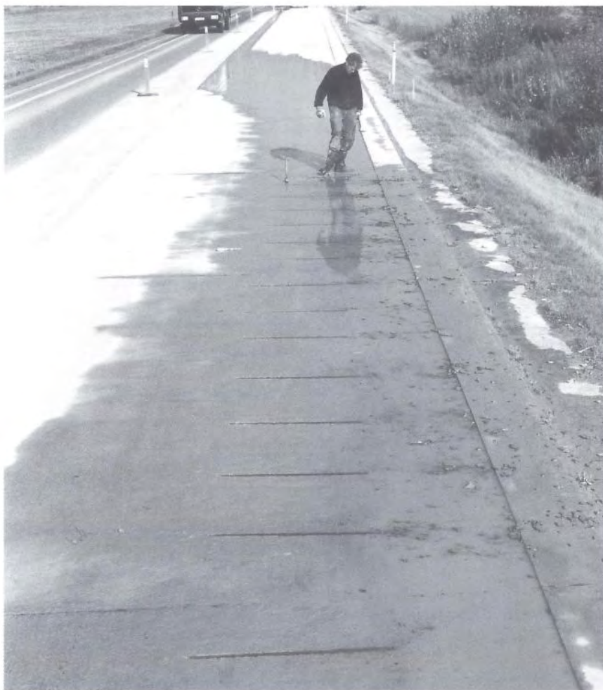
Figur 11.19 Avbinding av langsgående sprekk med forankringsjern
