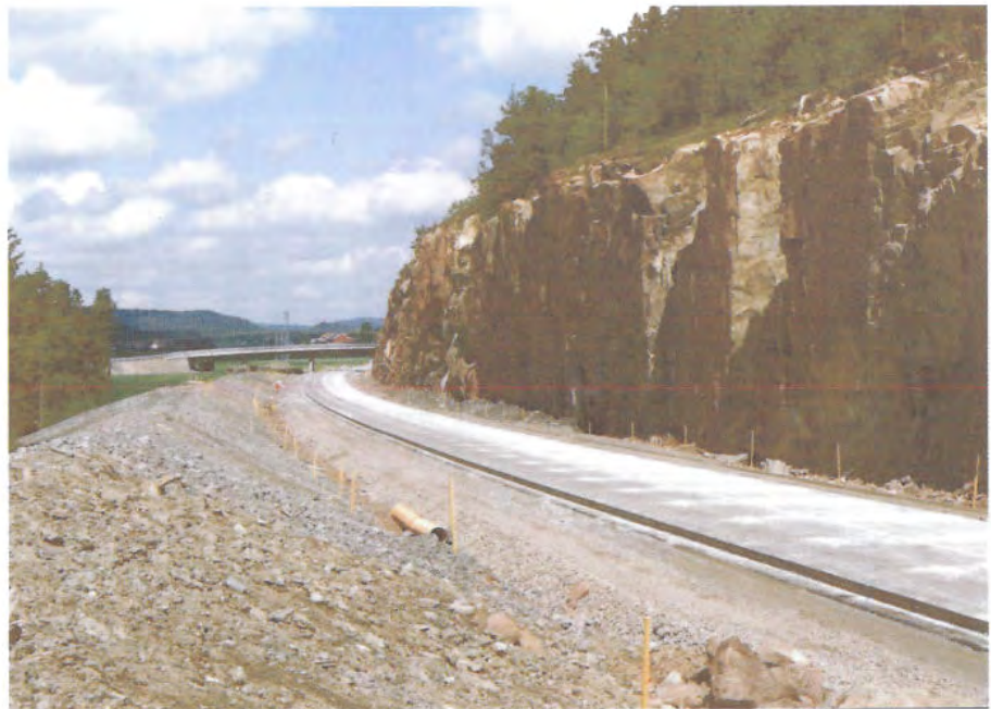
Fig. 5.2 Nylagt dekke dimensjonert for 2 ganger sliping
