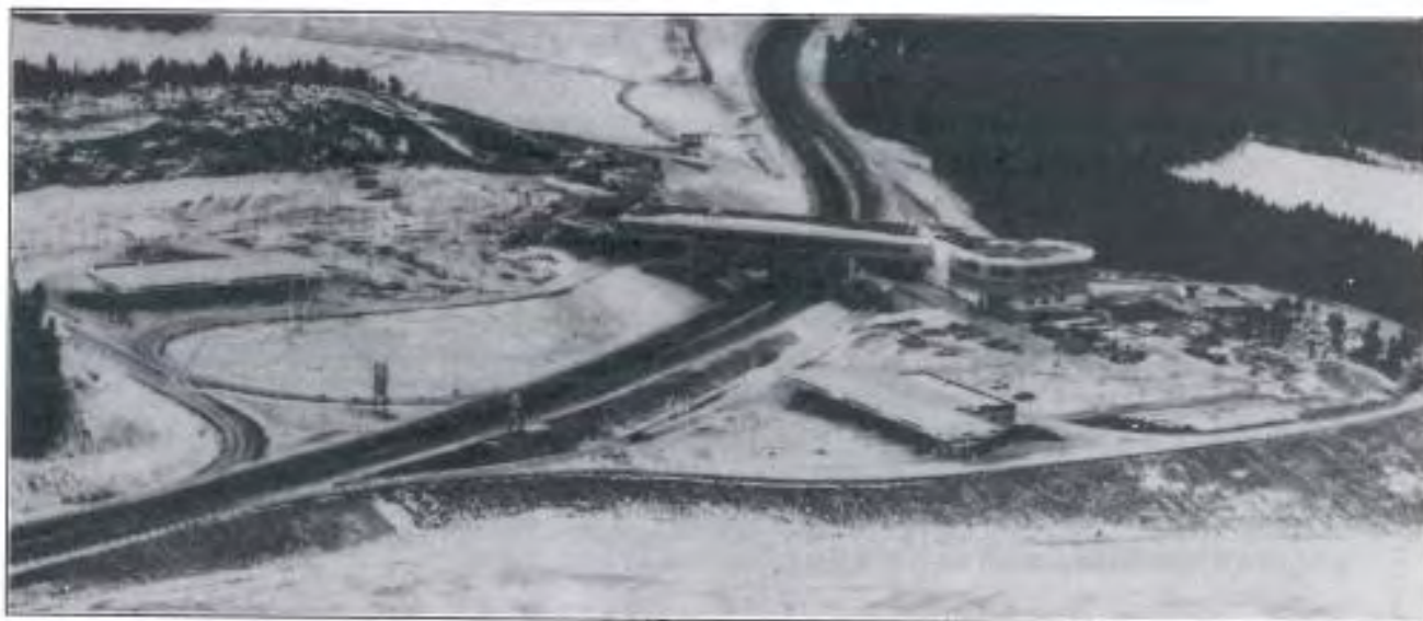
Figur 3 Servicebru over E6 i Malvik øst for Trondheim
