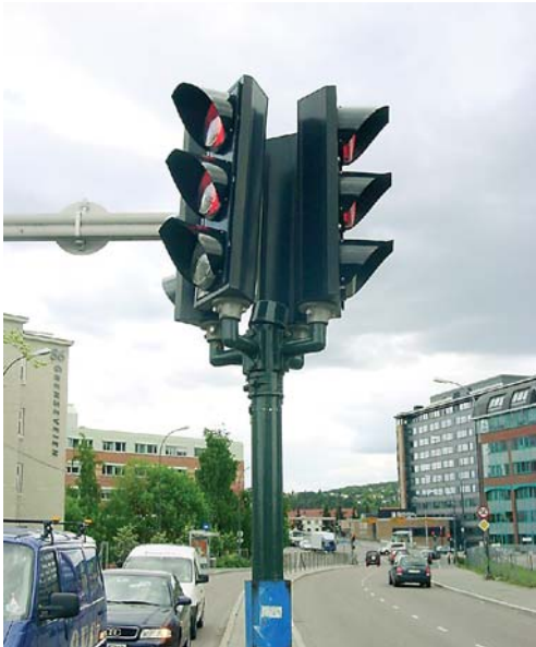
Figur 4-11: Skjeve lyshoder og løse skjermer bør repareres.
