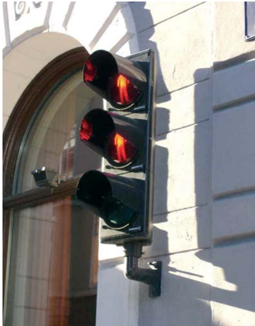
Figur 2-75: Eksempel på lyshode montert på fasade.
