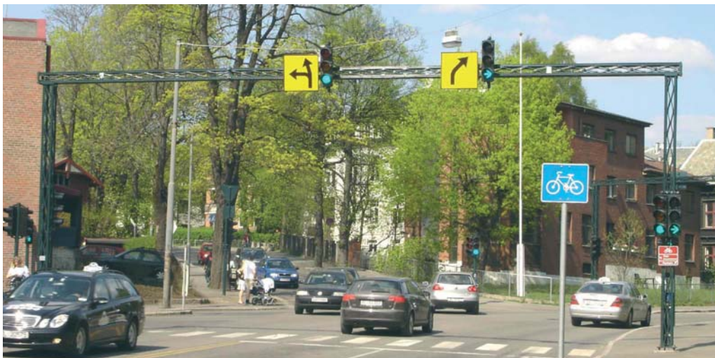
Figur 2-74: Eksempel på bruk av gitterportal.
