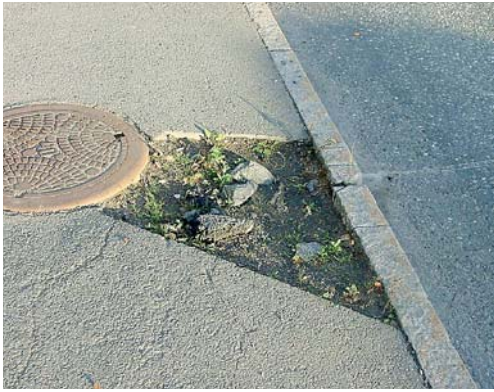
Figur 4-14: Ved etablering av detektorer skal fortau settes i stand igjen.
