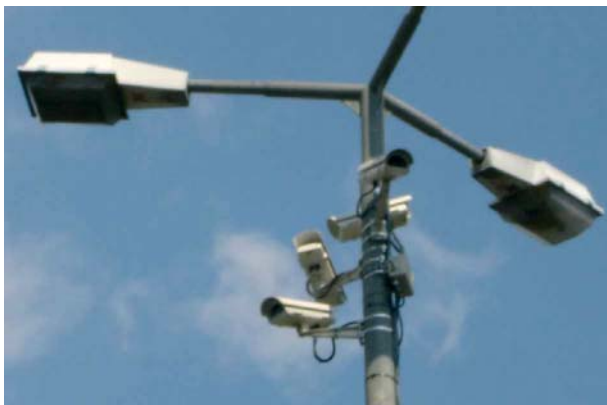
Figur 2-70: Videokamera plassert på gatelysmast.
