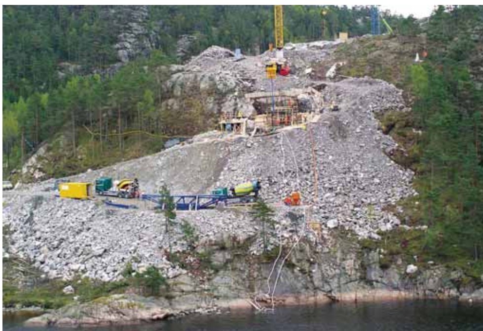
Figur 6.4: Tiltak i anleggsfasen bør omtales, men skal bare tillegges vekt ved fastsetting av konsekvens hvis det gir varige virkninger. Bildet viser arbeider i forbindelse med etablering av brupilarer for den nye Svinesundbrua (foto: Rune Westerström, Statens vegvesen)
