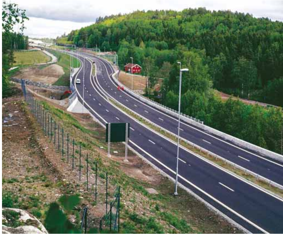
Figur 6.10: Når omfanget av et veginngrep skal vurderes, må man ikke glemme å ta hensyn til belysning, skilting, rekkverk og gjerder, i tillegg til veg og side-terreng (foto: Lennart Forsberg, Statens vegvesen).
