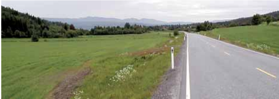
Jordbruksarealer sør for Kongsberg (foto: Statens vegvesen)
