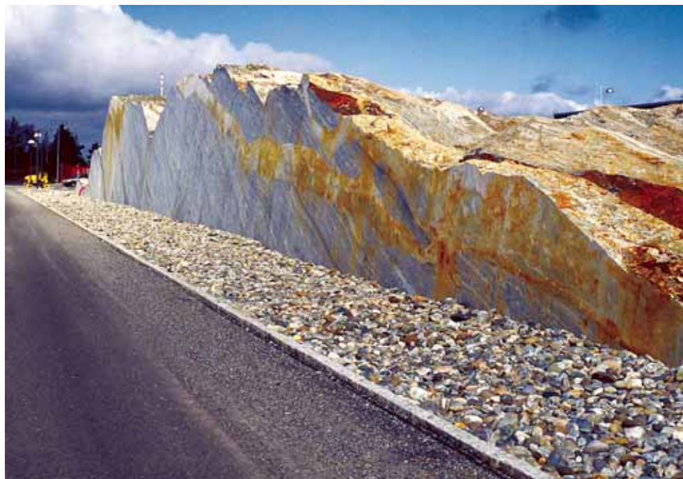
Figur 3.9: Utforming som ligger inne i anleggskostnadene regnes ikke som avbøtende tiltak. På bildet har man benyttet wire-skjæring i stedet for vanlig sprengning for at skjæringen skal bli en opplevelse. (foto: Lennart Forsberg, Statens vegvesen)
