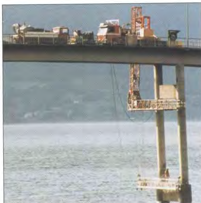
Figur 4.2-14 Inspeksjon av høye søyler
