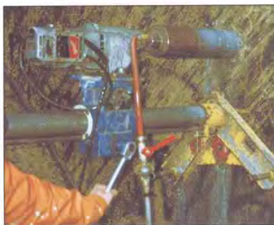
Figur 7.3-8 Utboring av betongkjerne
