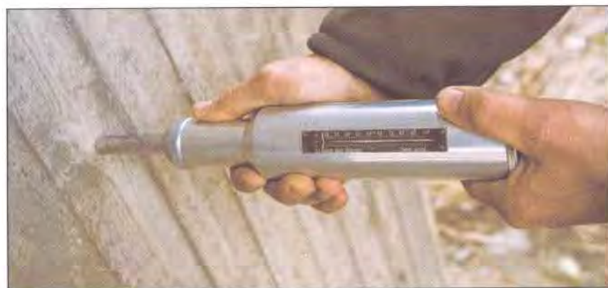
Figur 7.3-9 Måling av betongfasthet med slaghammer
