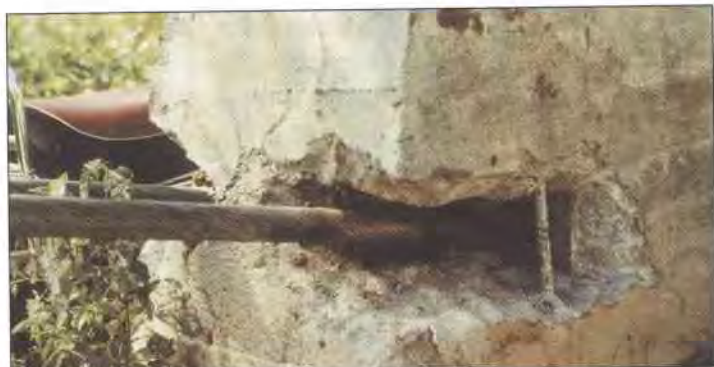
Figur 6.5-2 Innstøpte kabelhoder
