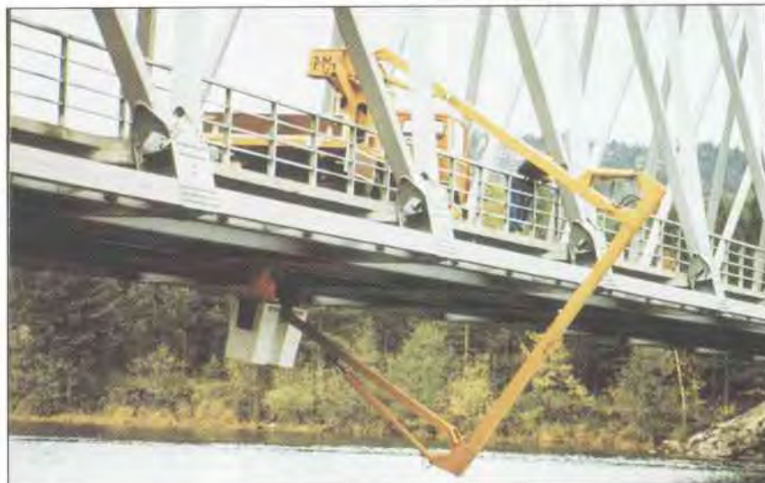
Figur 4.2-12 Inspeksjon av fagverksbru (K-lift)
