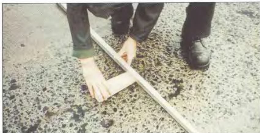
Figur 7.2-2 Måling av sporslitasje
