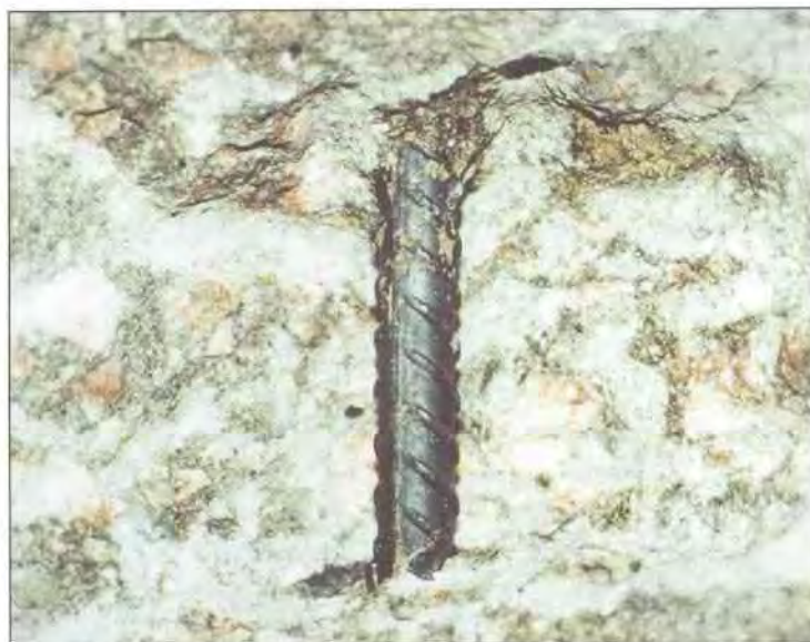
Figur 7.3-13 Eksempel på rustgrad A
