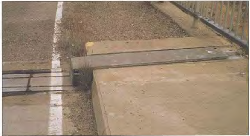
Figur 6.3-7 Fugekonstruksjonens innfesting
