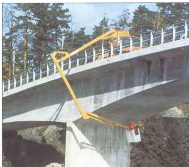
Figur 4.2-10 Inspeksjon av fritt-frambygg bru (K-lift)
