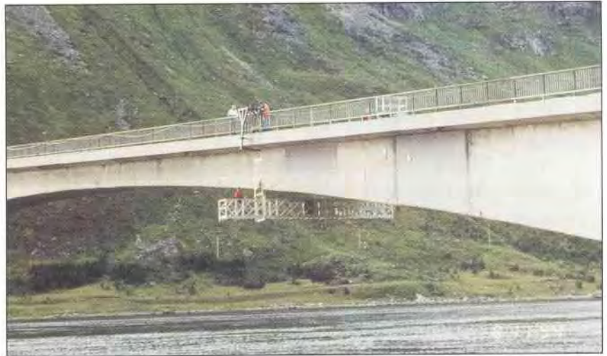
Figur 4.2-16 Inspeksjon fra hengestillas
