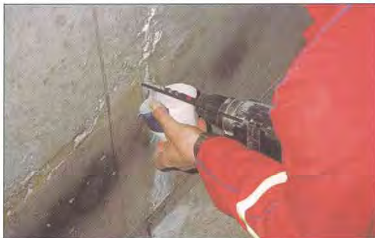
Figur 7.3-5 Utboring av betongstøv
