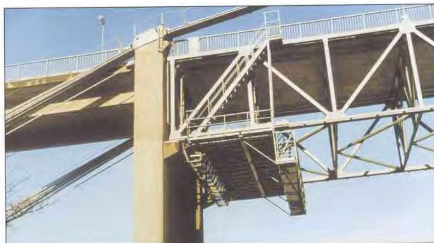
Figur 4.2-15 Inspeksjon fra malevogn
