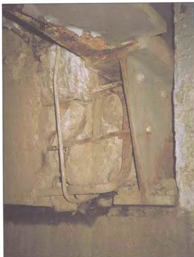
Figur 6.3-2 Brudd i endetverrbærer
