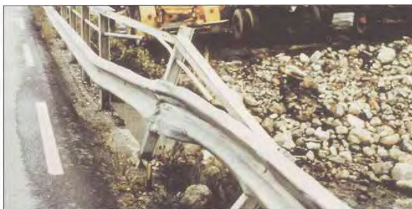
Figur 5.3-2 Skade med konsekvens for trafiksikkerheten
