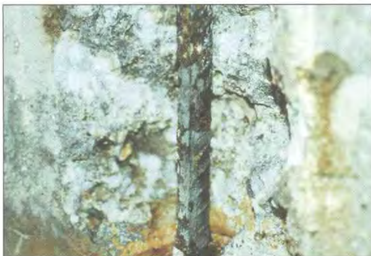
Figur 7.3-16 Eksempel på rustgrad D
