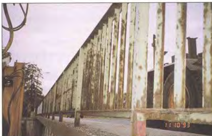
Figur 6.4-8 Maling-/korrosjonsskade
