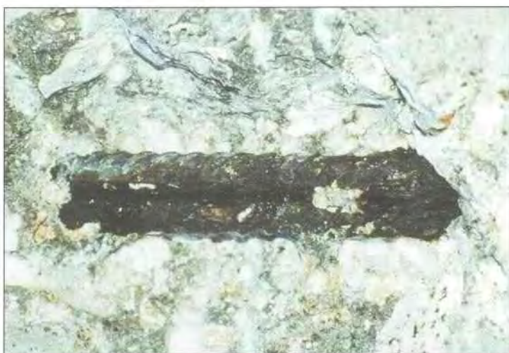
Figur 7.3-15 Eksempel på rustgrad C
