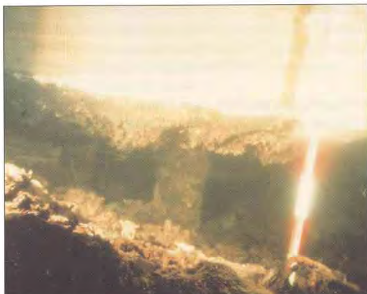
Figur 6.6-1 Erosjon og undergraving
