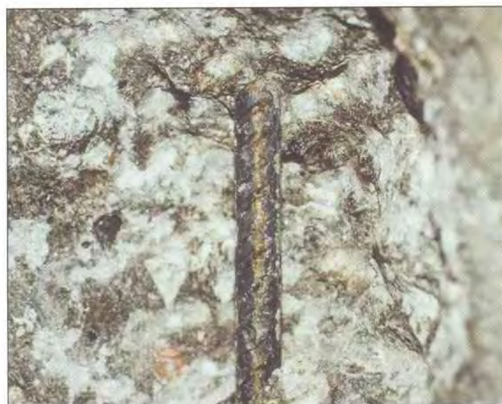
Figur 7.3-14 Eksempel på rustgrad B
