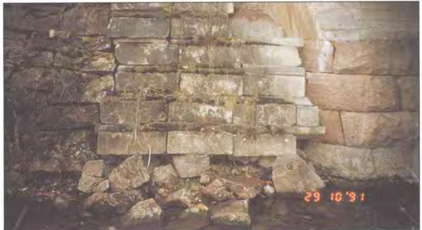
Figur 6.3-4 Utrasing av steiner
