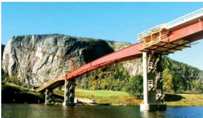
Fig. 4.3.3-6: Bjelkebru, platebærere, variabel høyde. Byggverkstype 381
