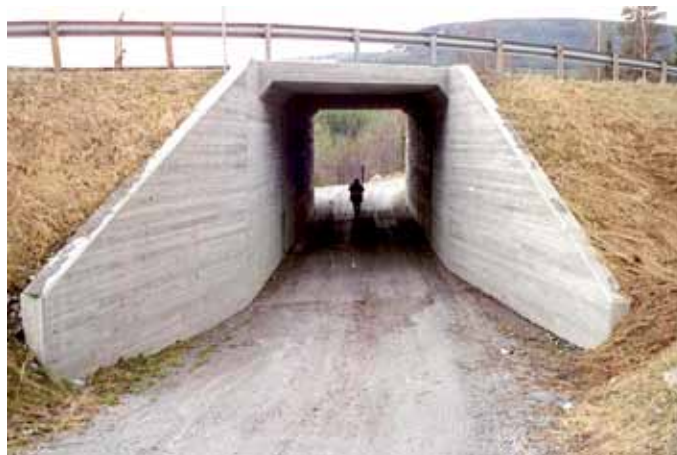
Fig. 4.3.1-3: Kulvert, plassprodusert, med bunnplate. Byggverkstype 111
