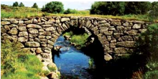
Fig. 4.3.5-7: Hvelvbrú med hel overmur, Byggverkstype 561
