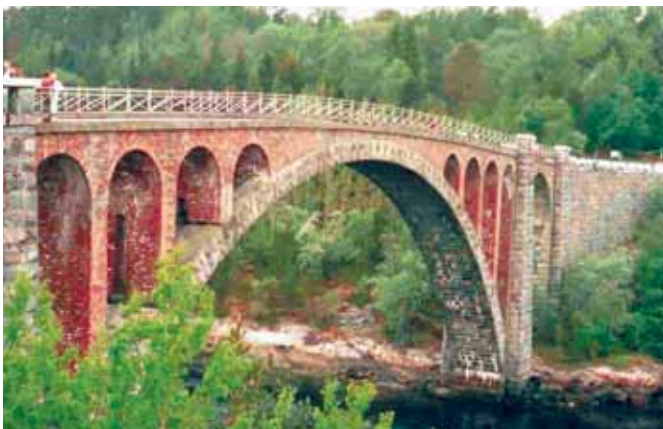
Fig. 4.3.5-9: Hvelvbrú med overmur av små hvelv, Byggverkstype 572
