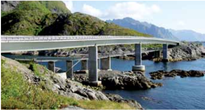
Fig. 4.3.4-3: Kassebru, stål med samvirkende betongplate. Byggverkstype 411
