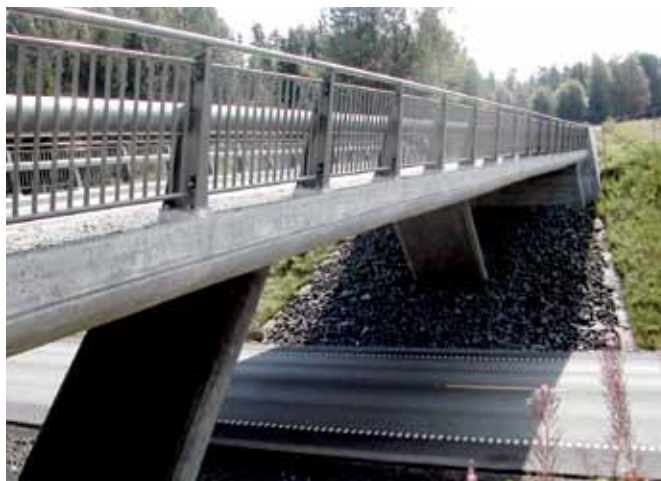
Fig. 4.3.6-9: Sprengverksbru, trapes, overliggende brubane. Byggverkstype 664
