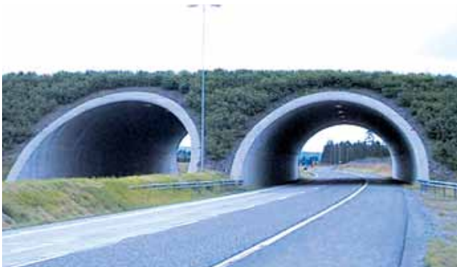
Fig. 4.3.9-5: Løsmassetunnel, Byggverkstype 983
