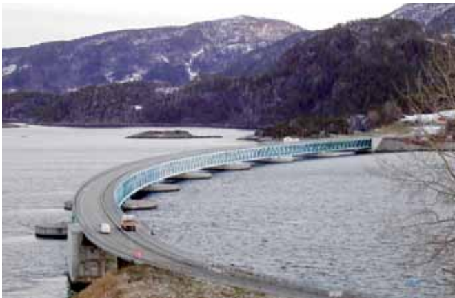
Fig. 4.3.7-7a: Flytebru, adskilte flyteelementer uten forankring. Byggverkstype 766, stålfagverk.
