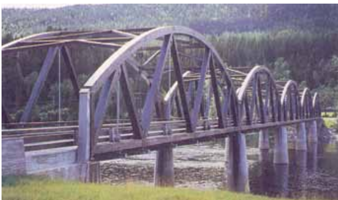
Fig. 4.3.6-6: Fagverksbru, fritt opplagt med buet overgurt. Byggverkstype 621
