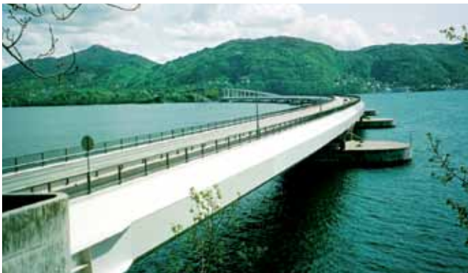
Fig. 4.3.7-7b: Flytebru, adskilte flyteelementer uten forankring. Byggverkstype 766, stålkasse.
