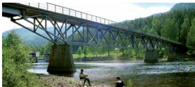
Fig. 4.3.6-3: Parallellfagverksbru, overliggende brudekke, hellende endestaver. Byggverkstype 611
