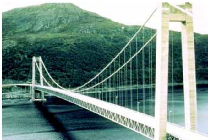
Fig. 4.3.7-3: Hengebru med fagverk, ingen opphengte sidespenn. Byggverkstype 721
