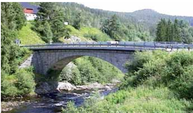
Fig. 4.3.5-8: Hvelvbrú med hel overmur, Byggverkstype 561
