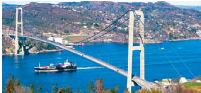
Fig. 4.3.7-2: Hengebru med kasse, ingen opphengte sidespenn. Byggverkstype 731
