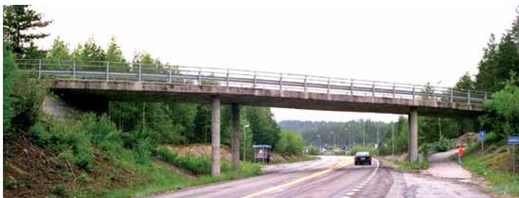
Fig. 4.3.2-2: Platebru, massiv med overliggende kantforsterkning. Byggverkstype 214
