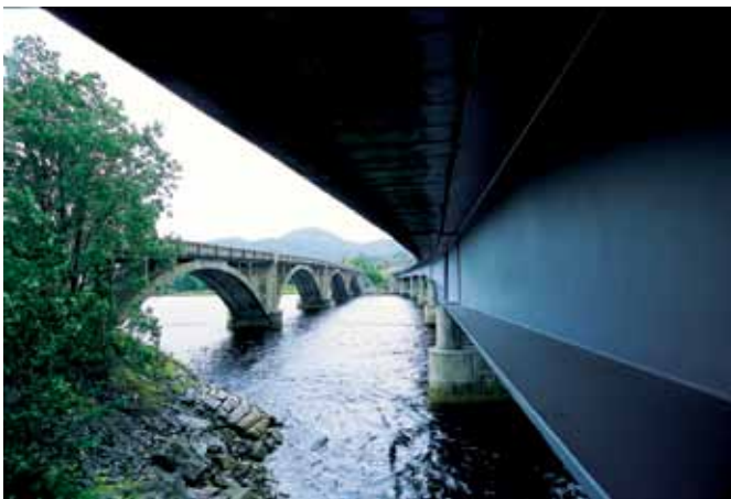
Fig. 4.3.3-5: Bjelkebru, platebærere, konstant høyde. Byggverkstype 372
