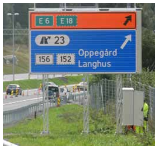
Figur 2.8 Eksempel på mekanisk variabelt skilt/ prismeskilt (med utvendig belysning)
