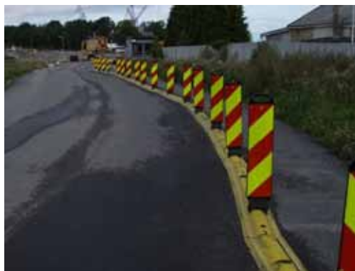
Figur 4.8 Eksempel på hindermarkeringer montert i rekke på en ledeskinne.
