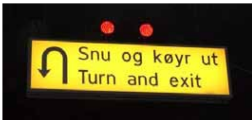
Figur 2.10 To-posisjonsskilt i aktiv og passiv stilling.
