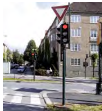
Fig. 6 Vikepliktskilt tillatt montert på signalstolpe
