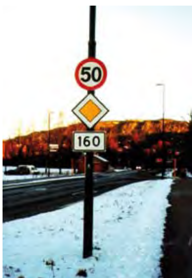
Fig. 84 Trafikkskilt montert på en lysmast med avskjæringsledd (NE)
