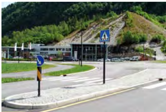
Fig. 43 Øymarkering og gangfeltskilt settes på hver sin stolpe når avstand fra øypiss til gangfelt er >2m.
