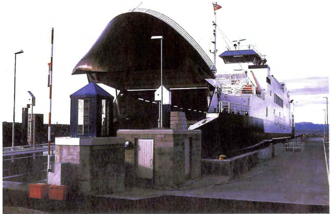
Eksempelet fra Mortavika i Rogaland er forbilledlig i formgivning, materialbruk og helhetsvirkning. (Rogaland vegkontor)
