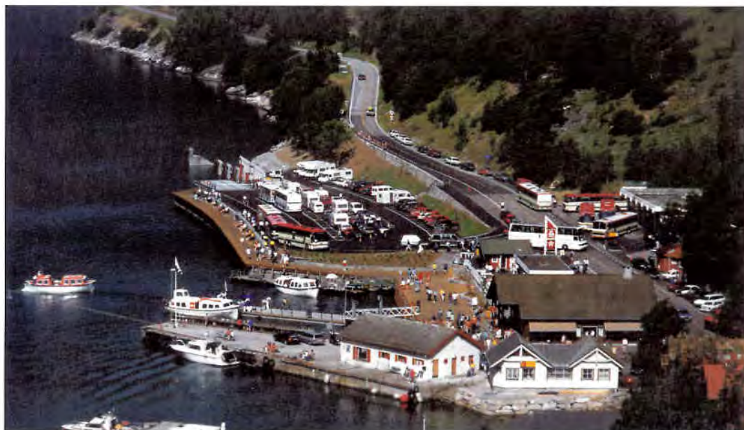
Bortsett fra bygningsmiljøet viser det nye ferjeleiet i Geiranger et tydelig resultat av en styrt prosess (Møre og Romsdal vegkontor).
