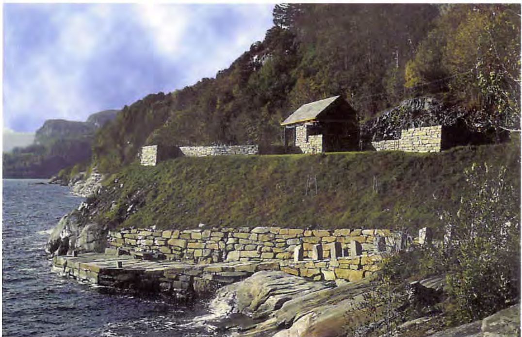
Steinstøberget rasteplass i Hordaland. Riktignok ikke et eksempel fra ferjeleier, men med bygningsmessige elementer med klar relevans. Høyt ambisjonsnivå, vakker utforming. Prosjektet er realisert på grunnlag av arkitektkonkurranse. (Hordaland, sivilarkitekt MNAL Tordis Hoem)
