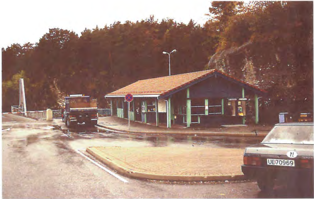
Enkel og god utforming. Telefon og oppslagstavler er integrert i byggets fasader. Typeløsninger kan gjerne ha et slektskap med dette uttrykk. (Hallhjem, Hordaland)
