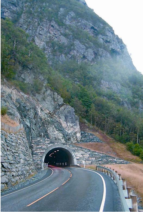
Figur 3.1 Tunnel på riksveg 15. Eksempel på selvstendig byggverk som visuelt inngår på en positiv måte i det store landskapsrommet. Byggverket er utformet med materialer og håndverk som gir en tidløs kvalitet (Foto: Astrid Taklo).
