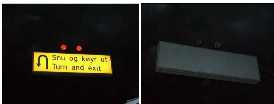
Figur 6.5 Eksempel på skilt for snunisje i tunnel. To-posisjonsskilt vist i aktiv og passiv stilling.
