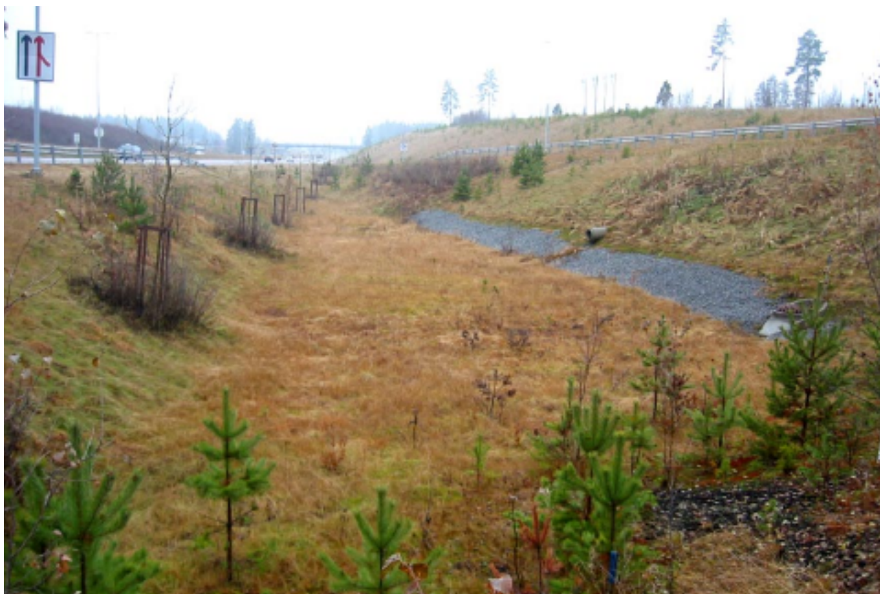
Figur 6.4.3.2. Foto av infiltrasjonsbasseng ved Rv174 i Akershus. Innløp til venstre og høyre i bildet. Oppstuving av vann på vinteren ledes via nedløpskummer til lukket perkolasjonsmagasin (til høyre i bildet).
