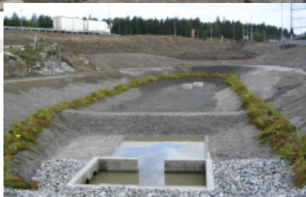
Figur 6.3.4.2. Vått overvannsbasseng under bygging i et kryssområde på E6 i Akershus. Slamdelen (forbehandlingen) er integrert i hovedbassenget og bygges med betongplate på bunnen for å lette slamfjerningen.
