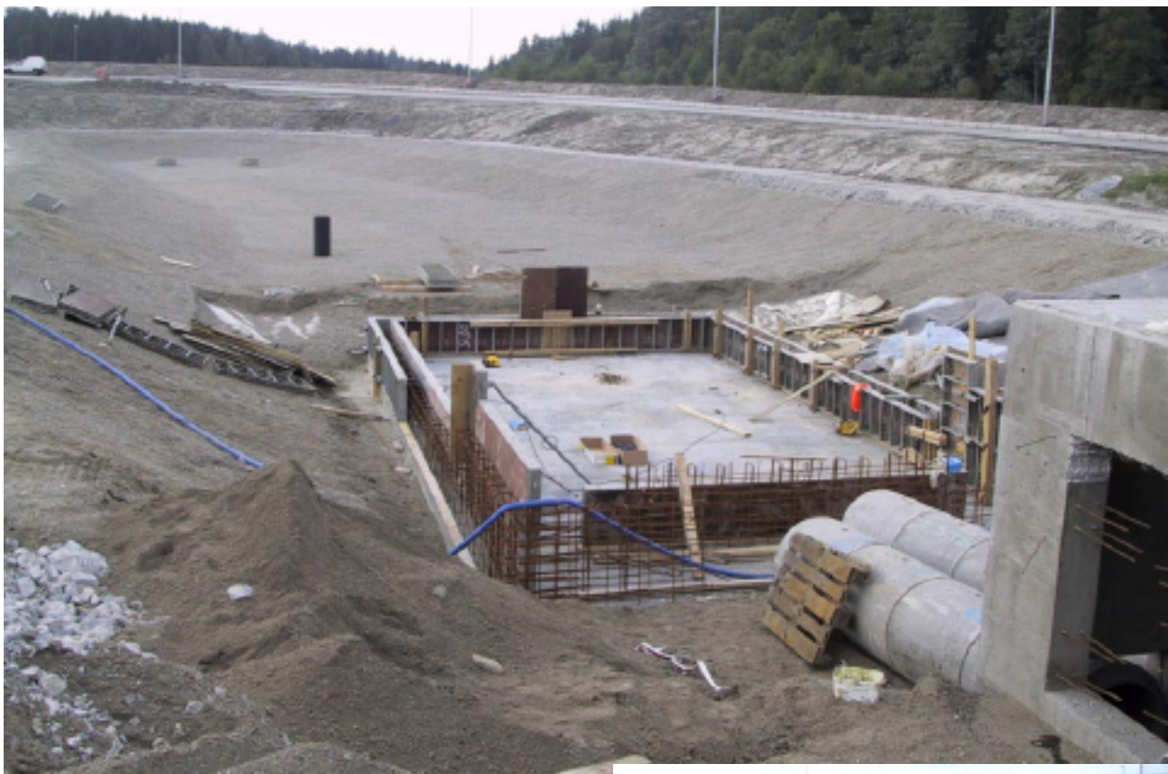
Figur 6.3.4.2. Vått overvannsbasseng under bygging i et kryssområde på E6 i Akershus. Slamdelen (forbehandlingen) er integrert i hovedbassenget og bygges med betongplate på bunnen for å lette slamfjerningen.
