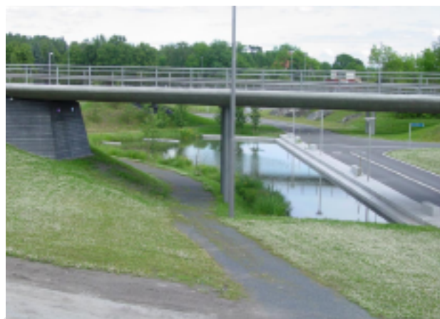
Figur 6.3.4.4. Et vått overvannsbasseng innpasset i et veganlegg på Fornebu, (Statsbygg, 2004).
