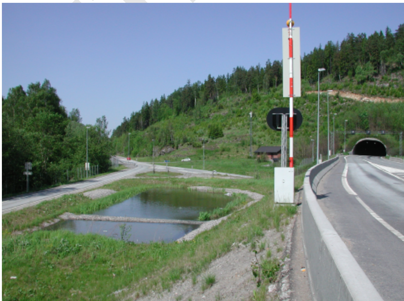
Figur 6.11. Basseng for rensing av vaskevann fra tunnel (E6 Vassum i Akershus).
