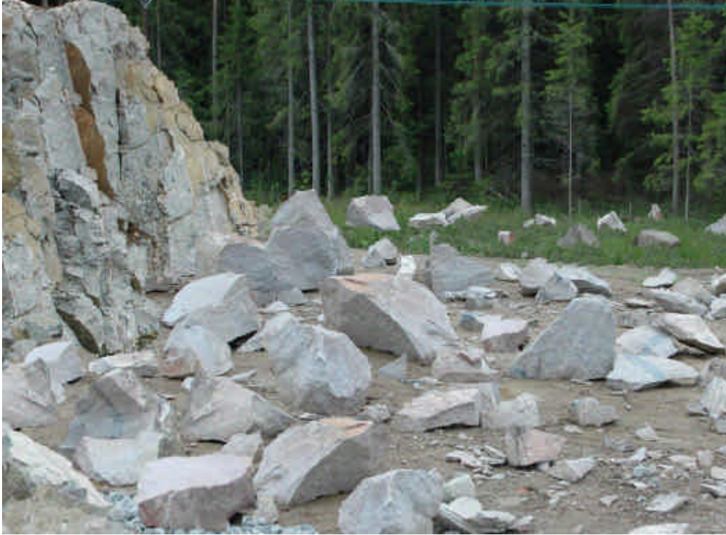
Oacceptabelt! Block och stenar får inte hamna utanför vägområdet.
