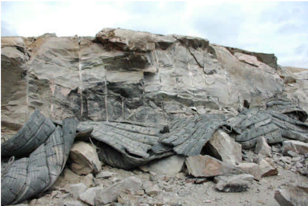
Bra! Täckning med mattor förhindrar block och sten att hamna utanför vägområdet.
