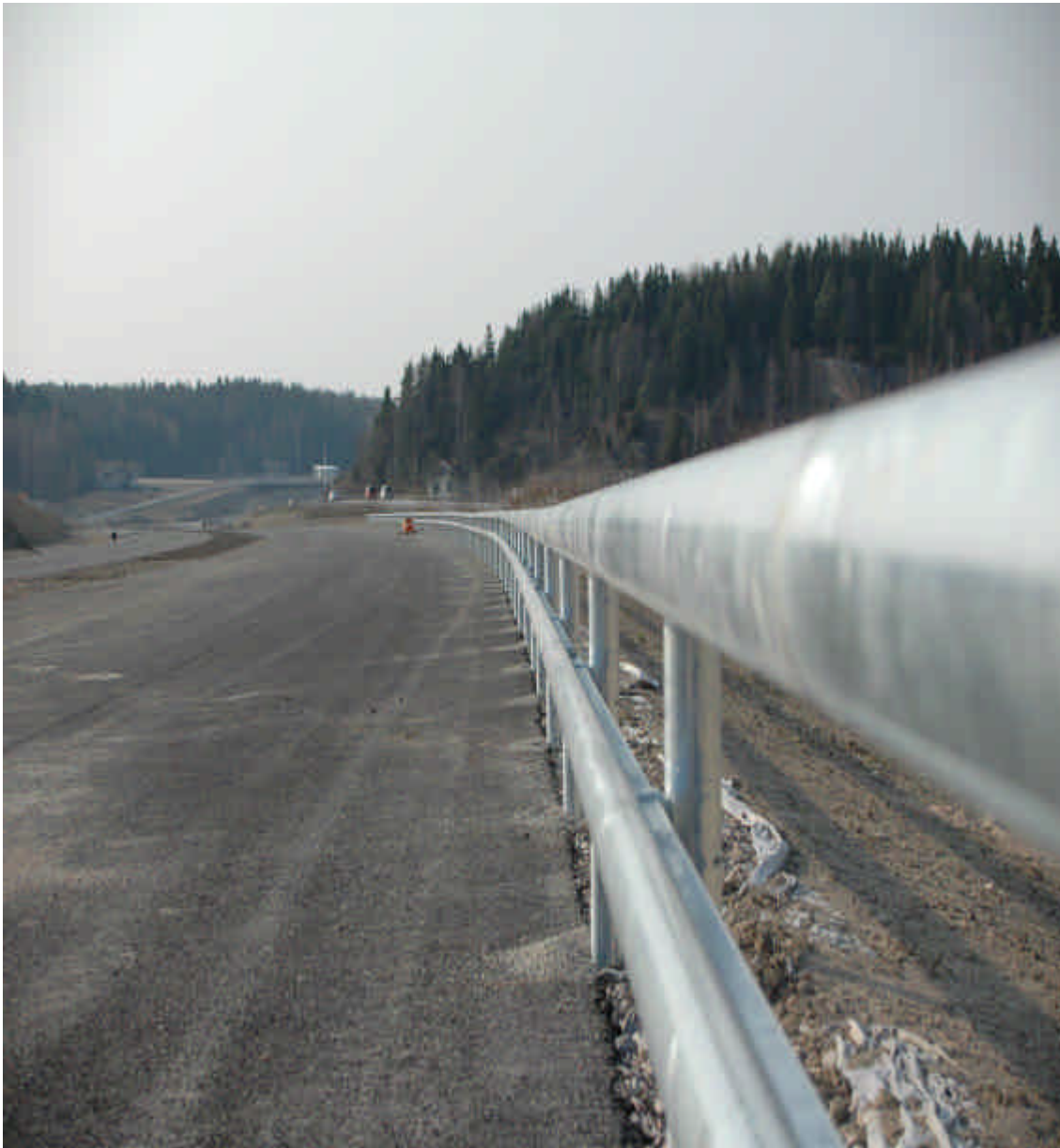
Ett välmonterat och skadefritt räcke blir signum för ett väl utfört arbete
