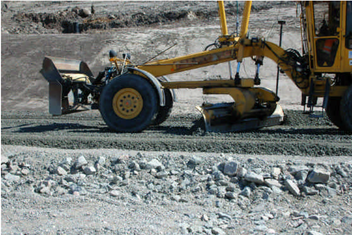
Bärlagret hyvlas och justeras till i höjd efter det att det har vattnats.
