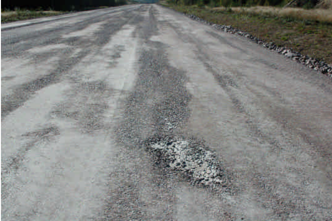
Separation och slaghål!
