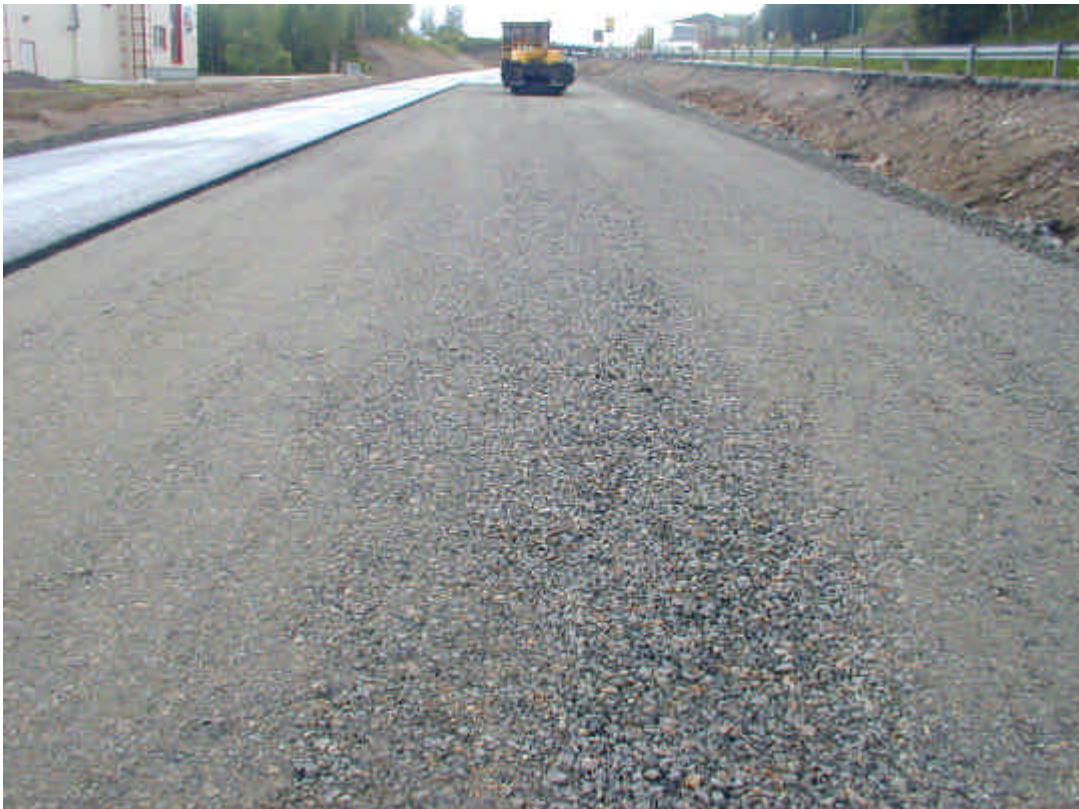
Se upp! Antydning till mittseparation.
