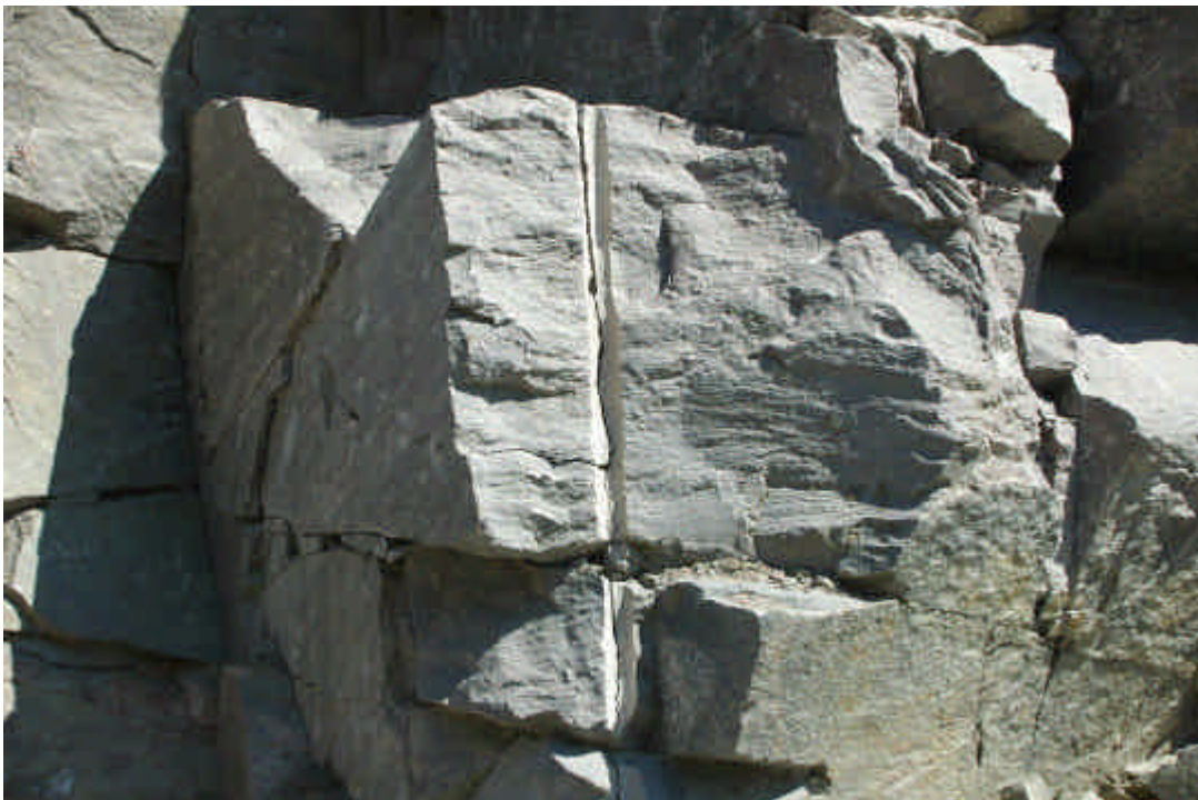
För hård laddning! Grövre borrhål ger mer koncentrerat sprängämne vilket ger mer stenmjöl och fler mikrosprickor. Den kvarvarande slänten förstörs med framtida underhållsproblem.
