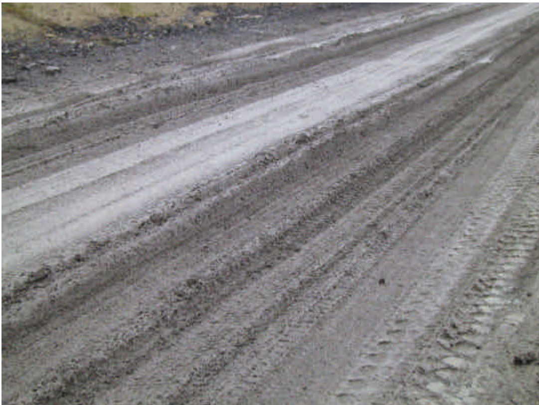
Sönderkört bärlager! Ett färdigpackat bärlager bör helst inte trafikeras under byggnadstiden. Undvik även att vattna bärlager som läggs ut under den kalla årstiden. Det obundna materialet torkar inte upp.
