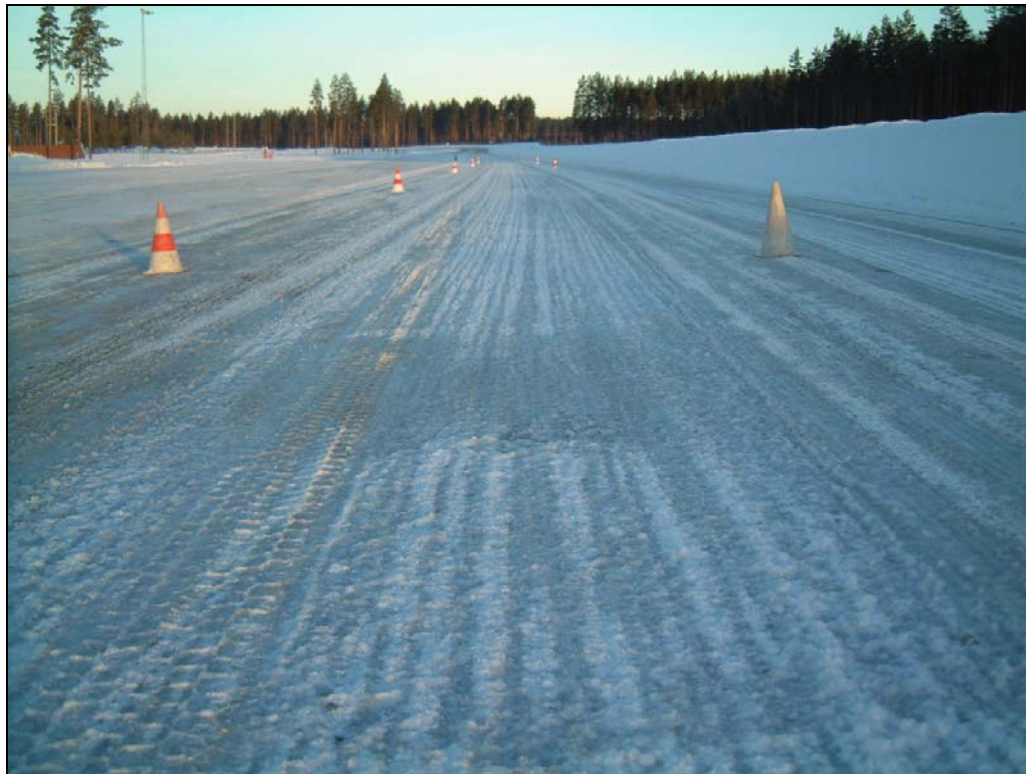
Figur 2.6: Ringbanen etter høvling og vanning, bane 6 (bane 5 til høyre)
