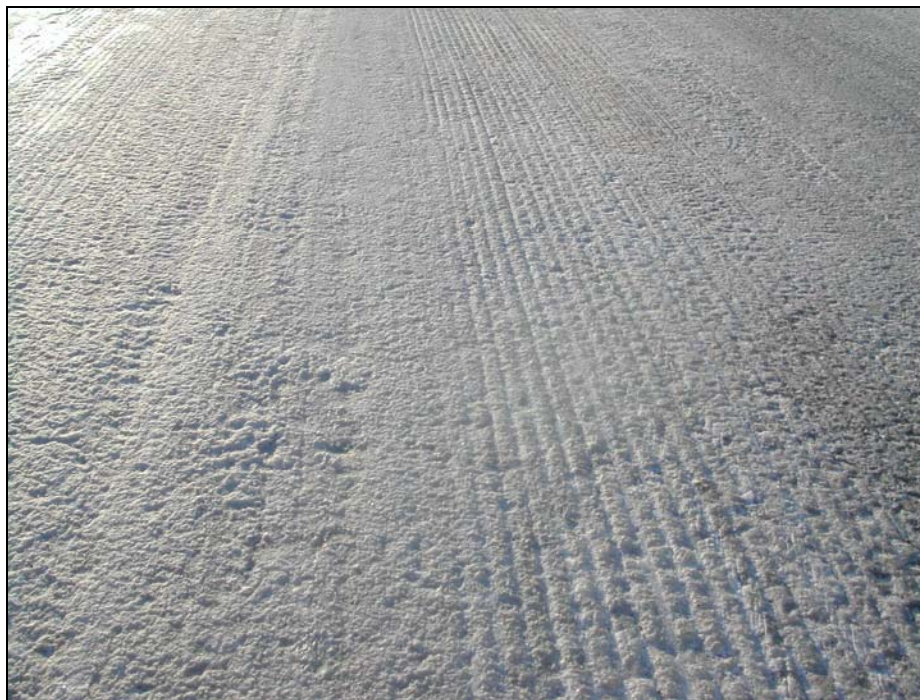
Figur 2.5: Vegbane etter preparering med høvelskjær og kosting
