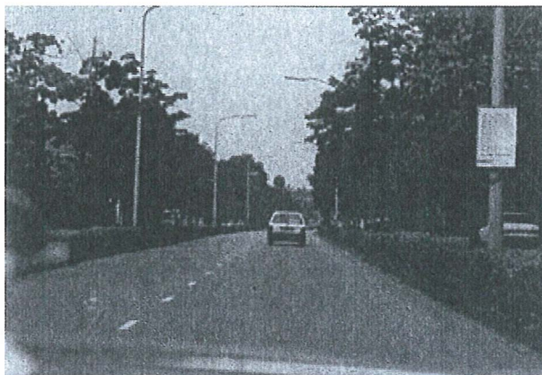
Boulevardløsning i Nederland. Bildet viser hovedvegen med parallelle enveiskjørt adkomstgater på sidene.
