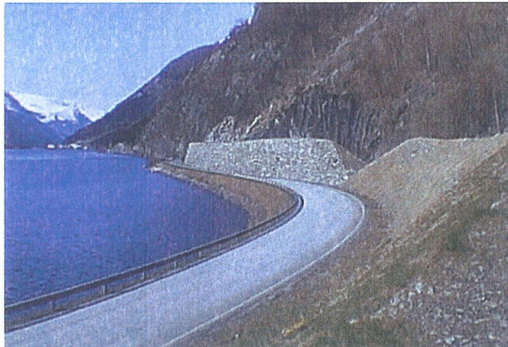
Støttemur som fremstår som "land art". Denne muren gir gjennom sin form og kontrast en opplevelse i seg selv. Foto Norsk Form
