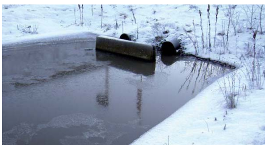
Figur 7-3 Sedimentasjonsbasseng
