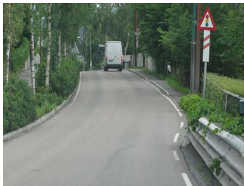
Figur 7-5 Ikke alle omkjøringsveger har tilfredsstillende standard. Her for Granfosstunnelen
