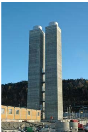
Figur 7-2 Ventilasjonstårn i Bjørvika
