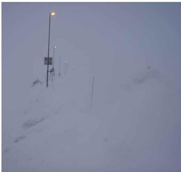
Figur 8-4 Vegbelysning på Haukelifjell under uvær. Foto: Harald Norem)
