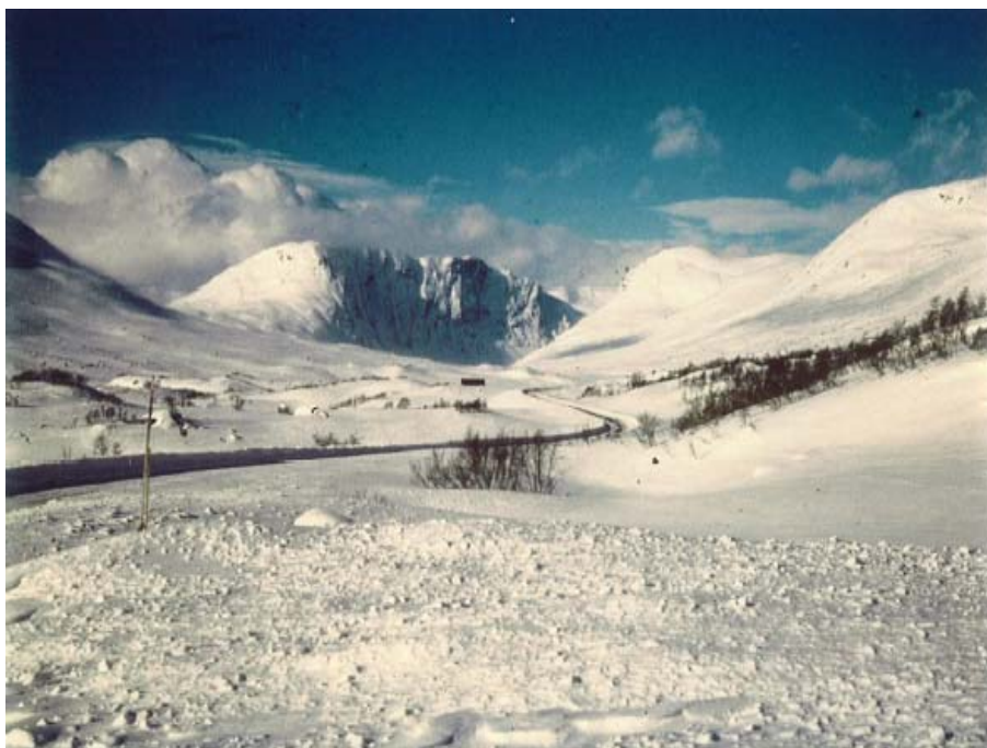
Figur 4-4 Foto av Rv 15, Strynefjellsvegen, vest for Hamseviki. Vindstyrkene er større på ryggen der bildet er tatt og i utkurven ved brøytestasjonen enn i innkurven hvor det vokser skog. (Foto: Harald Norem)
