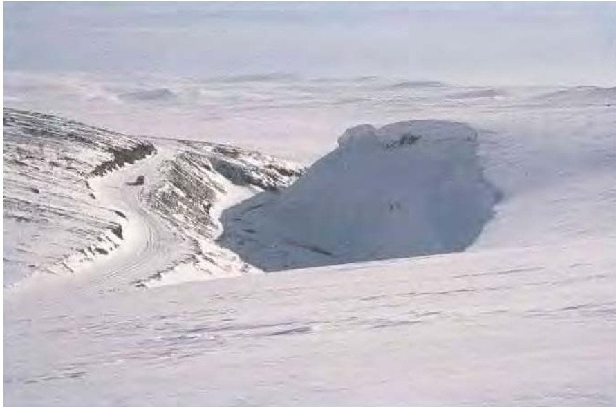
Figur 4-5 Vegen bør plasseres på le side av terrengdetaljer som fører til fonndannelse, men utenfor selve fonnområdet. (Foto: Harald Norem)
