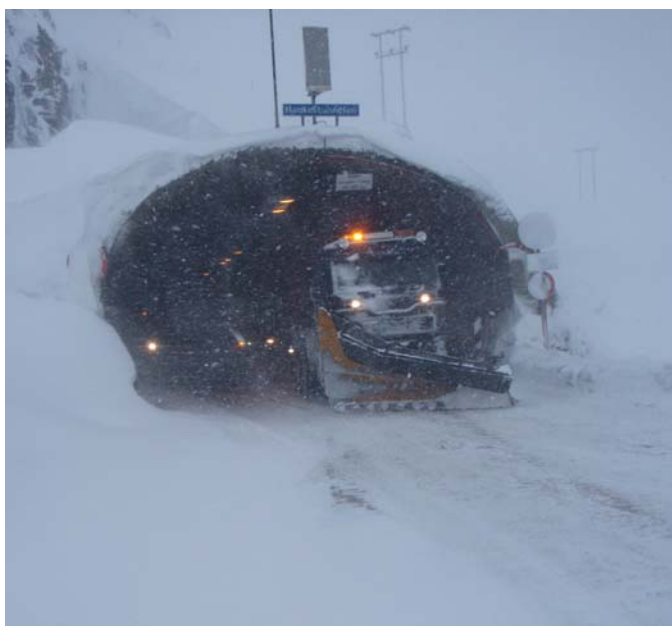
Figur 8-1 På Haukelifjell er det fire tunneler som er tilrettelagt for kolonneoppstilling. Ofte er været dårlig kun på den ene siden av fjellet - da er det effektivt å kunne kjøre kolonner mellom to tunneler kun på den vanskelige siden av fjellet. (Foto: Harald Norem)
