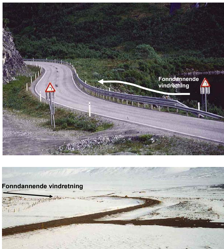
Figur 6-3 Eksempler på veger hvor lokale forhold fører til at det er nødvendig å bruke spesialmaskiner over korte strekninger for å holde vegene åpne. (Foto: Harald Norem)
