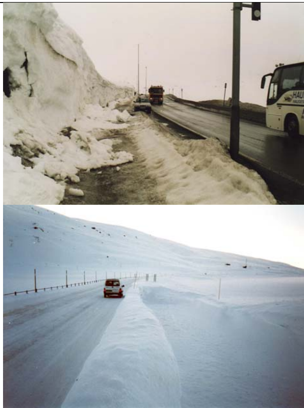
Figur 5-2 Fotografier som viser eksempler på fresfelt under vinterforhold. Venstre: Et fresfelt under høy fjellskjæring på Haukelifjellet. Høyre: Et fresfelt på utsiden av rekkverket der vegen krysser vann på Strynefjellet. (Foto:?)
