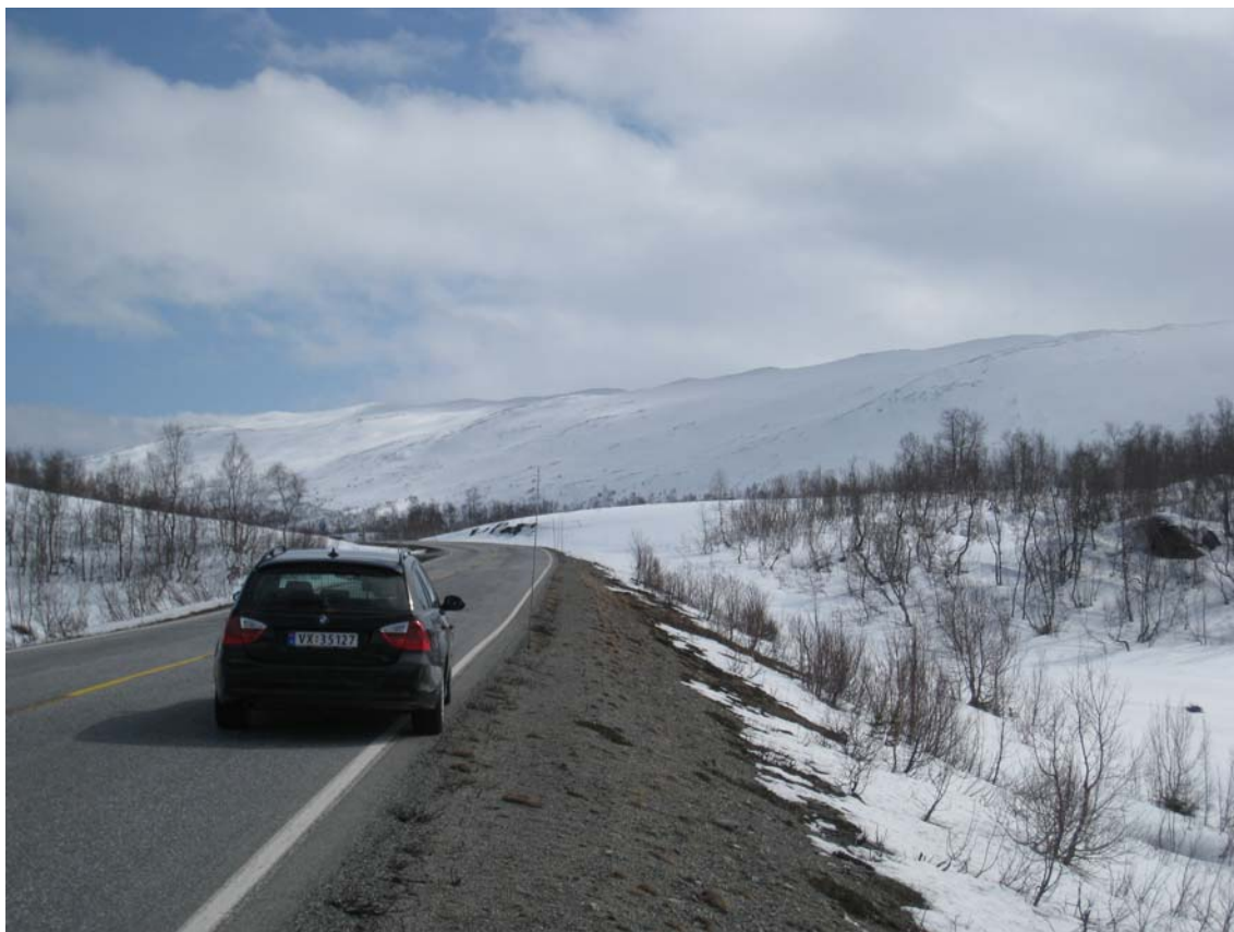
Figur 5-13 Et eksempel på overgangssone mellom skjæring og fylling, der hvor mye snø driver inn på vegen. Bildet er tatt ved Grotli på rv 15, Strynefjellsvegen, (Foto: Skuli Thordarson).
