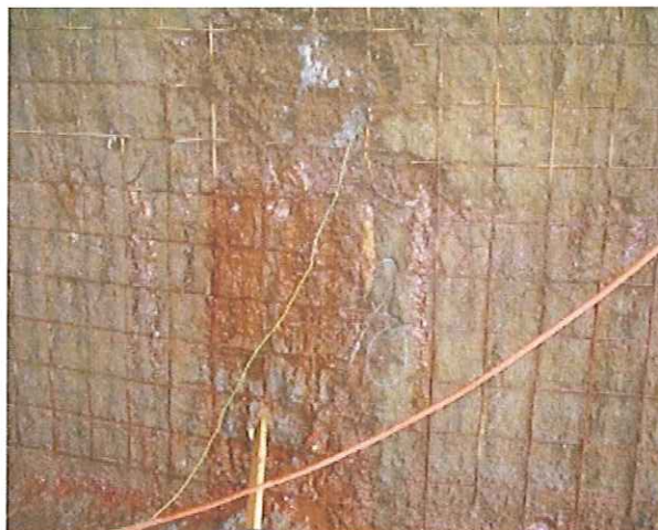
Foto nr. 4: Nærbilde av armeringsnett innsprøytet med cellulosemasse.
