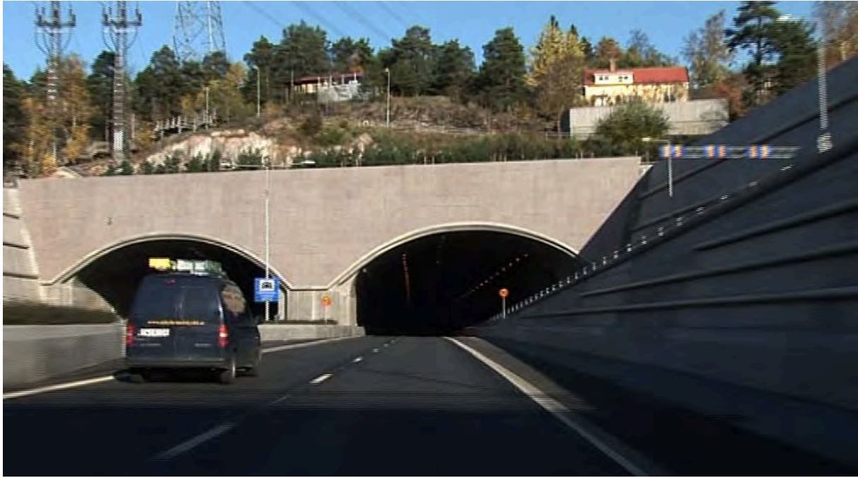
Törnskogstunneln infarten från Häggvikshållet. Här ser man hur nära tunnelmynningen som tunnelskylten är placerad.
