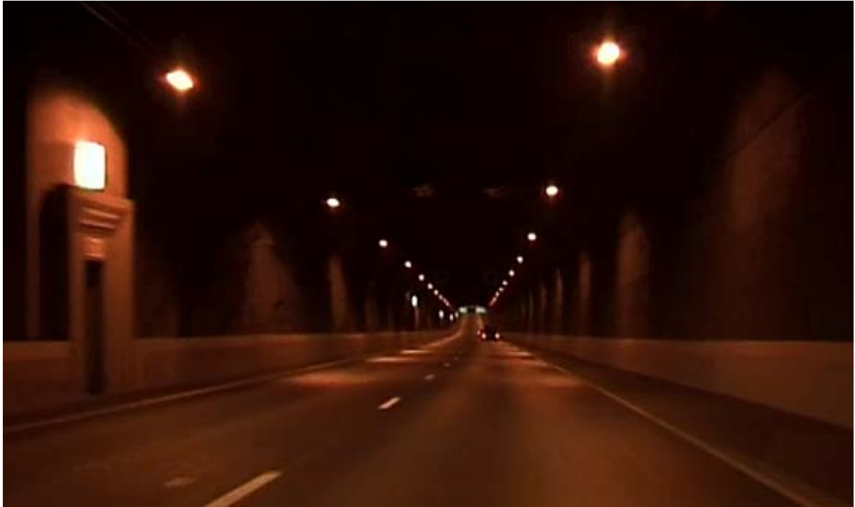
Törnskogstunneln, en mörk bergtunnel, till vänster ser man en nödutgång.
