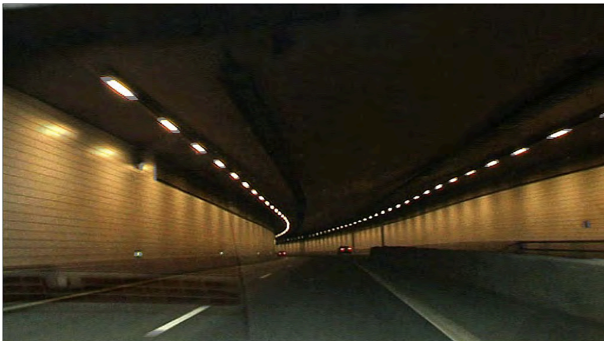
Götatunneln från tunnelmynningen från nordost, med svart tak och ljusa klinkerklädda väggar.
