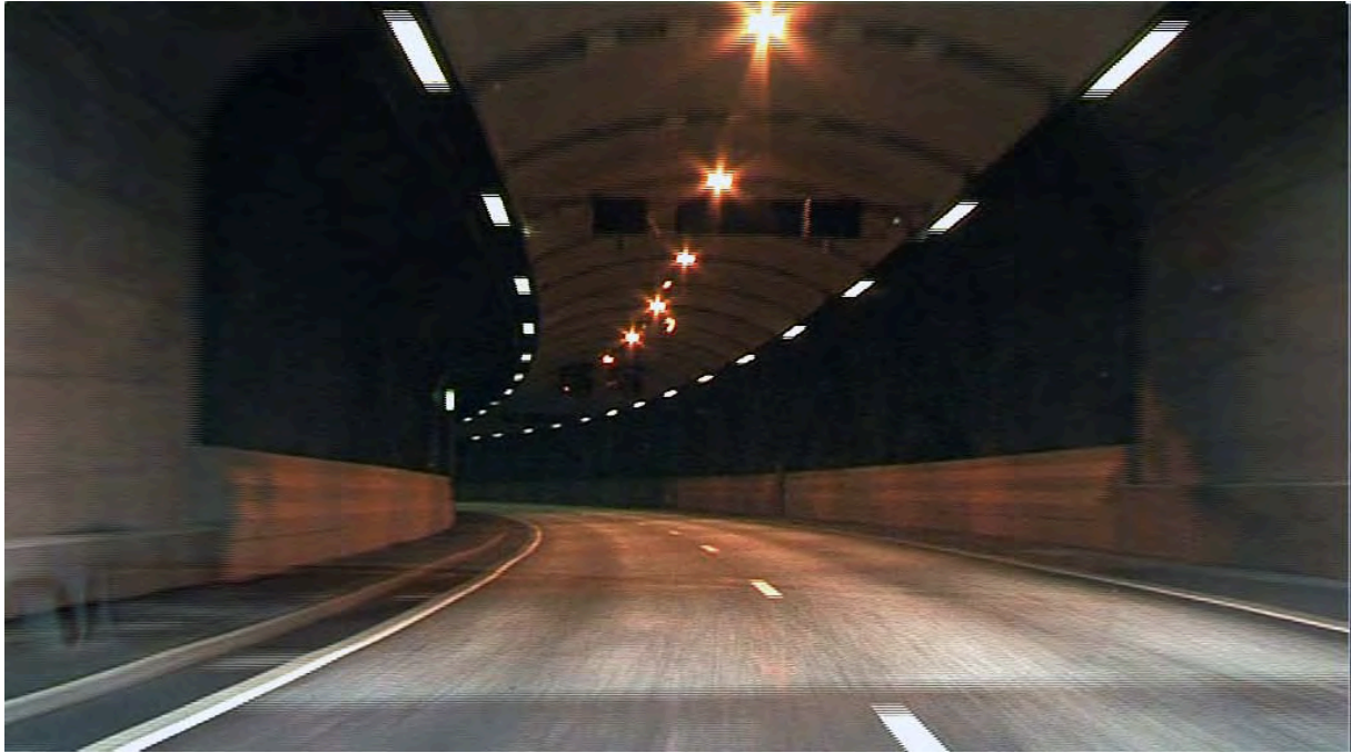
Extra upplyst sträcka vid infarten från Nacka, längre fram skymtar det karaktäristiska tunnelutseendet i Södra Länken med bågformade takelement och belysning i ytterkanten.
