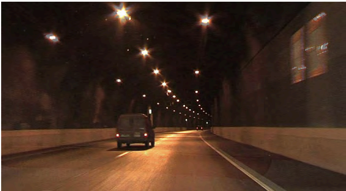
Inne i Törnskogstunneln, belysningen i mittraden upphör längre fram. Det är vid infarten som belysningen är förstärkt.
