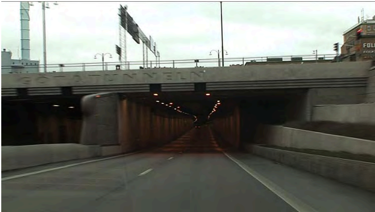
Götatunnelns infart från Järntorget.
