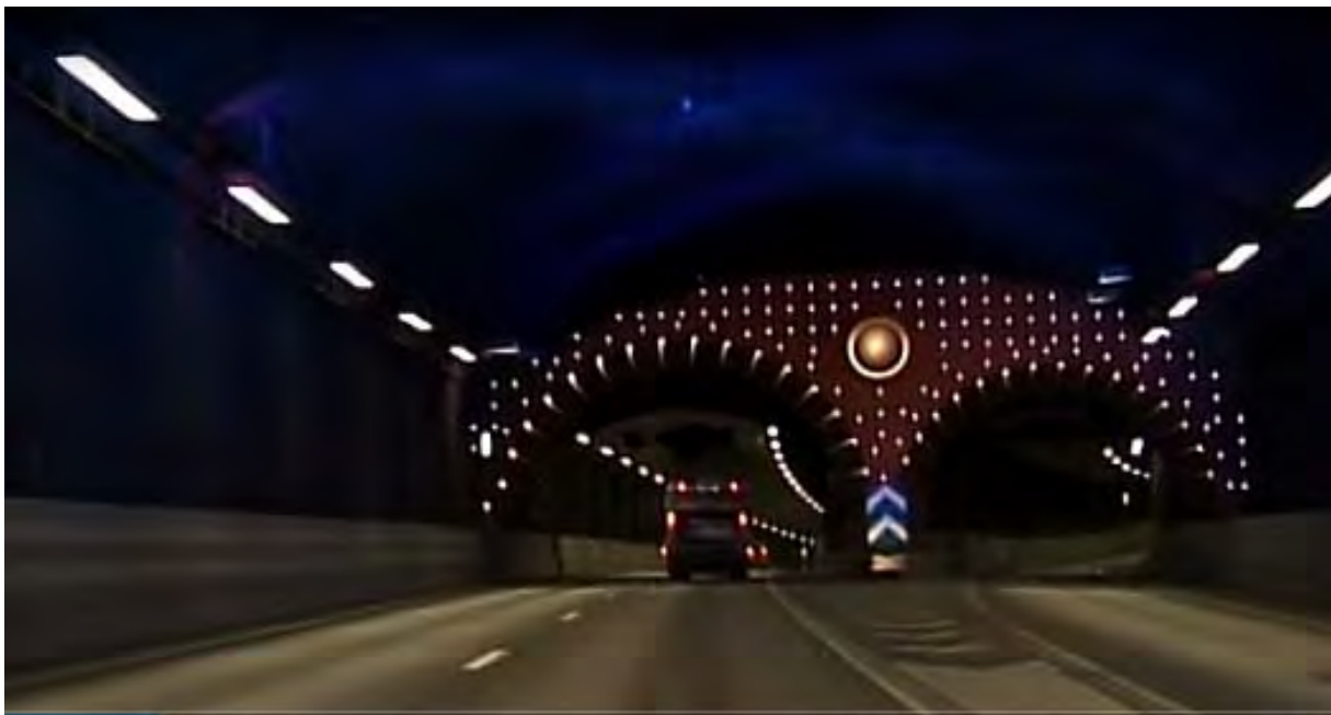
Södra Länken, en av de konstnärligt utformade bergrummen där vägen delar sig.
