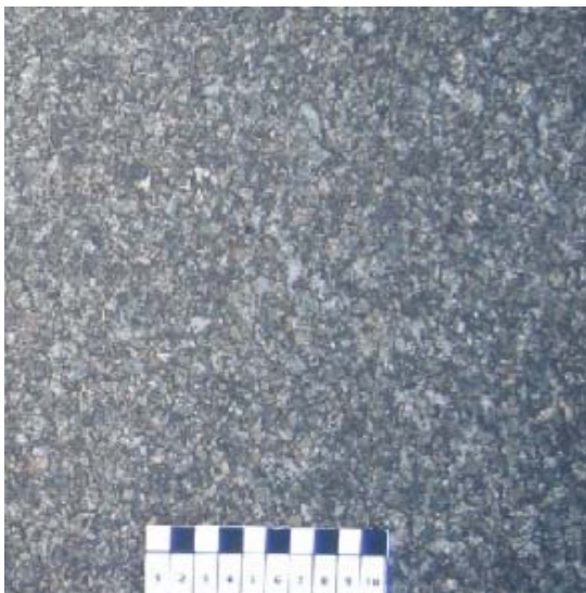
Figur 3 Ska8-dekket i 28 februar 2006
