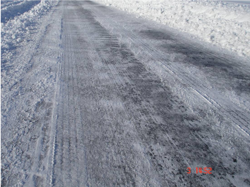
Overfart 1, Jetbroom (bare en overfart)
