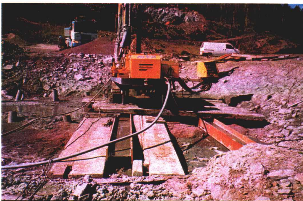
Bilde 5 Forsterkning av byggegrop med ståldragere
