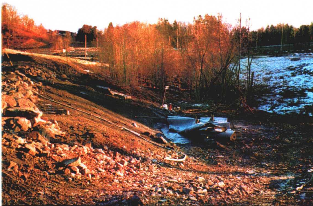
Bilde 2 Byggegrope i 6 vest etter at arbeidene var stanset
