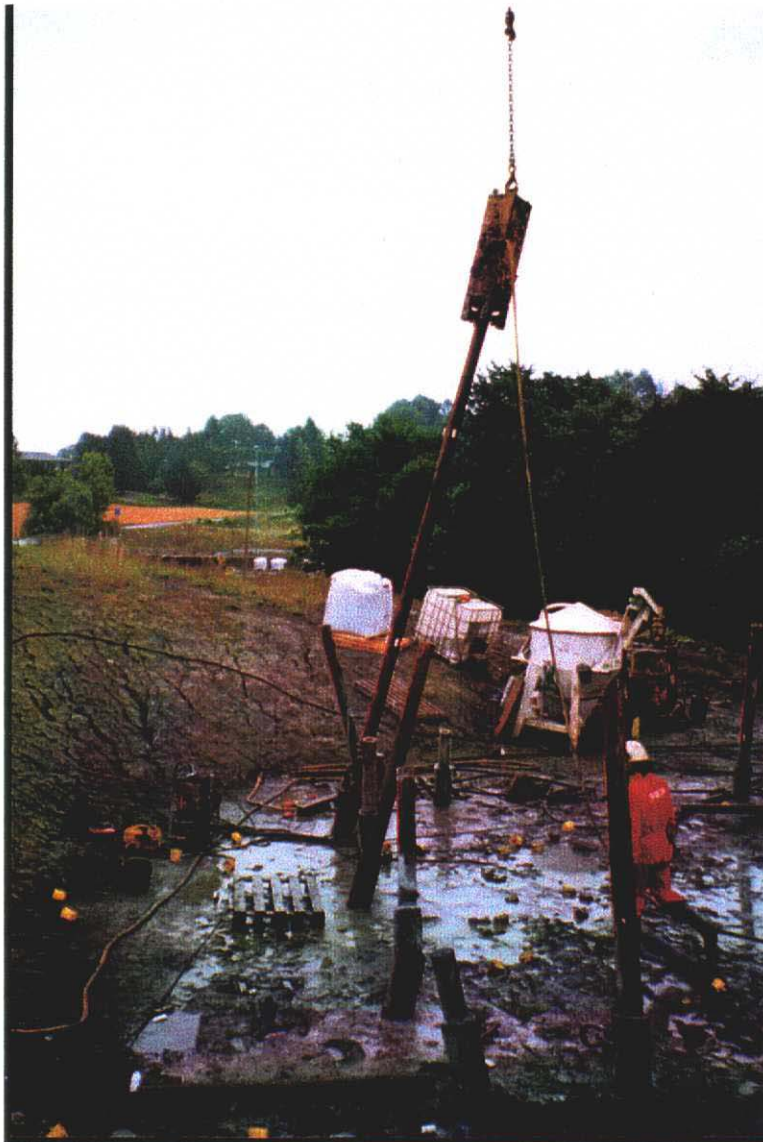
Bilde 8 Banking på pel med luftlodd (fra akse 6 øst)
