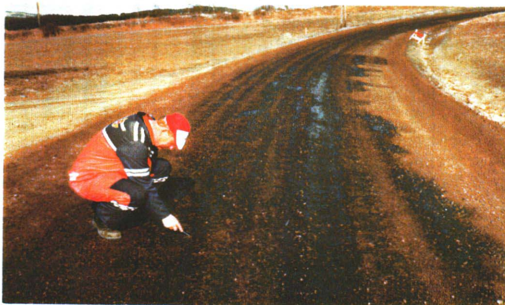
Veg påført Dustex
