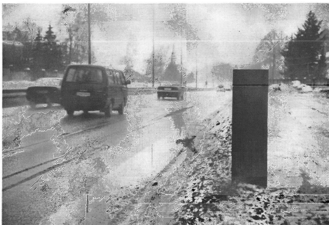
Figur 3 Skilt dekket av sølesprut fra trafikken
