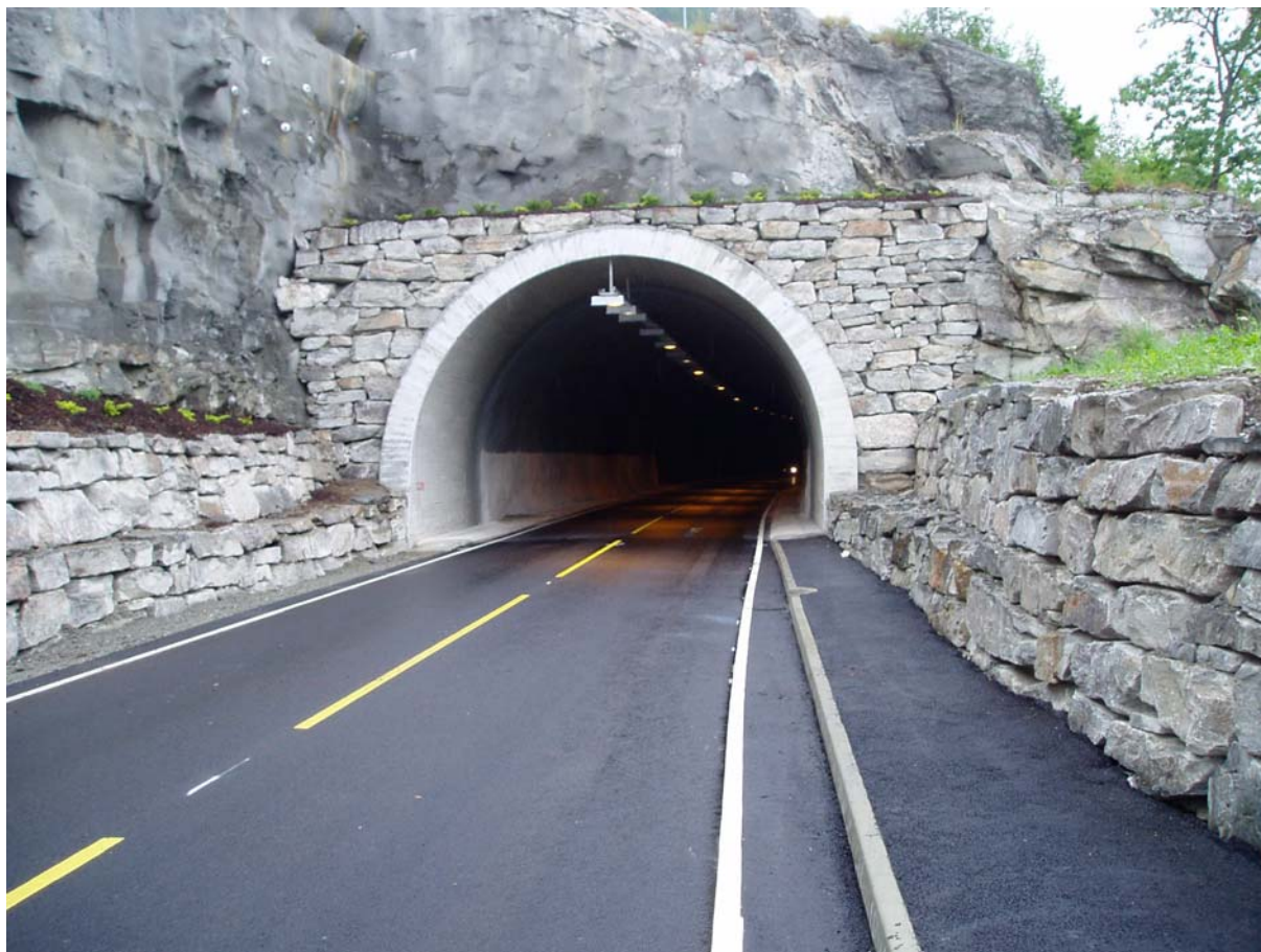
Foto nr. 2 Agatunnelen tunnelportal SØR
