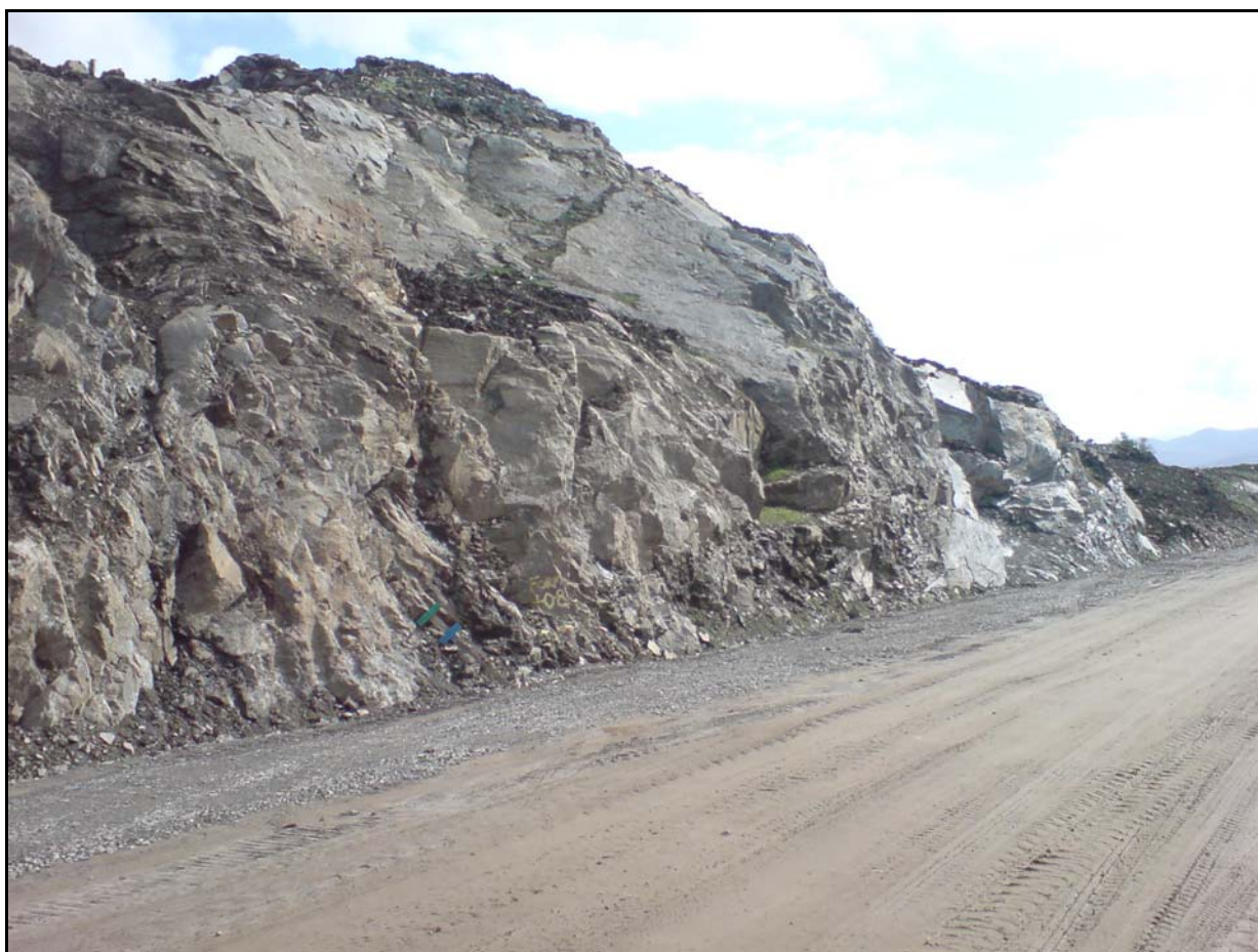
Naturlig revegetering - Jord legges tilbake for raskt å dekke fjellet med stedegen vegetasjon.
