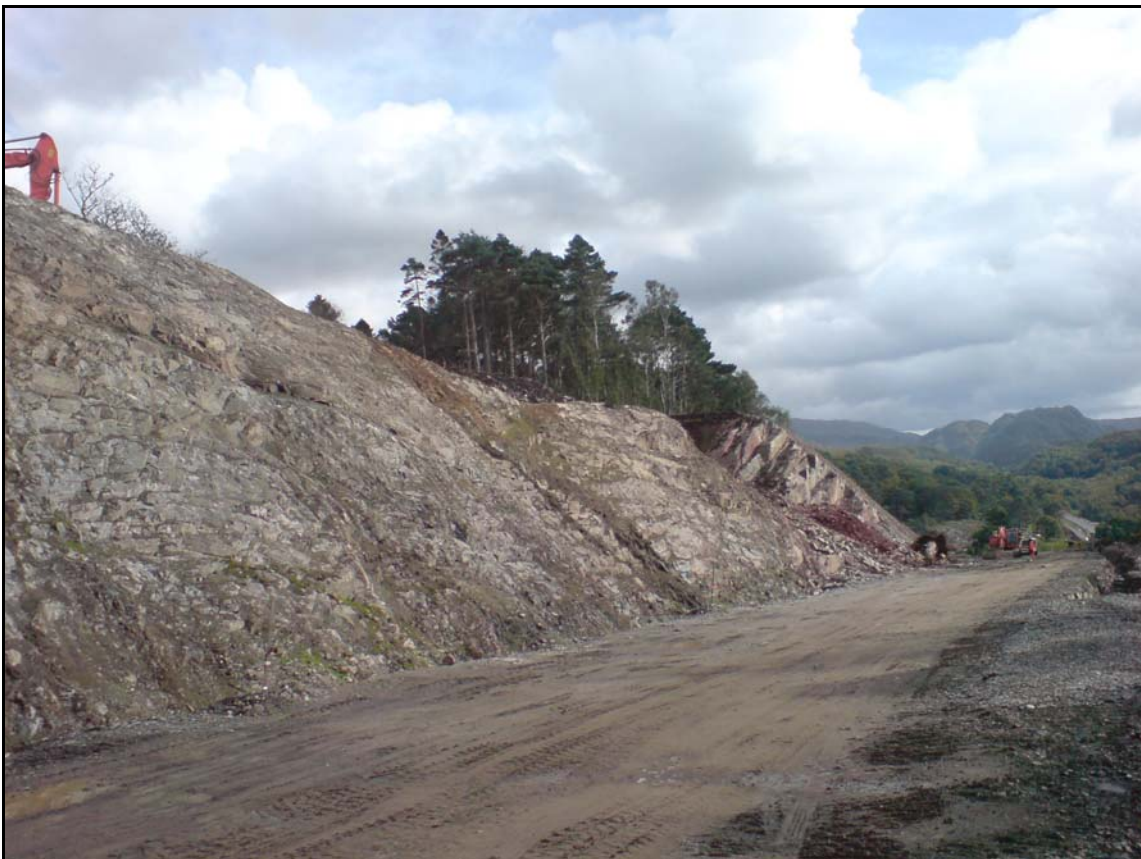
Helning på fjellskjæring er slakere enn vi tradisjonelt bruker i Norge.
