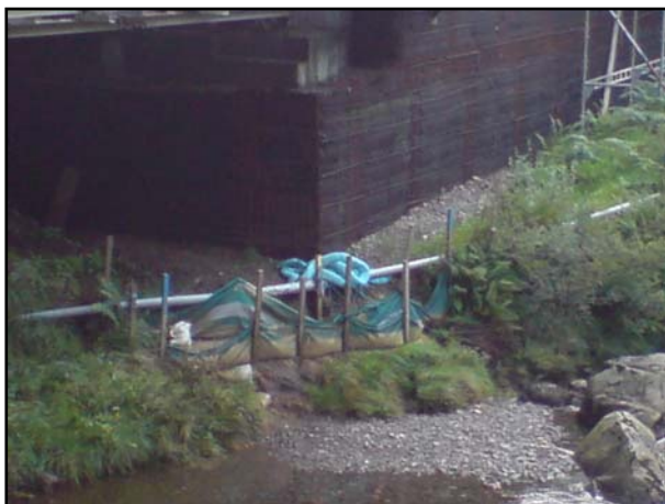
Sikring mot forurensing til vann fra bru og vegbygging
