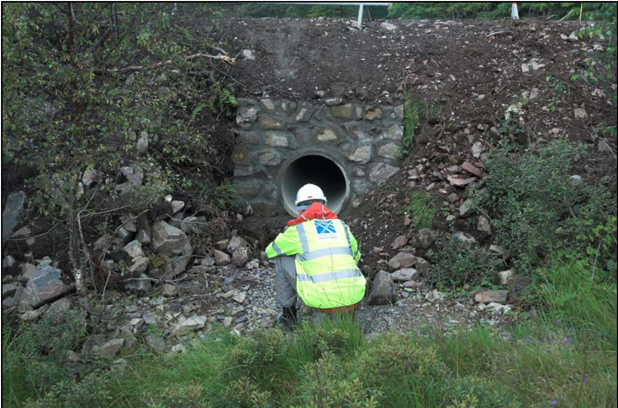
Dyretråkk ble tatt hensyn til ved plassering av viltgjennomganger/ rør under vegen.
