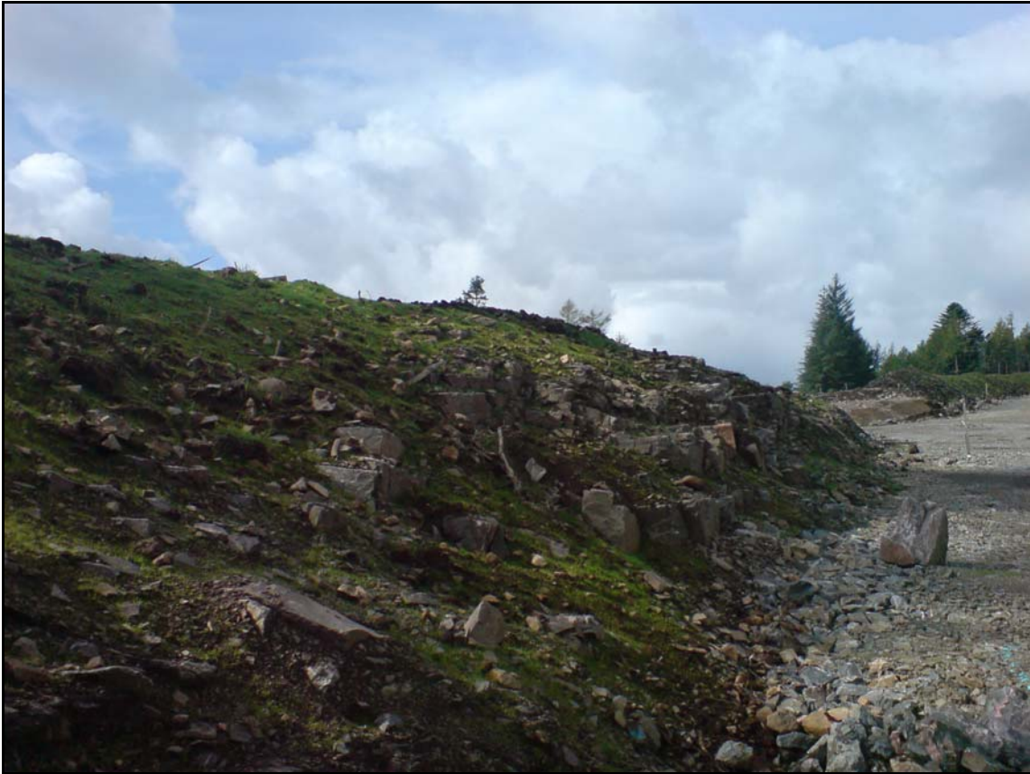
Naturlig revegetering - Jord legges tilbake for raskt å dekke fjellet med stedegen vegetasjon.
