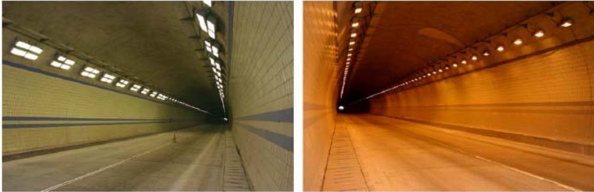
Bilde 23 Tunnelbelysning i kinesiske tunneler er velutviklet og ENØK relatert. Flis på veggene.
