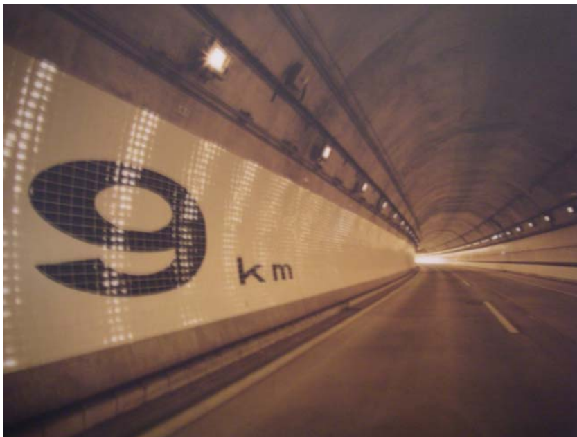
Bilde 56 Det brukes mye flis på veggene
