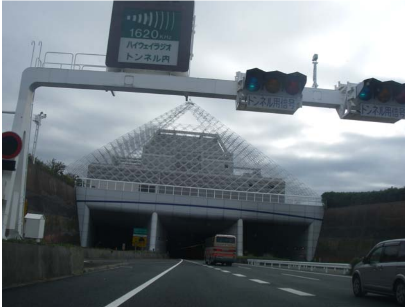
Bilde 55 Tunnelportal i uvant form
