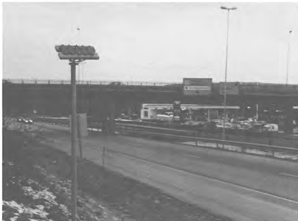
Figur 9 Rigg for måling av atmosfærisk korrosjon, Rv159 ved "Metro forretningscenter"
