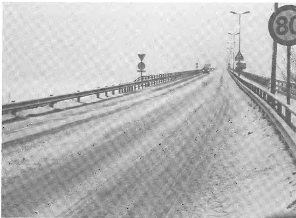
Figur 16 Mjøsbrua etter snøvær
