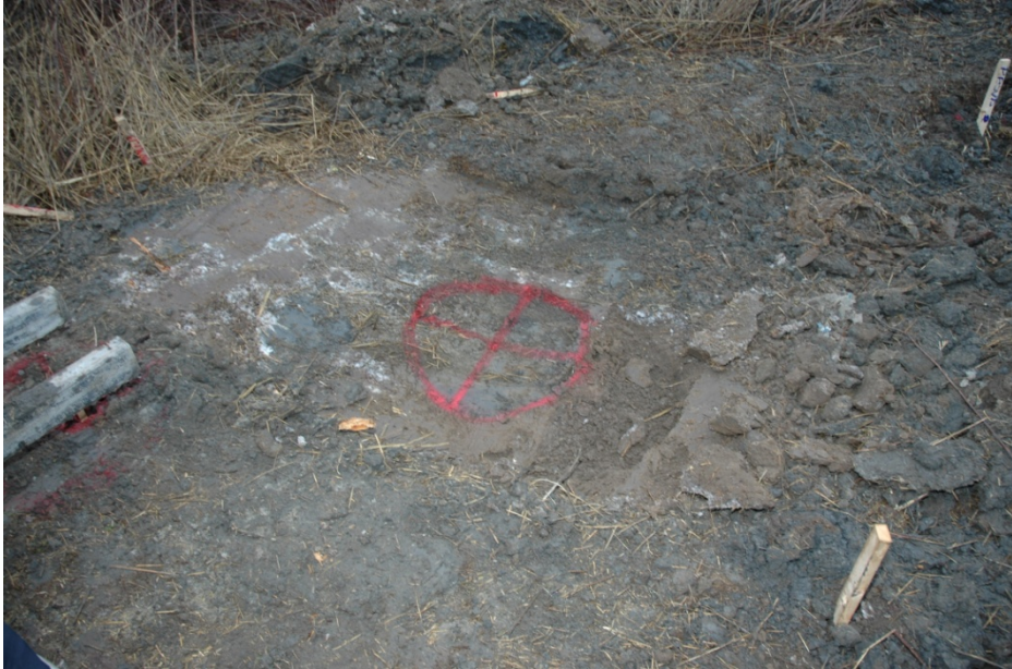
Bildet viser avgravid topp pel og markering av senter pel
