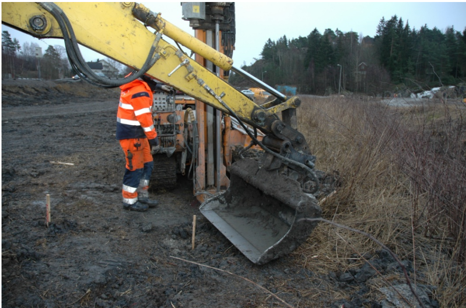
Bruk av gravemaskin som motvekt på fotbjelkene for bortårnet
