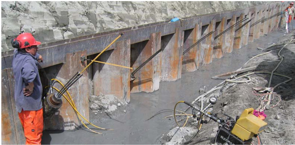
Figur 17 Oppspenning av stag - Utstyr nivellerkikkert (helt til høyre), 2 stk tommestokker, jekk og måleur til jekk
