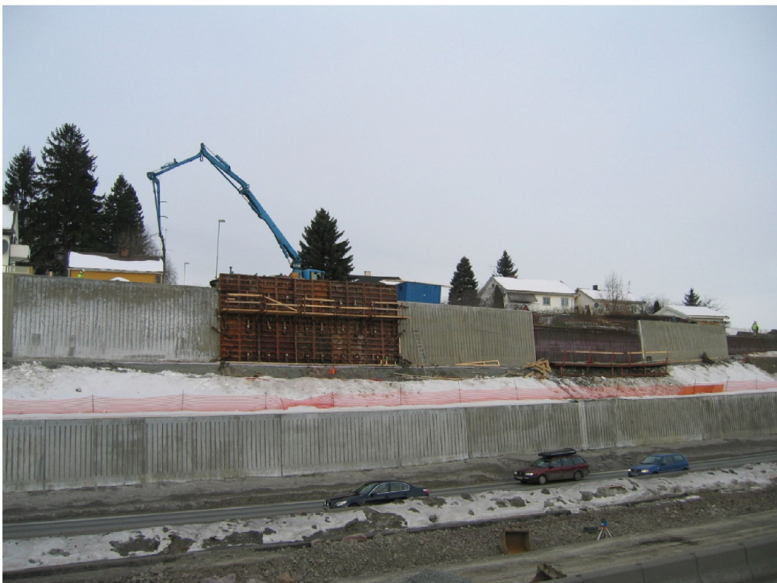
Figur 23 Mur 2 og 3 med betongkledning på
