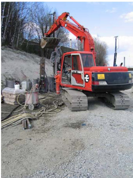
Figur 18 Gravemaskinen m/fallodd fikk nålene til fjell som ikke vibroloddet på 4 tonn greide!
