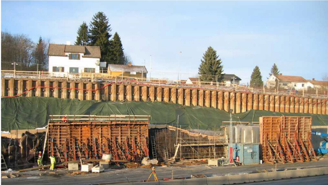
Figur 22 Spunt 3 øverst og mur 2 er under støping
