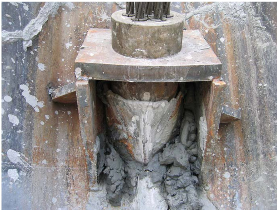
Figur 14 Ferdig montert fuglekasse med oppspente stag. Det presses noe leire ut i hullet mellom foringsrør og spunt.
