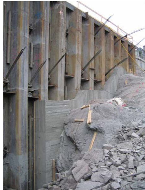
Figur 13 Tverrsnitt av fotbjelke på tegning og ferdig støpt ute på plassen – fotbjelken tilpasses fjellforløpet
