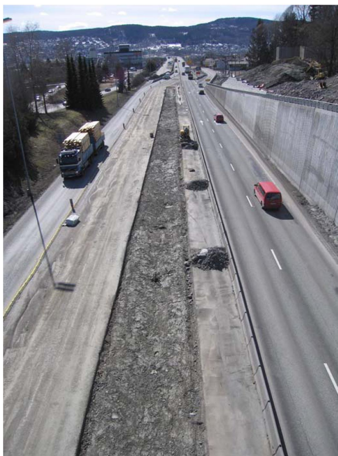
Figur 21 Oversikt over spunt 1 når det har blitt ferdig mur og motorveg
