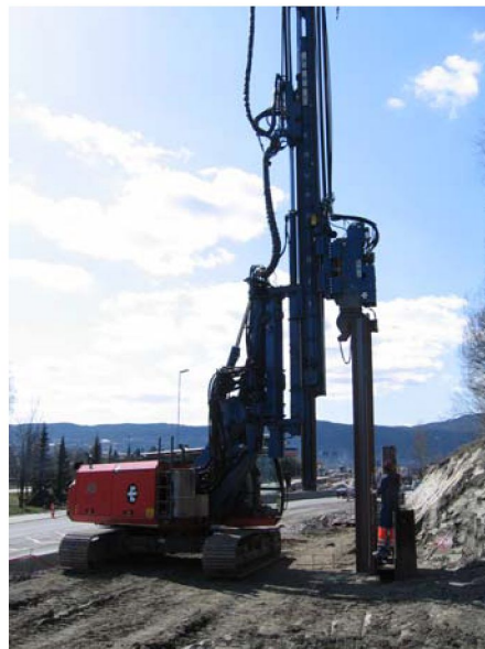
Figur 18 Gravemaskinen m/fallodd fikk nålene til fjell som ikke vibroloddet på 4 tonn greide!
