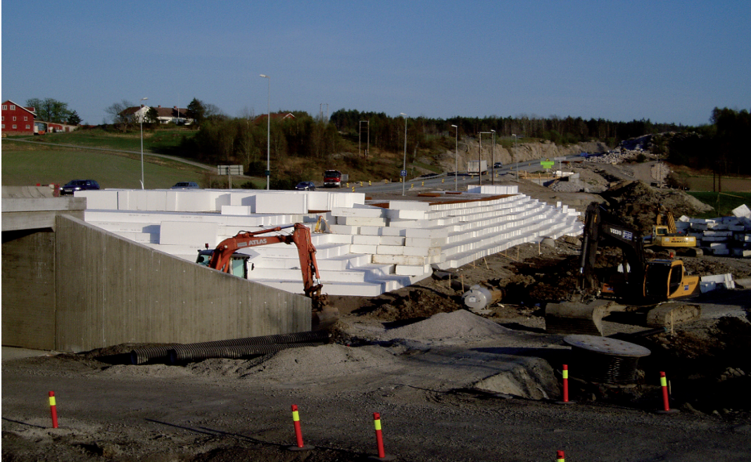
EPS-fylling ved Ingedal
