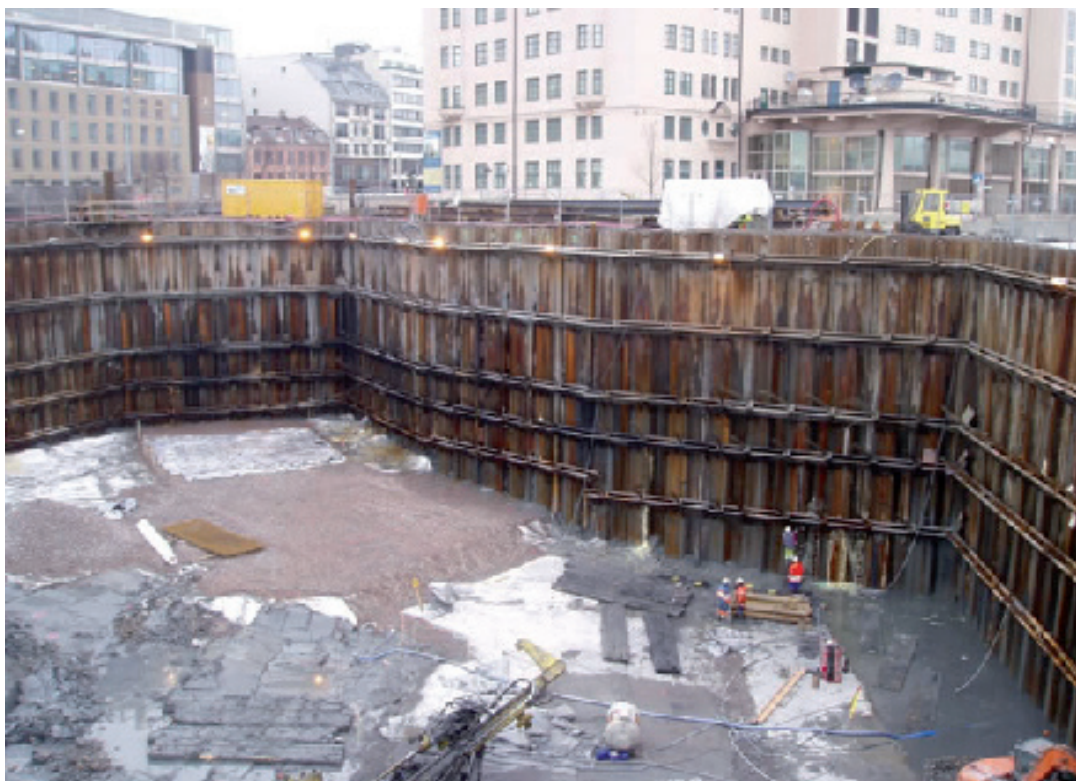
Utgravid byggegrop sett mot Havnelageret.
