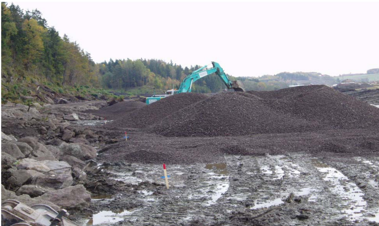
Bilde 1. Grusputa blir lagt ut, etter at topplaget av matjord er fjernet
