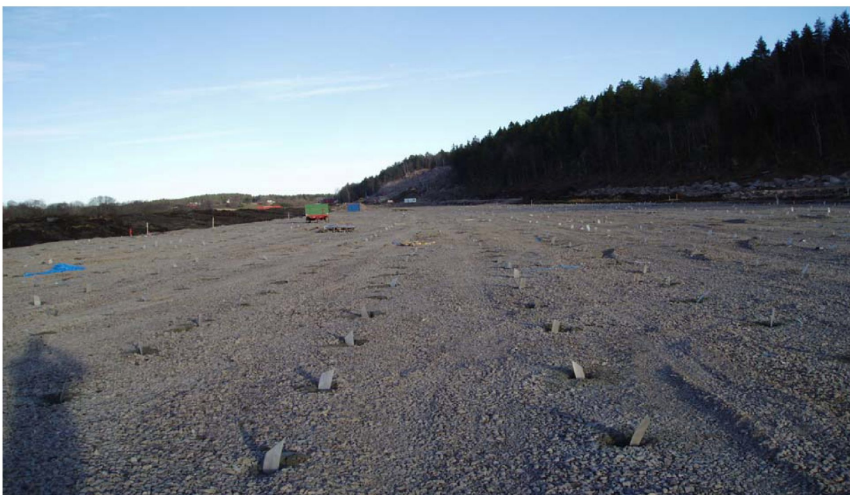
Bilde 3. Vertikale dren er ferdig installert i et rutenett på 2 x 2 meter. Drenene kappes jevnt med grusputas overflate eller helst noe over.
