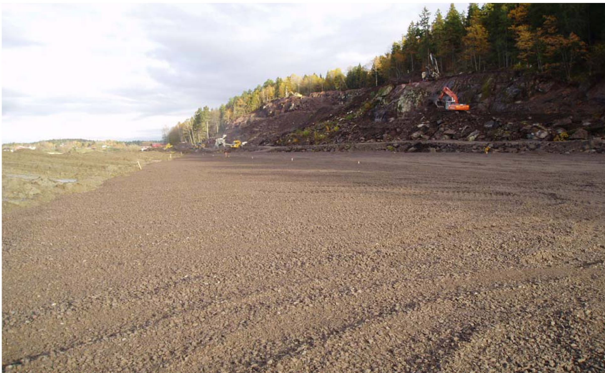
Bilde 2. Grusputa er ferdig lagt ut i området for vegfyllingen og støyvoll. Matjorden er lagt i ranker på utsiden av området for planlagt støyvoll
