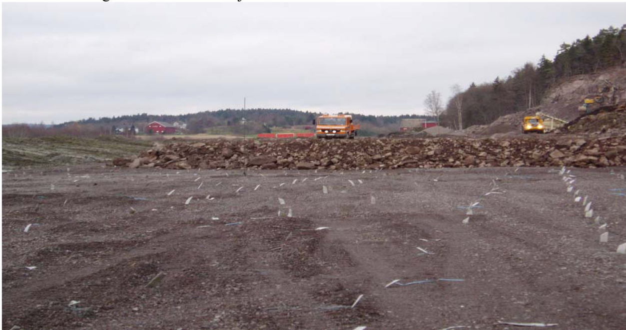
Bilde 4. Første oppfylling til 2 meter er lagt ut.
