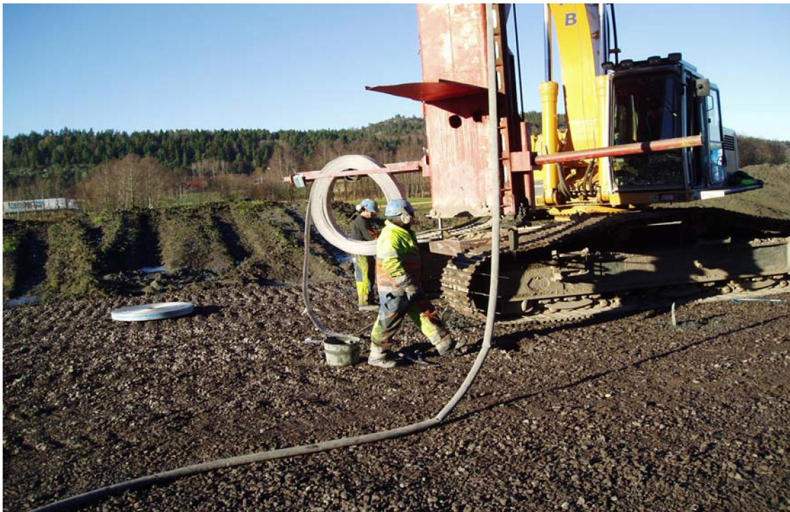
Bilde 6. Nedsetting av vertikale dren. Legg merke til vannslangen som er koblet til tårnet / drensstikka. Vannet blir brukt til spyling og rengjøring av drensstikka ved behov. I dette tilfellet ble vannspylingen også brukt for å få forankring av drenene i riktig dybde, på grunn av meget bløt kvikkleire.
