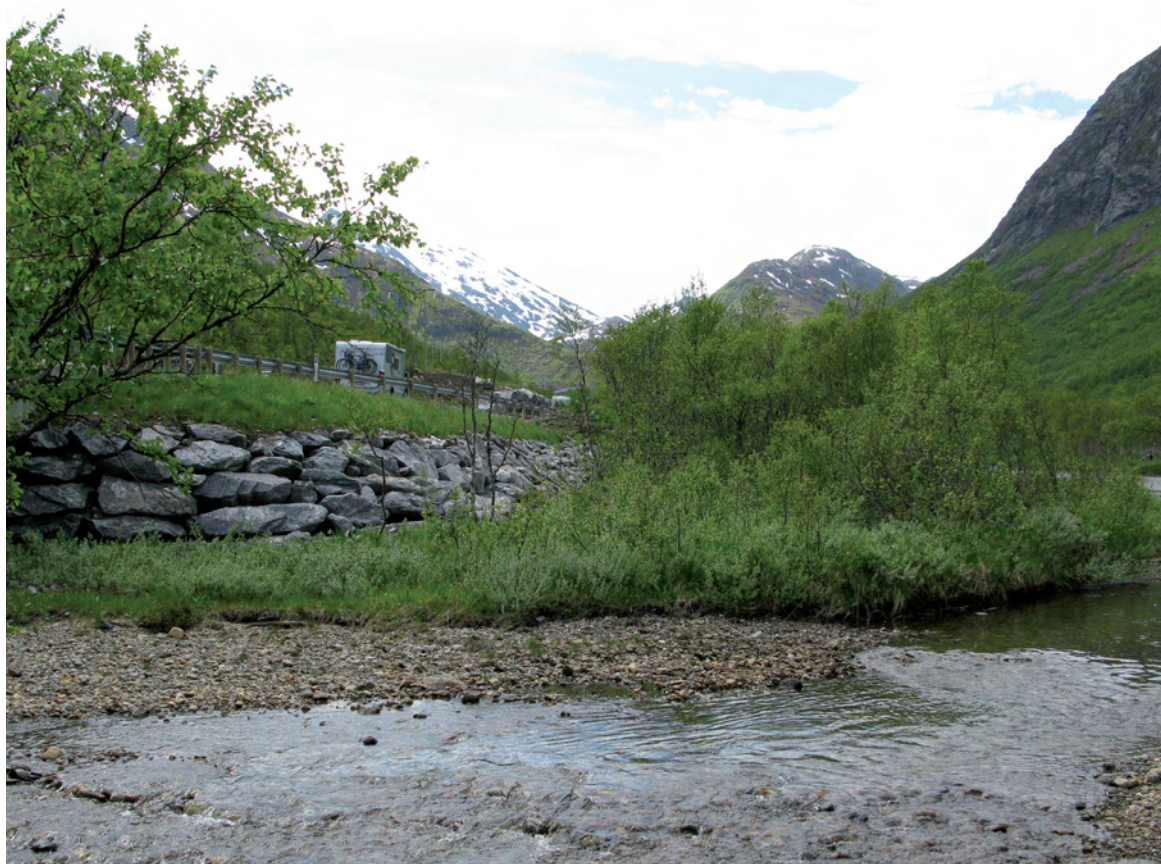
Figur 25: Sørtdalen er rasutsatt. Vegen må derfor krysse elva fire ganger. Rigg- og marksikringsplanen sørget for å bevare naturelementene så tett innpå vegen som mulig, og å unngå å berøre elvestrengen. Foto: Kongsbakk
