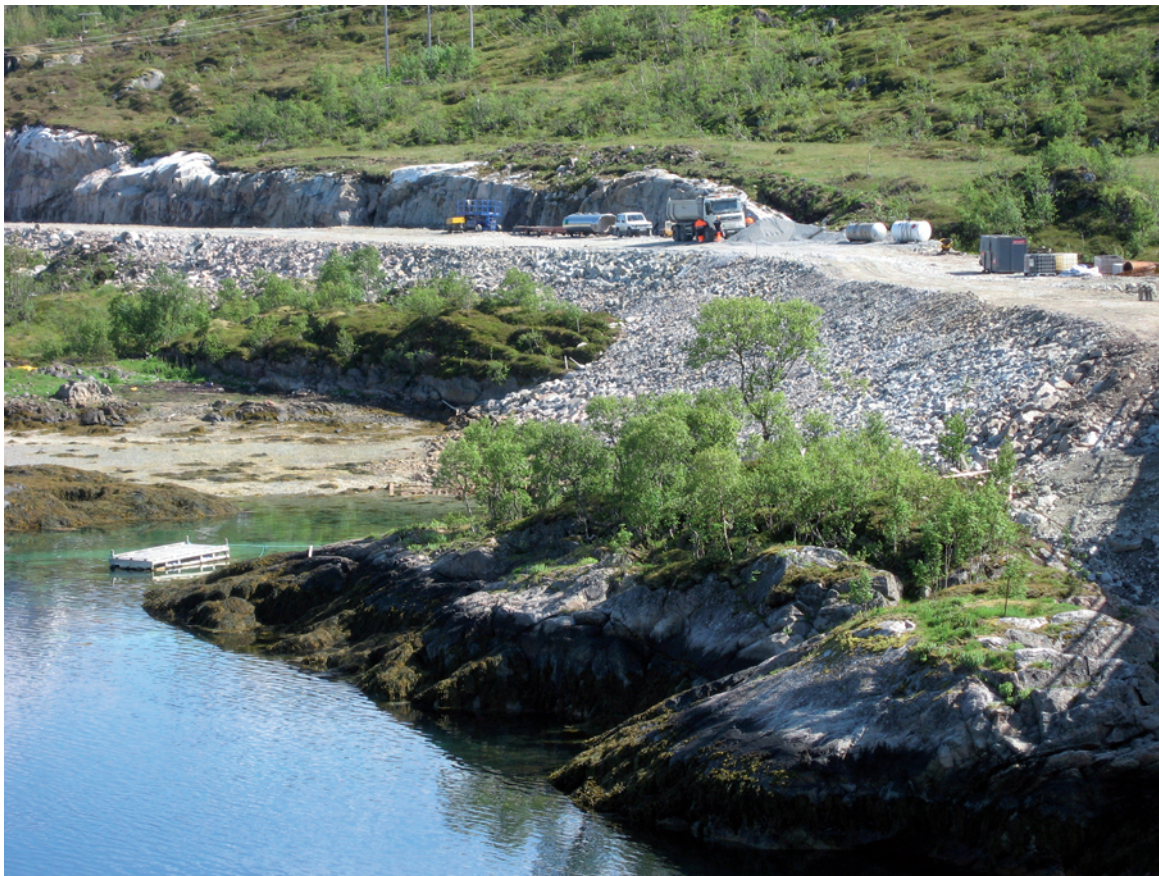
Figur 27: Selv små øyer av intakt natur bidrar til å forankre inngrepet til landskapet. Herfra kan også planter spre seg. Fra fyllingen fram mot landkar på Austerstraumen bru. Foto: Kongsbakk
