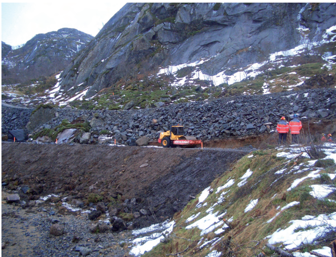
Figur 52: Det var ikke mulig å styre utlegging av vekstmasser bare til sommersesongen. Bratte fyllinger ble kledd parallelt med at de ble bygget opp til riktig høyde. Fra Svartskarvika. Foto: Kongsbakk
