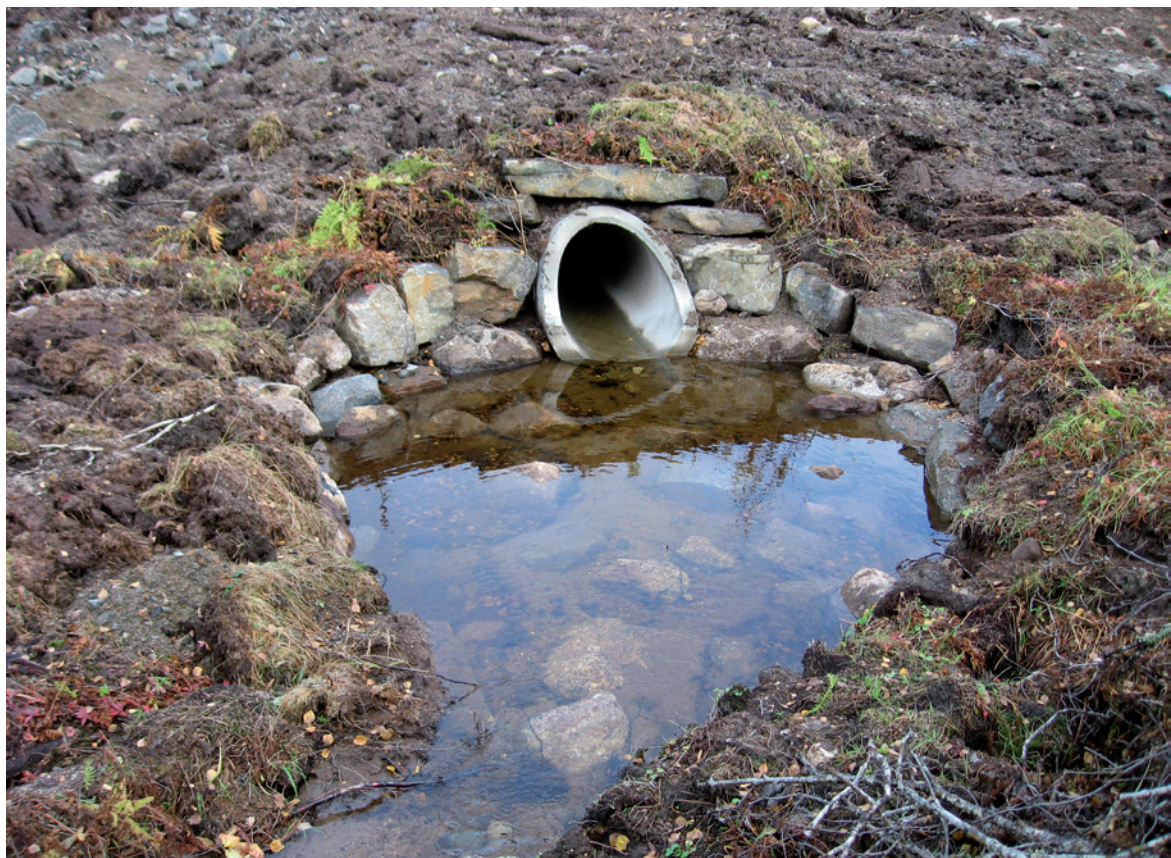
Figur 35: Maskinførere kan til og med få snudd torvene rett veg med skuffa! Foto: Kongsbakk
