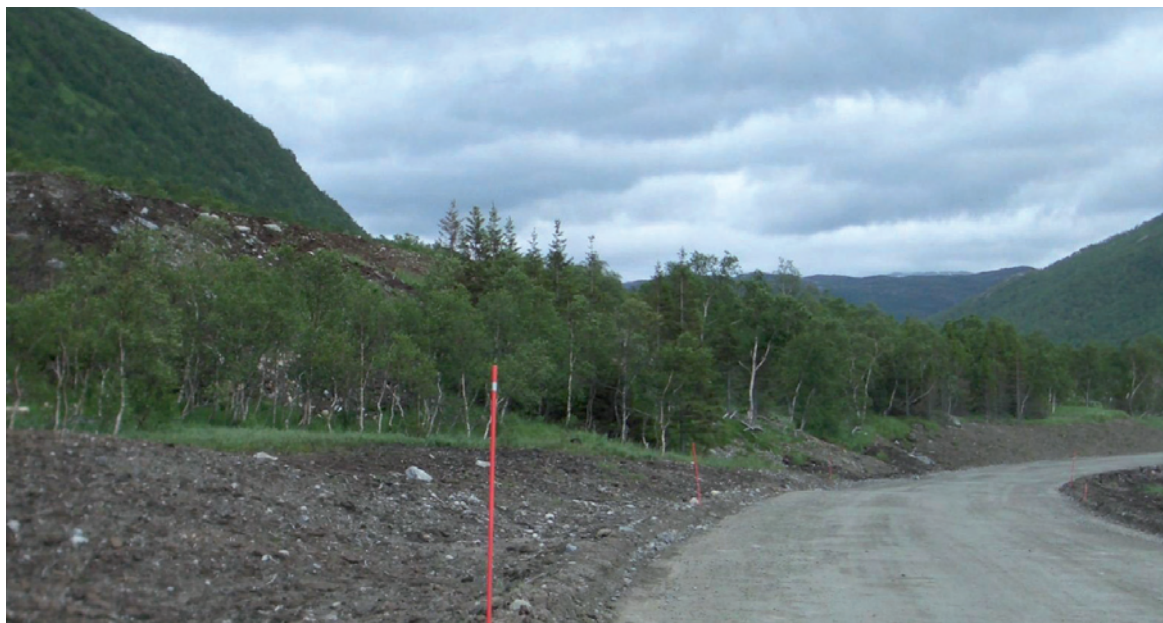
Figur 11: I Sør dalen ble to rasvoller plassert slik at det skulle være mulig å beholde vegetasjon både mellom vegen og vollene, og mellom de to vollene. Skogbeltene var avsatt som botområde i rigg- og marksikringsplanen. Den bakerste vollen skimtes så vidt til venstre i bildet. Foto: Kongsbakk
