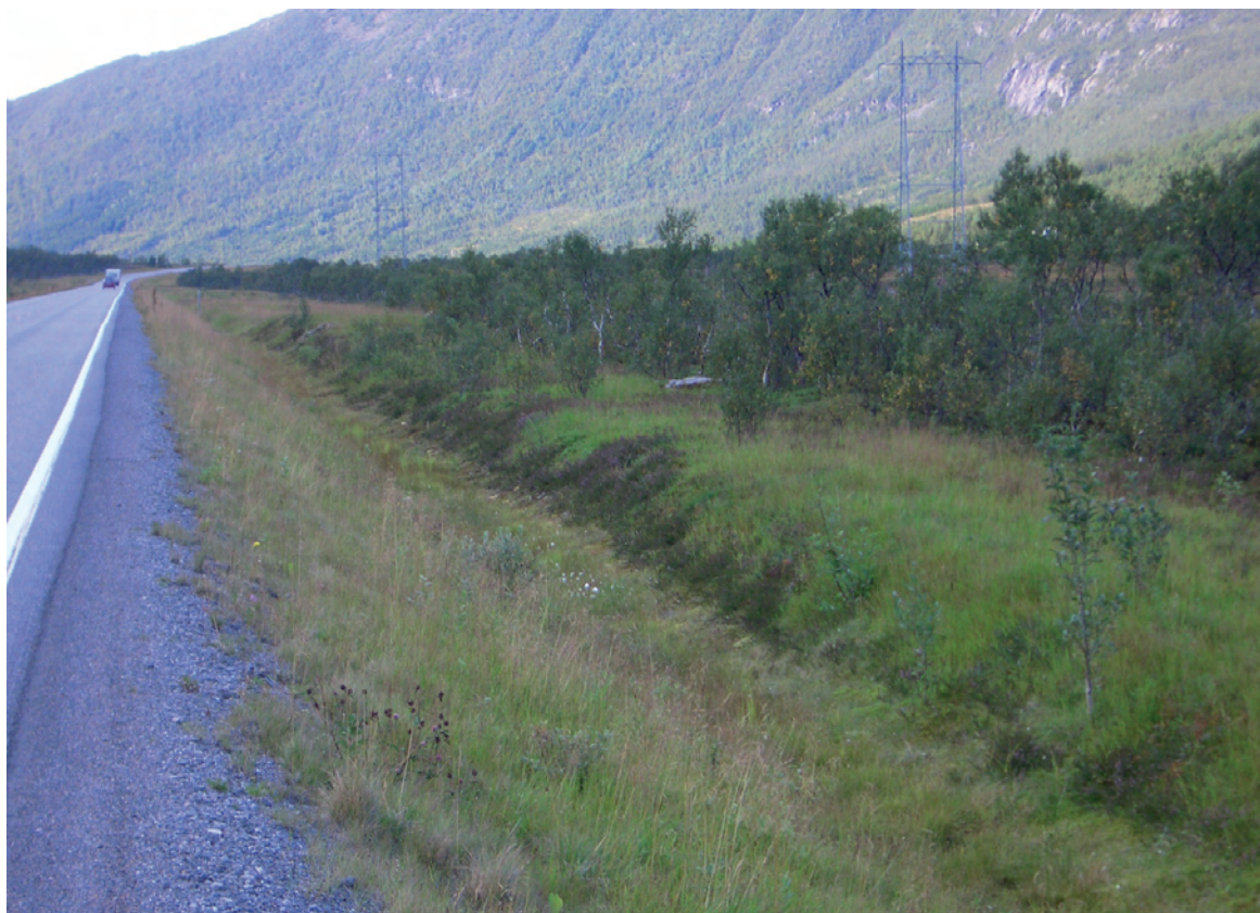
Figur 28: Lyngen trives på den tørre rabben ned mot grøfta. Der sideterrenget er slavisk formet etter vegmodellen vil man for alltid se skillet mellom veginngrepet og omkringliggende terreng jamfør figur 16. Foto: Kongsbakk
