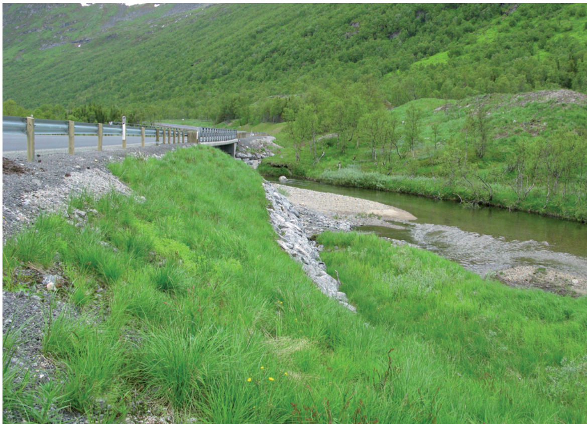
Figur 51: Inntrykket av de to rasvollene er dempet ned ved å orientere dem langs dalsiden istedenfor langs vegen, og ved å bevare skogbelter mellom vollene og vegen. Det koster omtanke, ikke mer penger. Foto: Kongsbakk
