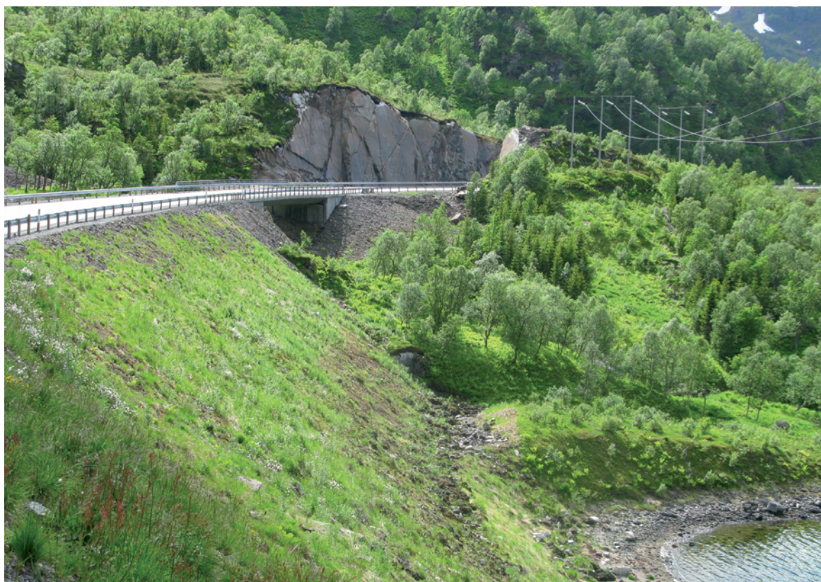
Figur 37: Den bratteste revegeterte steinfyllingen på Lofast har en helning på 37,5 grader. Skrånningen i Svartskarvika bærer ikke tegn til skader. Her fotografert sommeren 2009. Foto: Kongsbakk
