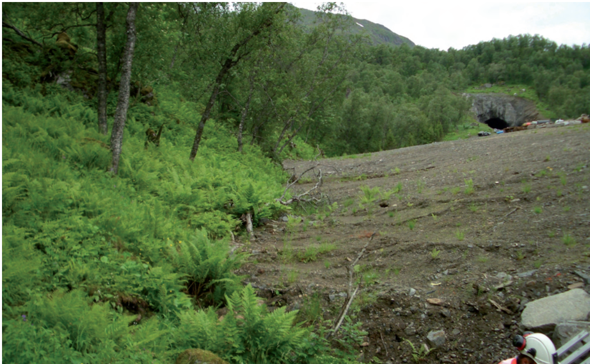
Figur 20: I det kupert og sidebratte terrenget i vest, ble det fylt inn betydelige mengder stein mot stigende terreng. Slik ble sideterreng så slakt at man unngikk rekkverk. Det var også mulig å få til en naturlig avrunding i overgangen mot naturlig terreng. Foto: Kongsbakk
