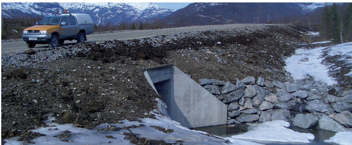
Figur 10: Høy årlig nedbør og forventede klimaendringer gjorde at drens-systemet ble kraftig dimensjonert. Foto: Kongsbakk
