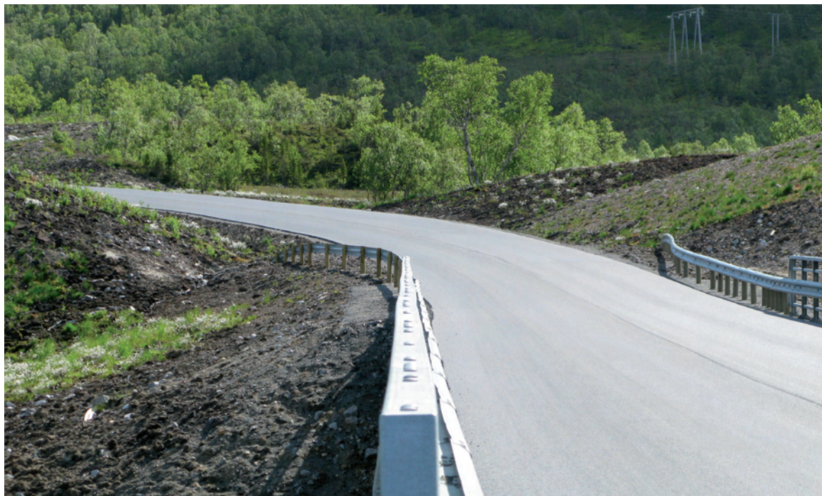
Figur 18: Når vegetasjonen får noen år på seg, vil vegen følge nytt et naturligt dalsøkk opp mellom grønne terrassekanter. Foto: Kongsbakk
