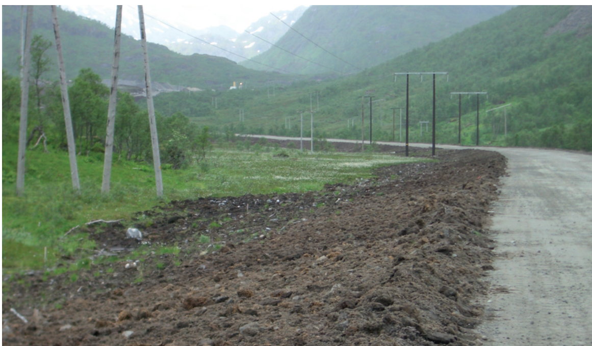
Figur 30: Målet er å viske ut grensene for inngrepet. På ensartet myr kan sagtannet overgang bety mye for det endelige resultatet. Foto: Kongsbakk
