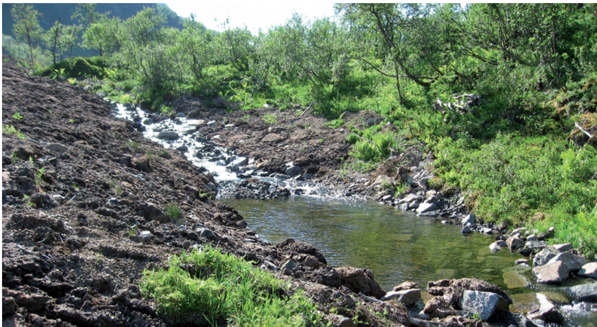
Figur 29: Den nybygde bekken er hevet flere meter opp i forhold til bekkens gamle løp. En dyktig maskinfører har fått til en fin overgang mot omkringliggende terreng. Foto: Kongsbakk
