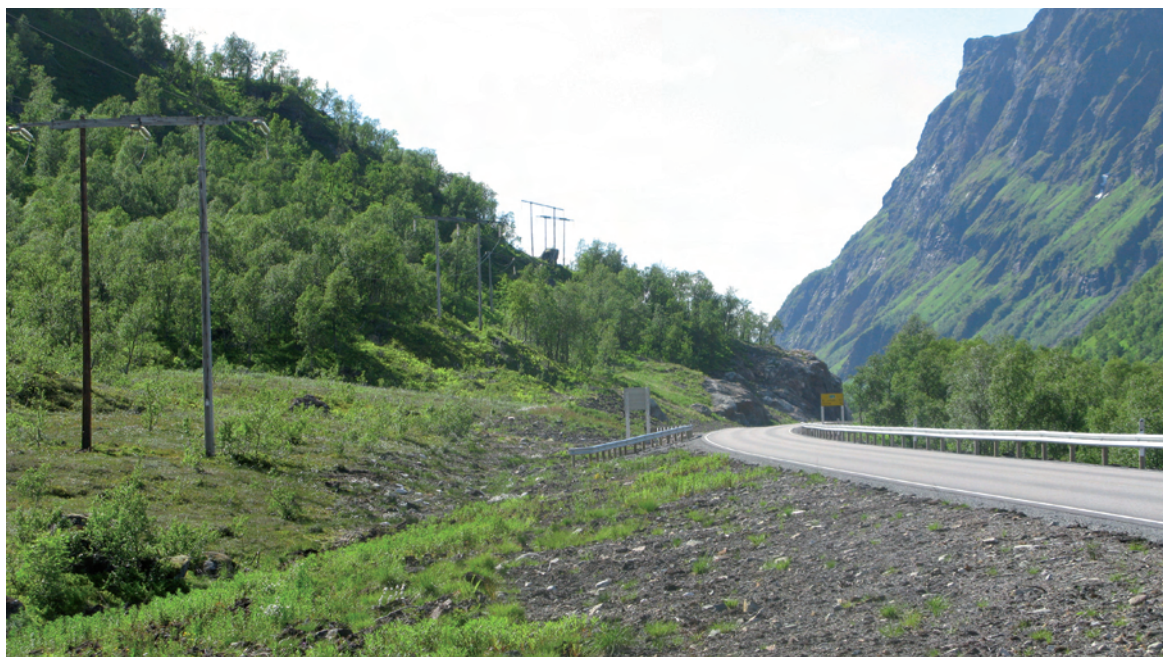
Figur 22: Flere kulvertinnløp ble vurdert som en så stor risiko at byggherre i ettertid valgte å sette opp flere korte strekninger med rekkverk. Foto: Kongsbakk
