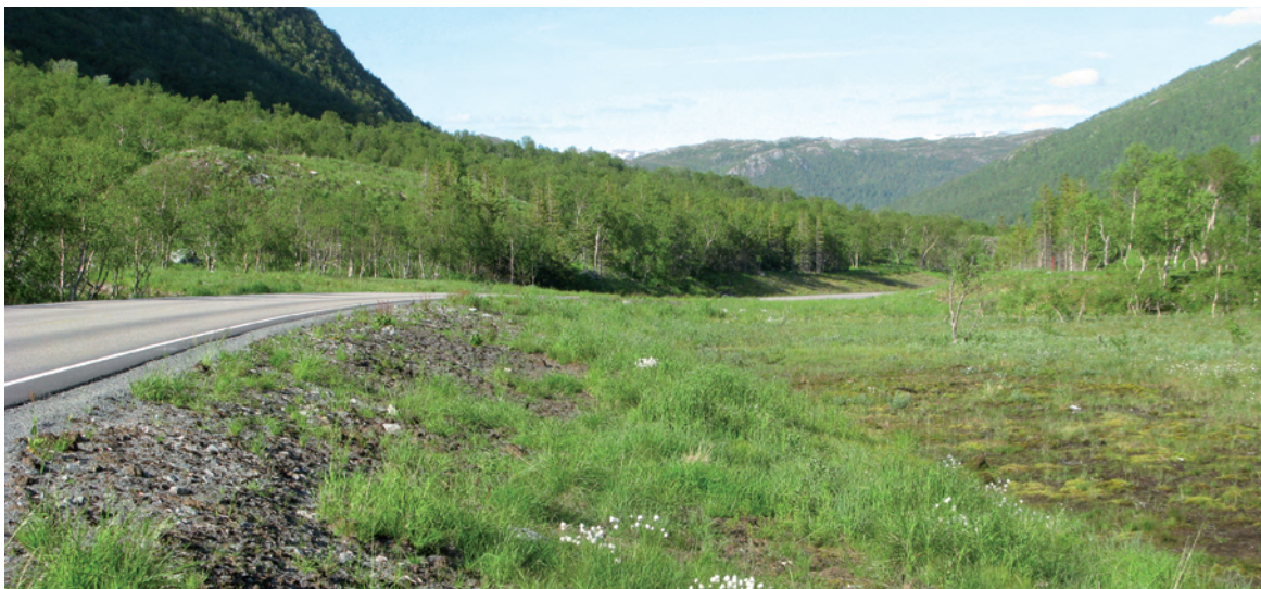
Figur 9: Store deler av Sør-dalen har fått mykt sideterreng uten rekkverk. Foto: Kongsbakk
