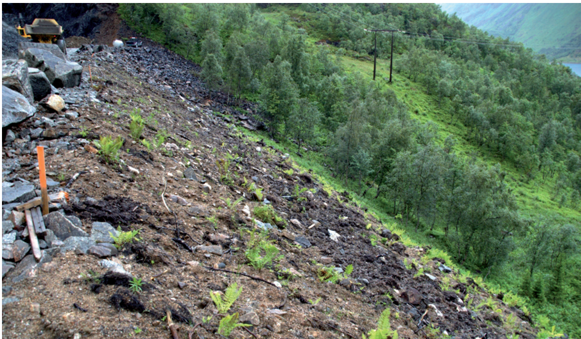
Figur 32: Lenger fra vegen kan det aksepteres en røffere overflate. Terrenget omkring anlegget er ikke flatt. Foto: Eliassen
