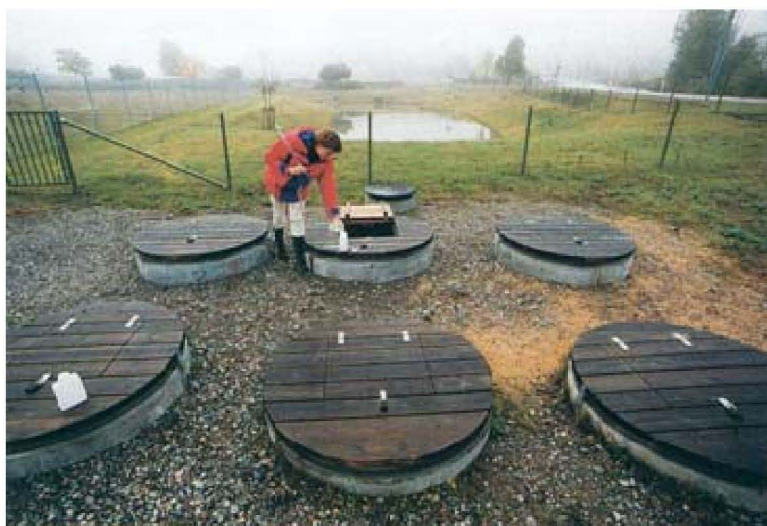
Figur 10-1. Forsøksanlegg for filtermedier i Sverige med forbehandling og magasinering i åpen dam (sees i bakkant).
