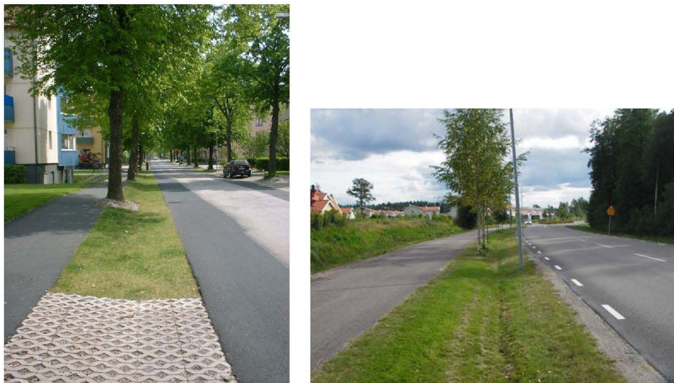
Figur 9-7. Eksempel på graskledde filtergrøfter langs gater (foto: Göran Lundgren)
