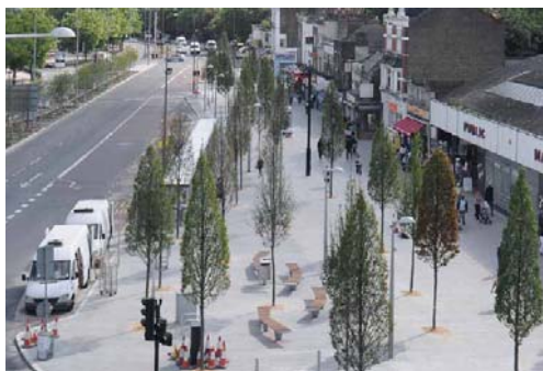
Figur 5.4 Utbedring i Woolwich bysenter
