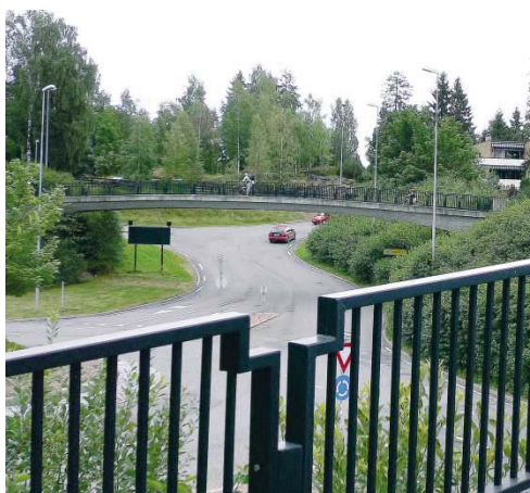
Figur 4.17 På Bekkestua er terrenget utnyttet slik at forgjengerne kan krysse veien på en bru. Veien er gravd ned i terrenget, og de gående beveger seg i terreng høyde. Dette gir en åpen, tiltalende og effektiv reise for de gående. Høy kvalitet på utforming av bru, utstyr og beplantning gir en fin ramme rundt reisen.
