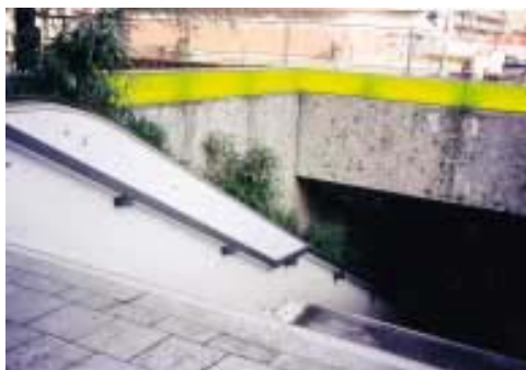
Figur 4.21 En seksfelts boulevard i München. Store anstrengelser ble gjort for å gjøre undergangen tiltalende og innbydende, men den var ubrukelig for gående. Undergangen ble stengt, og i rulletrappene ble det plantet busker. Nå krysser fotgjengerne gaten på tradisjonell måte, de venter på grønn mann, og er igjen blitt en del av byens liv.
