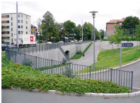
Figur 4.13 På den andre siden av gaten ble hele terrenget sjaktet ut og omarbeidet for å gi en åpen og lys situasjon rundt undergangen. Høy kvalitet på konstruksjoner, terrengbehandling og grøntanlegg gjør anlegget til en positiv opplevelse. Anlegget er krevende og stort i forhold til omgivelsene.
