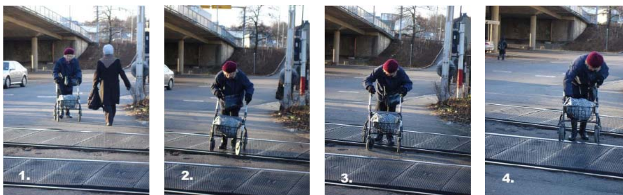
Figur 3.16 Kryssing av jernbaneovergang kan by på utfordringer for den som er avhengig av å bruke rullator. Asfaltdekket er hullete og ujevnt. Foto: Kristoffer Rein.
