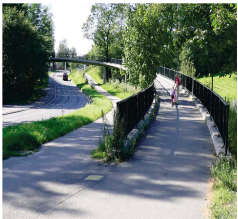
Figur 4.18 For å hindre trafikkfarlig kryssing av veien er det laget en velformet gangbru ved Stabekk skole i Bærum. Det er en fin opplevelse å bevege seg over brua som sverver mellom store trær og forholder seg fint til landskapet og utsikten. Lengde og plassering av brua i terrenget gjør at stigning og høydeforskjell ikke er en stor barriere ved kryssing av veien.
