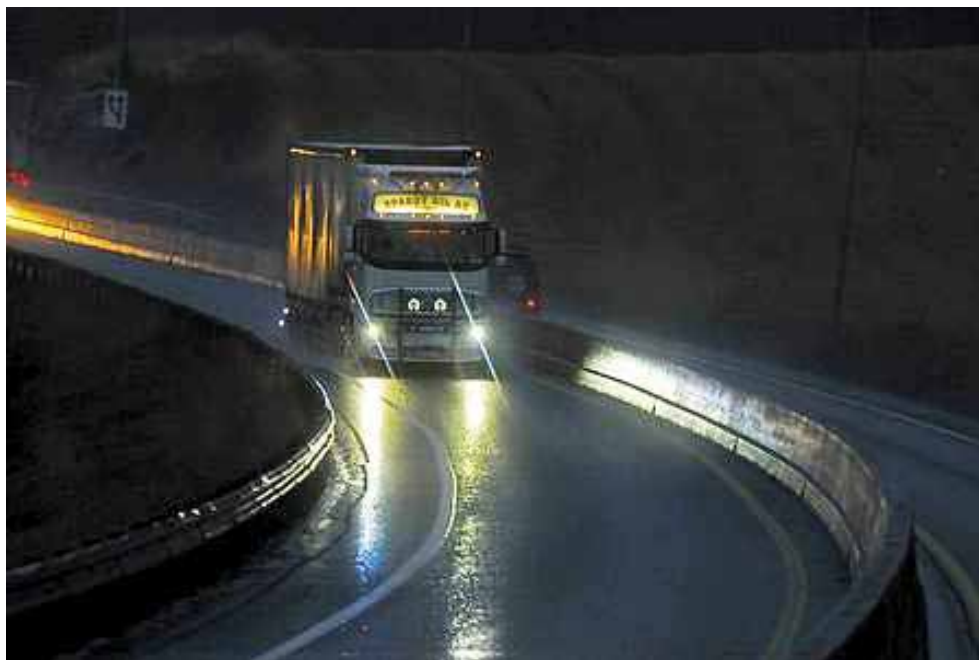
Bilde av midtdeler i kurve. Et godt trafikksikkerhetstiltak. (fra Vegvesenets arkiv)
