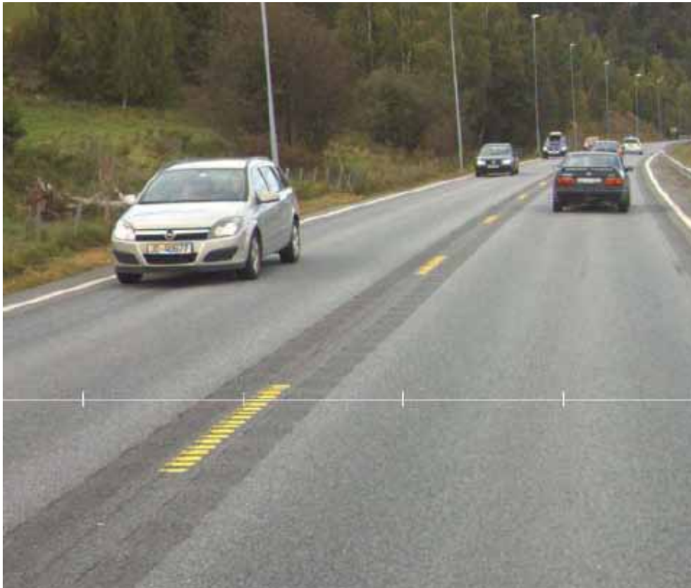
Eksempel på forsterket midtoppmerking med profilert kjørefeltlinje og sinusriller utenfor vegoppmerkingen.
