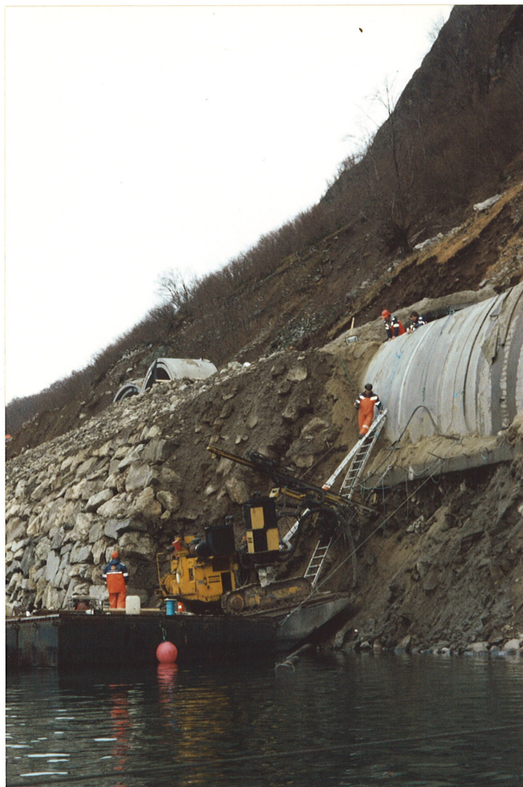
Bilde 1 Sikring av fundament og skråning med jordnagler
