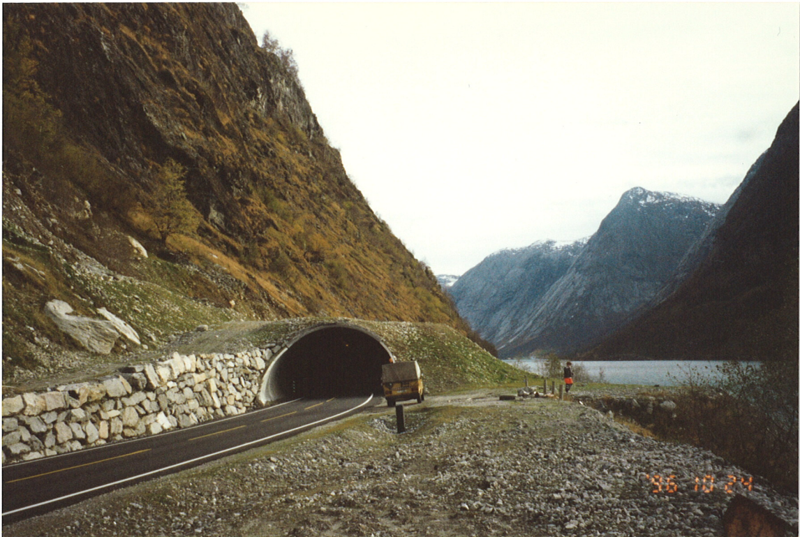
Bilde 29 Omfylling ferdig med tørrmur i enden
