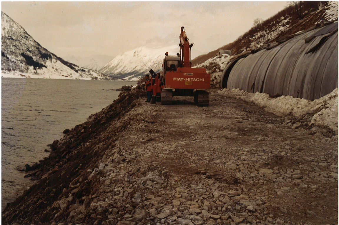
Bilde 11 Fylling opp til fundamentnivå. Finstoff i fyllingen
