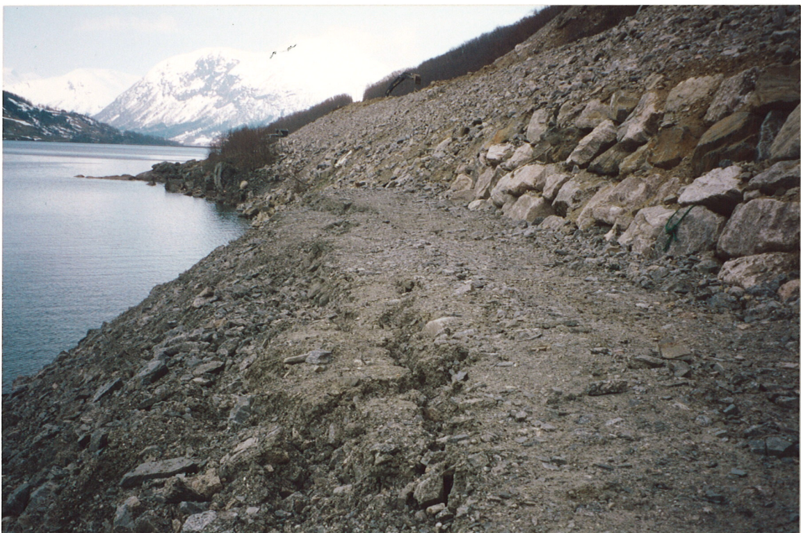
Bilde 12 Glidninger (stabilitetsbrudd) i fyllingen på grunn av for mye finstoff
