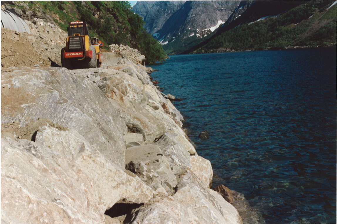
Bilde 19 Erosjonssikring med grov stein
