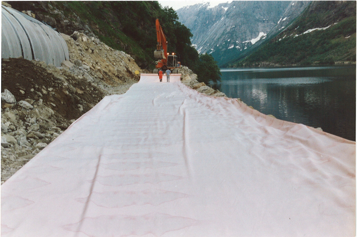
Bilde 17 Utlegging av jordarmering Televev 150/150
