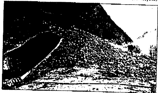
Masse i to meters tjukne over rasoverbygget skal m.a. tene til å stabilisere overbygget.
