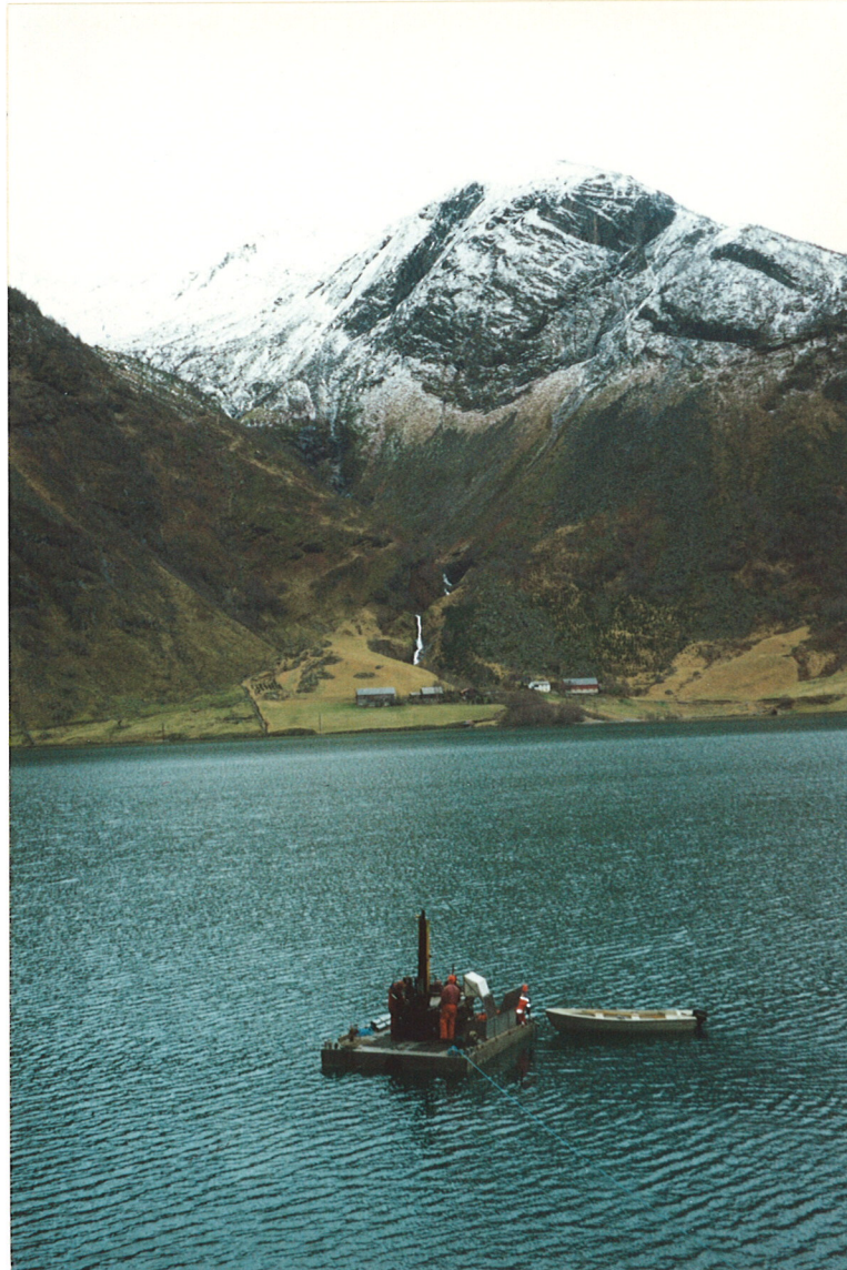
Bilde 7 Grunnboring fra flåte for å undersøke grunnforholdene for fylling i vannet.
