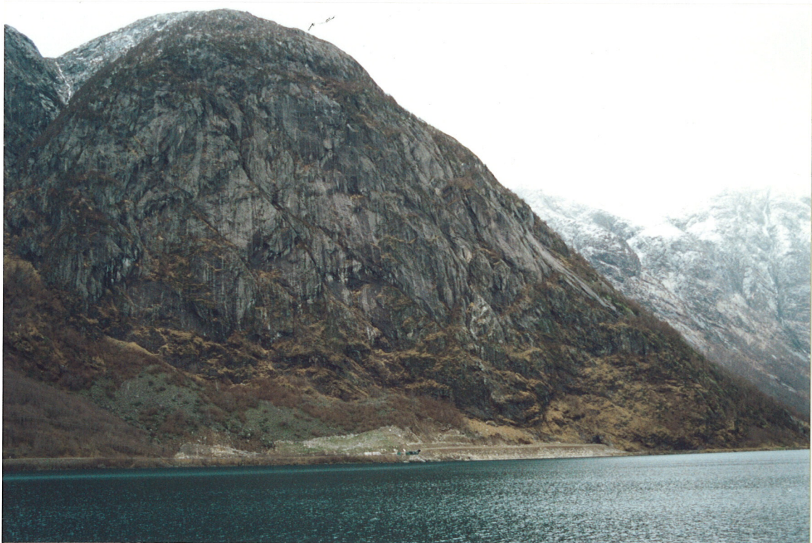
Bilde 30 Ferdig utbedret rasoverbygg med fjellet i bakgrunnen
