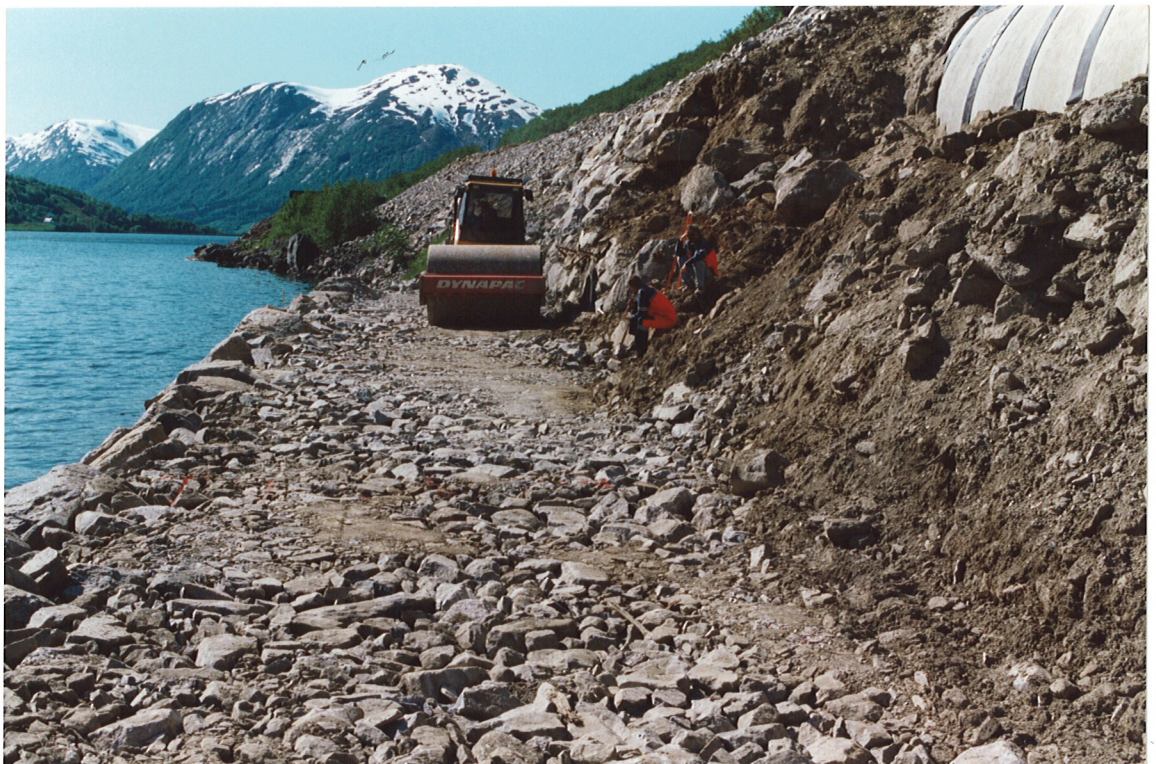
Bilde 16 Komprimering av fylling utenfor rasoverbygget
