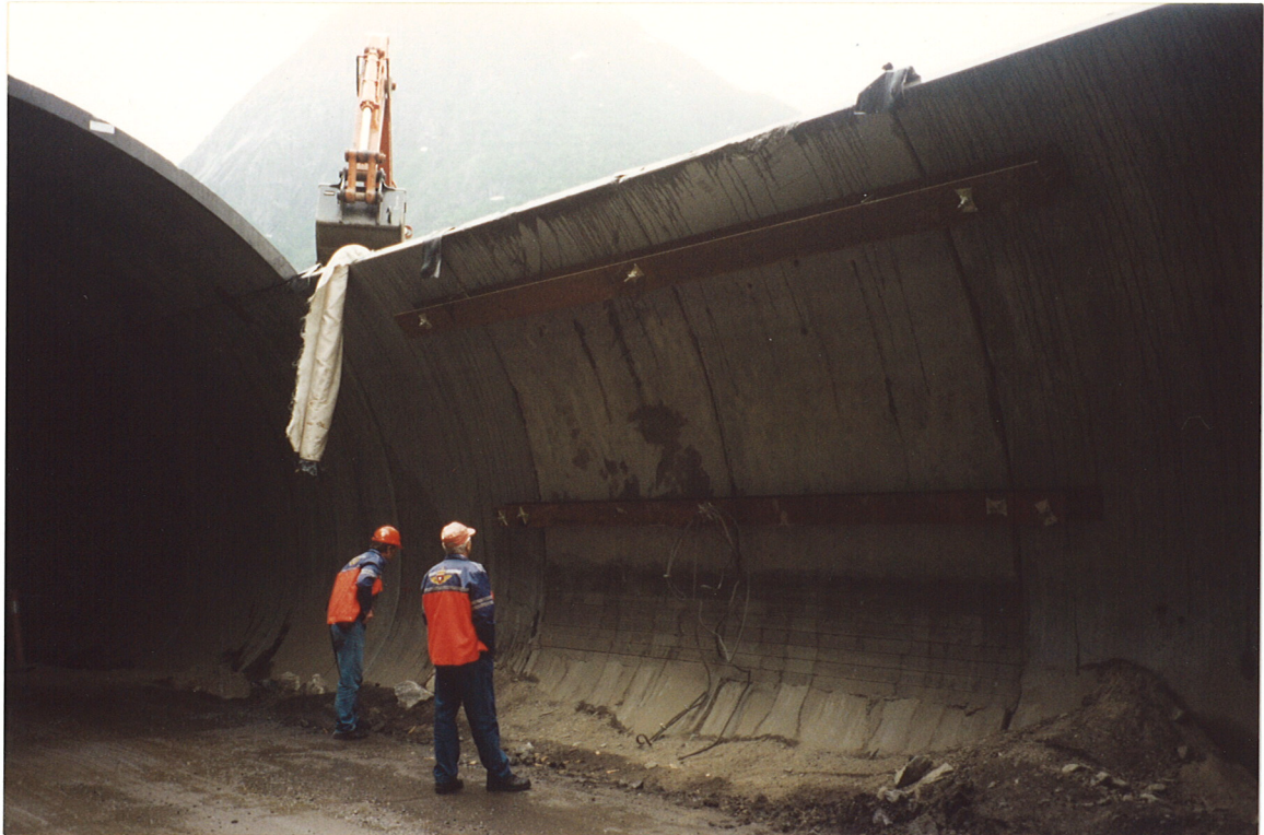
Bilde 21 Stålbjelker over elementene i rasområdet
