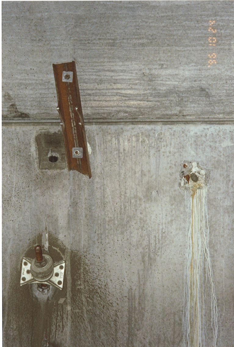
Bilde 23 Detalj av stållask (merk gammelt hull hvor 20 mm fjellbolt ble revet ut under tilbakefylling). Lenger ned er vist Ischebeck - stag som ble boret inn i fjell.
