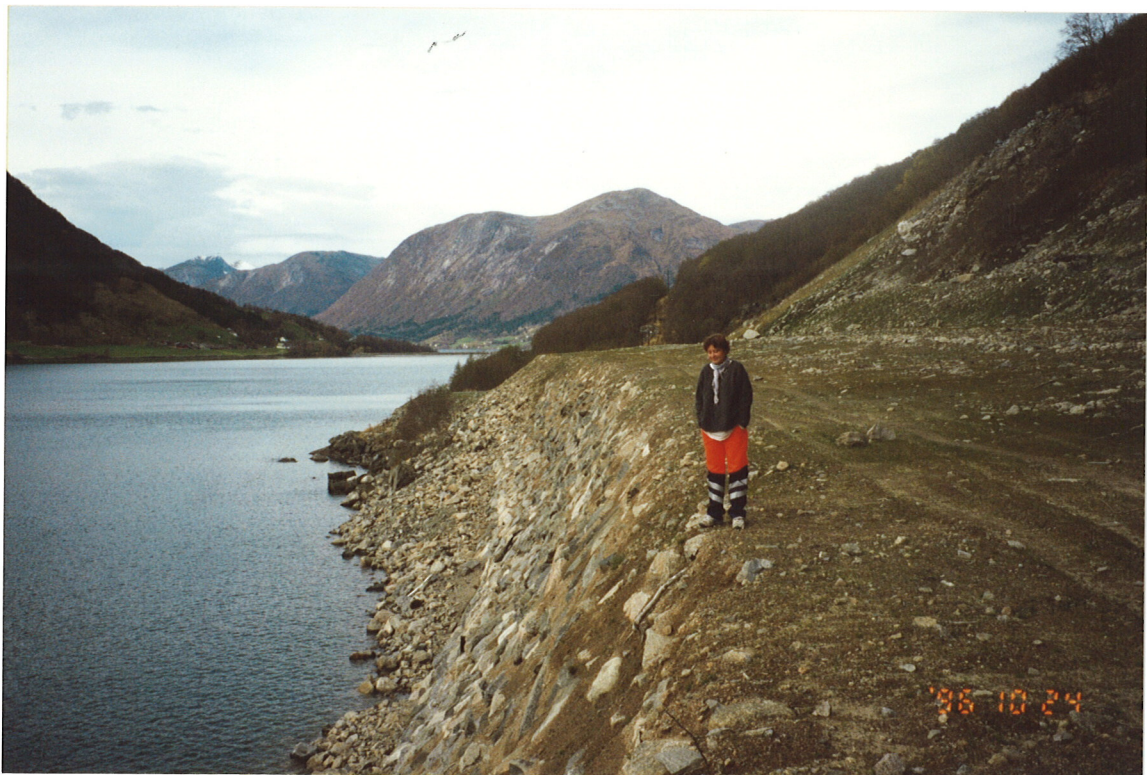
Bilde 28 Ferdig overfylling
