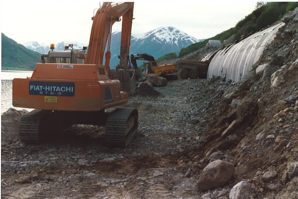
Bilde 20 Arbeid med erosjonssikring
