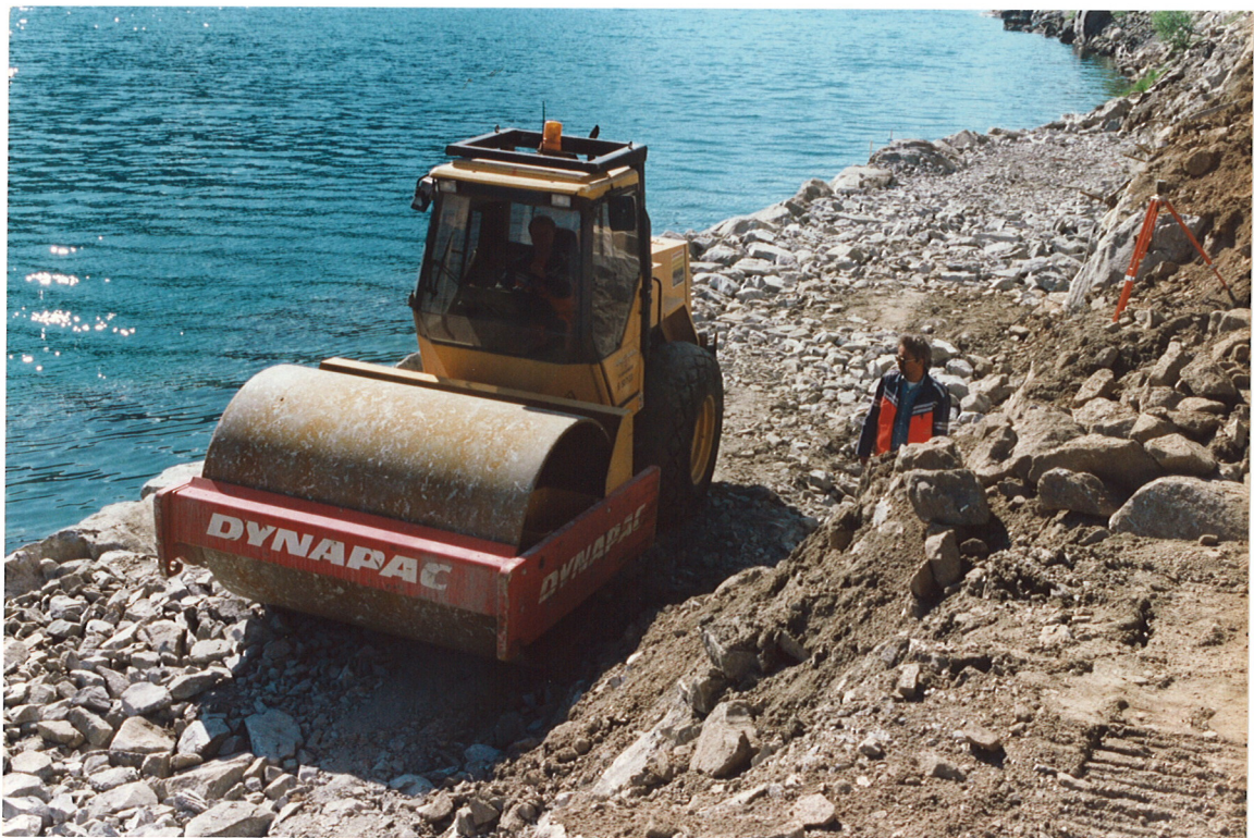
Bilde 18 Komprimering med 10t vibrovalse. 8 passeringer med 1 m lagtykkelse
