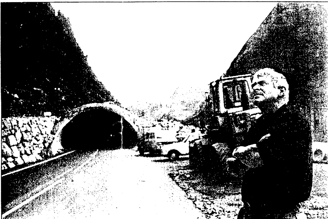
Ei stor steinblokk kan truge rasoverbygget i Kjosnesfjorden, meiner medlem av breredsningsgruppa i Jølster, Reidar Bakke. Han har sjølv observert sprekk i det steilbratte fjellet, 200 meter overfor rasoverbygget.
