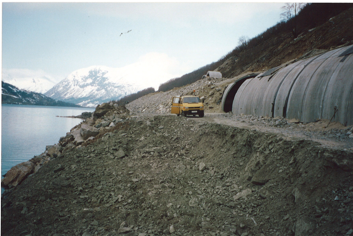
Bilde 15 Avgraving av masser før fylling med jordarmering
