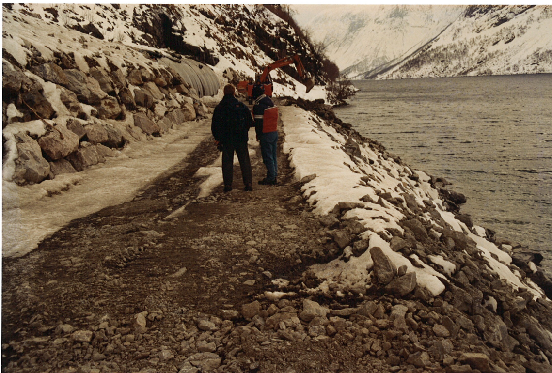
Bilde 14 Avslutning av fyllingsarbeider i vannet
