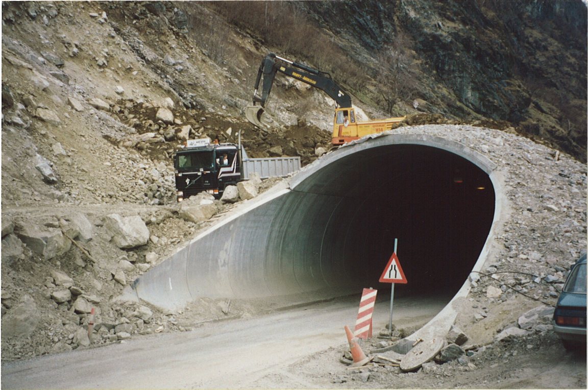
Bilde 27 Økning av overdekning over enden av rasoverbygget
