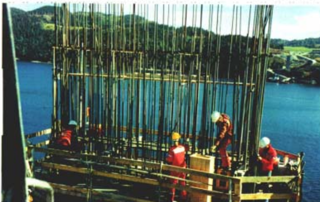
Fig. 2.3 Arbeidsplattformen under glidestop av søyler.
