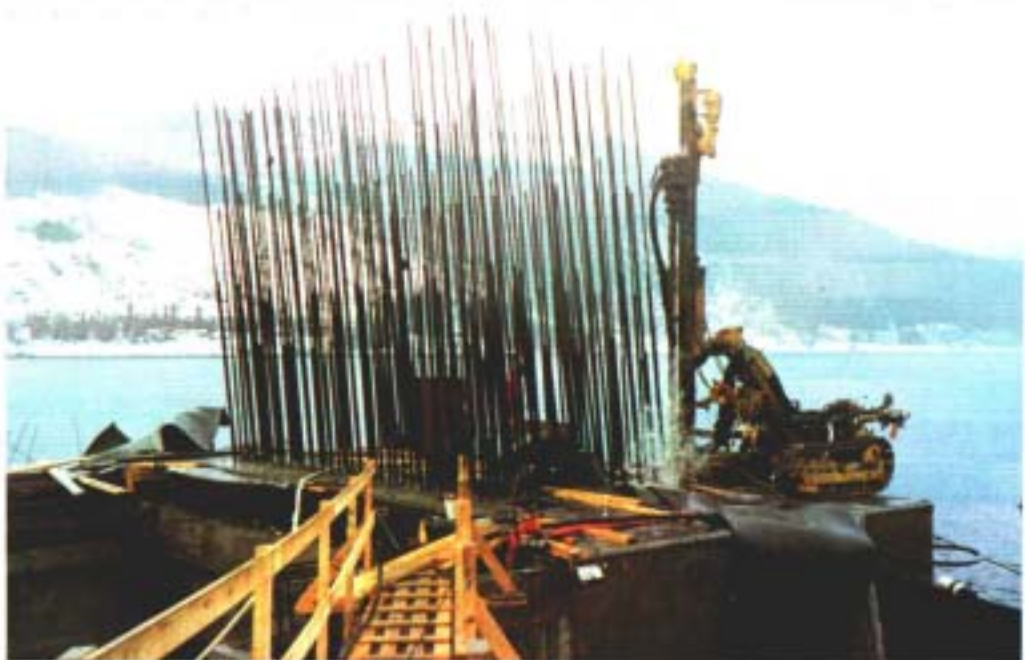
Fig. 2.6 Boring for fjellforankringer under tårnfundament Inderøy (det ble satt ned ror for disse i de støpte delene).
