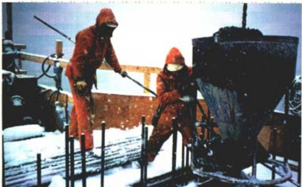
Fig. 2.12 Glidestøp krever at det stopes kontinuerlig for ikke å få utilsiktede støpe- skjøter. Her burde det normalt ikke vært støpt. For øvrig foregikk glide- støpingen av tårnene under stort sett meget gode værforhold.
