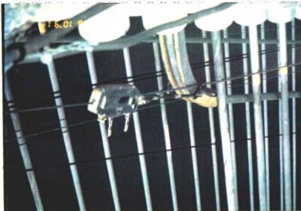
Fig. 2.26 Utstyr for innføring av kabelhode gjennom forankringsrør. Det gikk greit å "stuke" kabelhodet inn utenfra.
