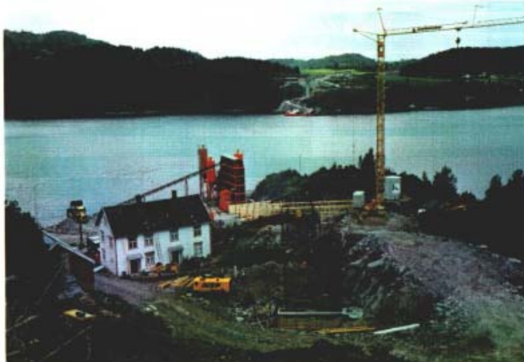
Fig. 2.1 Mosvik-siden i juli 1989. Betongstasjon ferdig rig- get. Søylefundament akse 11 støpt.
