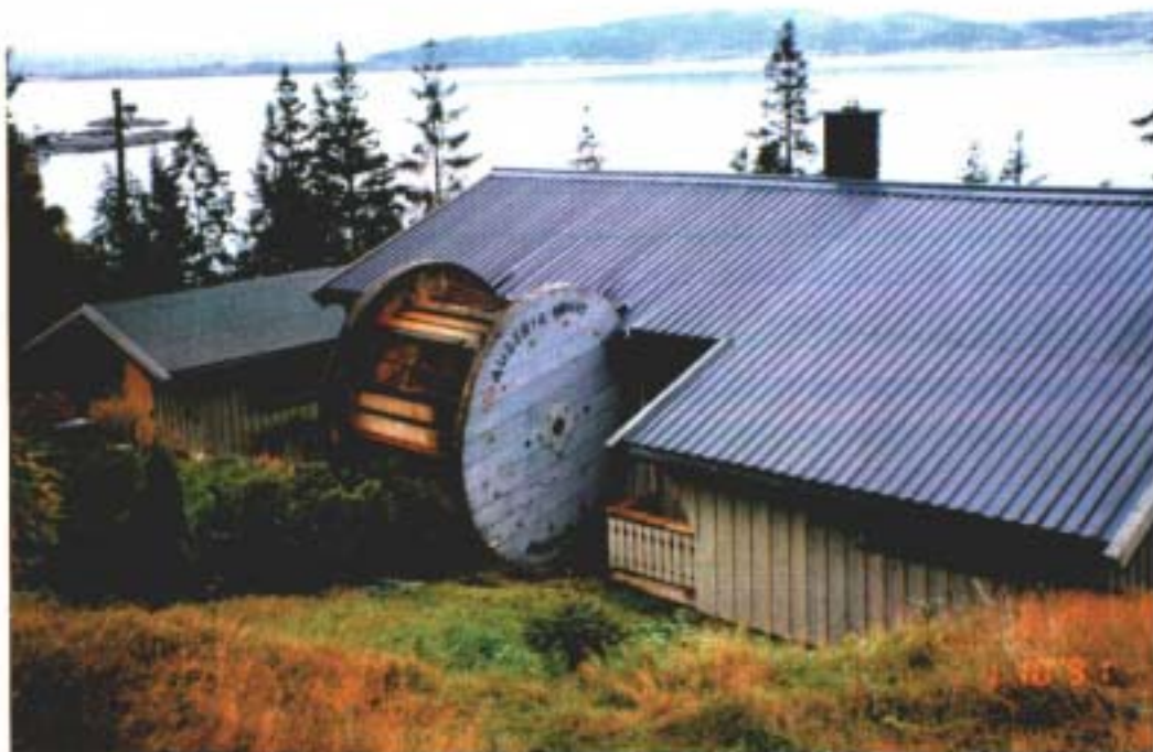
Fig. 2.32 "Løpsk" kabeltrommel, heldigvis etter montering av kabel. Hytta måtte likevel fullverdierstattes pga. flytting på grunnmur og total innvendig ødeleg- gelse.
