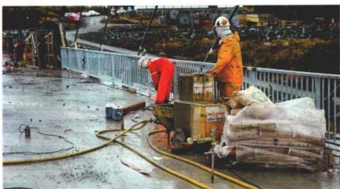
Fig. 5.1 Injisering ballastbetong i sidespenn. En omfattende og tidkrevende jobb med mye søl. Injisering gjennom kjerneborete hull i betongdekket der det ble registrert hulrom.
