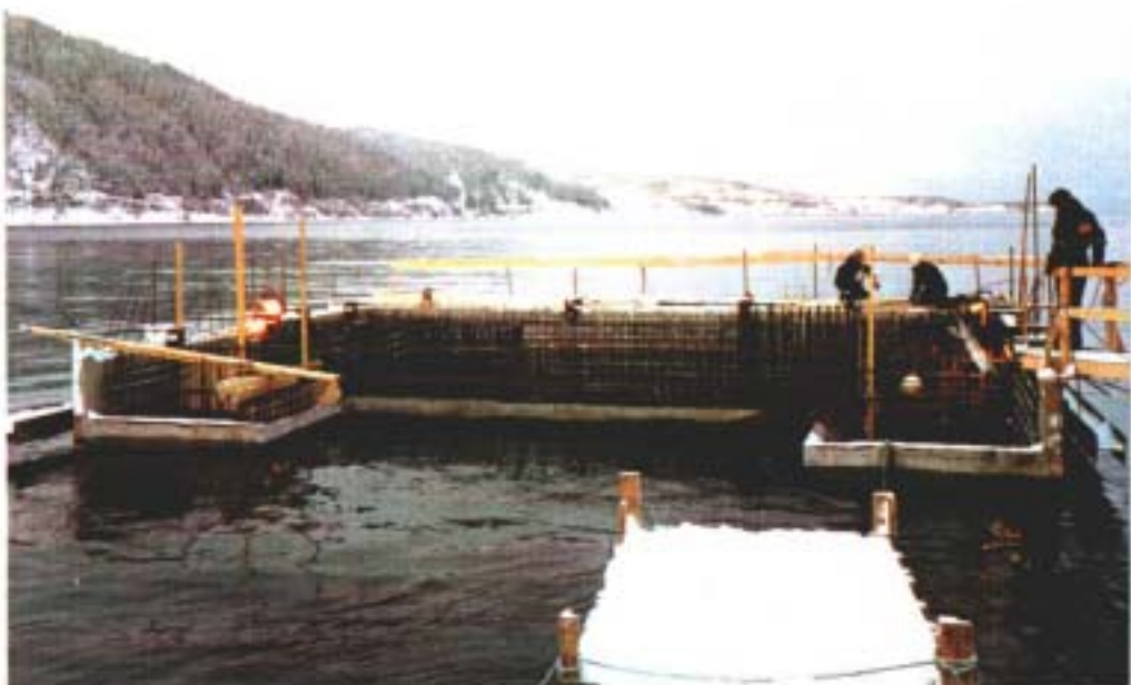
Fig. 2.5 Armering av nordre del av fundamentplate tårn Inderøy. Forskaling av betongkassetter. Des. 1989.
