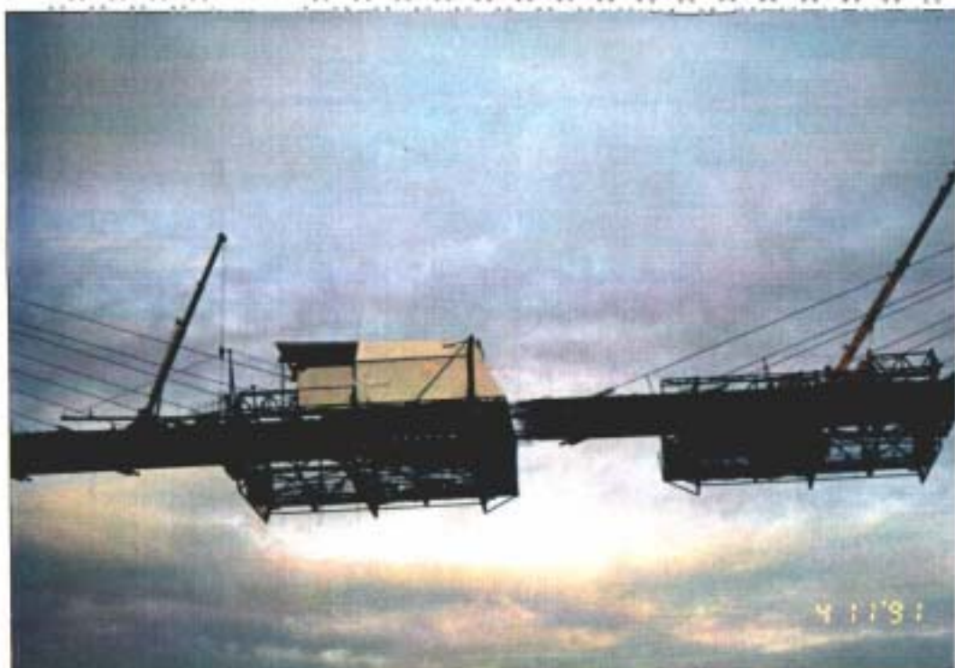
Fig. 2.41 Forberedelser til sammen- støping, med nedmontere- ring av én vogn. Sammen- støping avsluttet 11. nov. 1991 kl. 1800.
