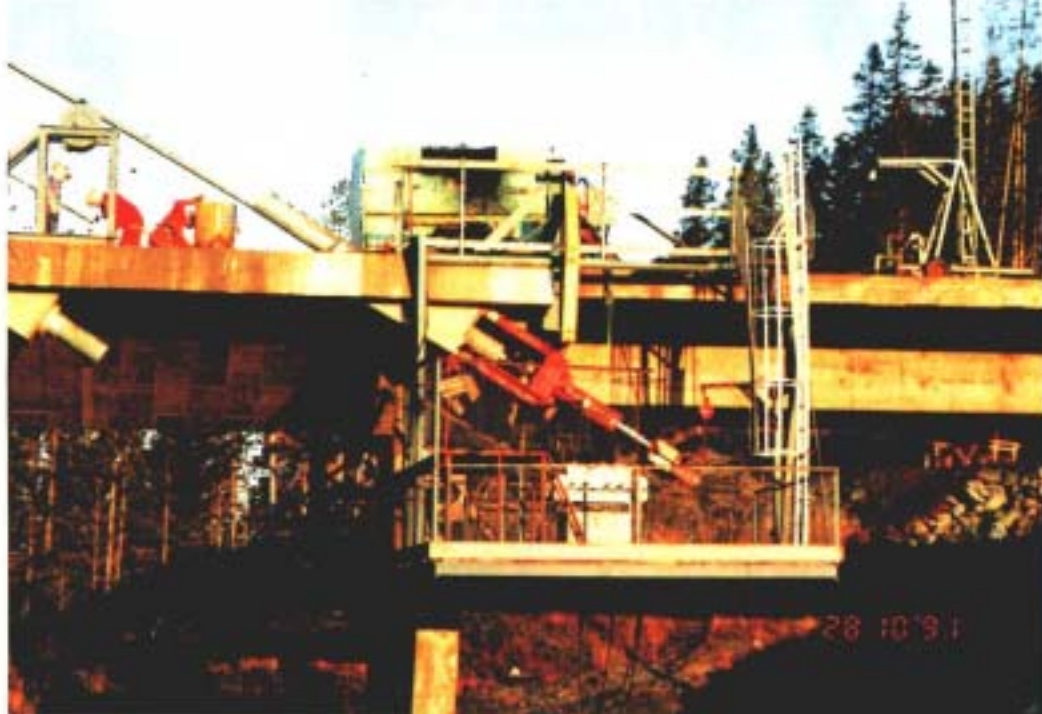
Fig. 2.31 Hengestillas, støttebukk og jekker for stramning av kabler i sidespenn.
