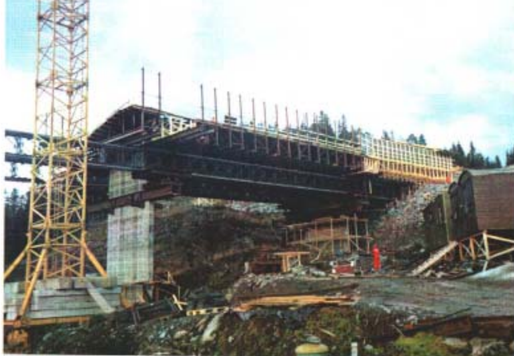
Fig. 2.7 Viadukt akse 1-5 Inderøy i okt. 1989. Understøttelse av frittstående framskyv- bart Bailey-stillas.
