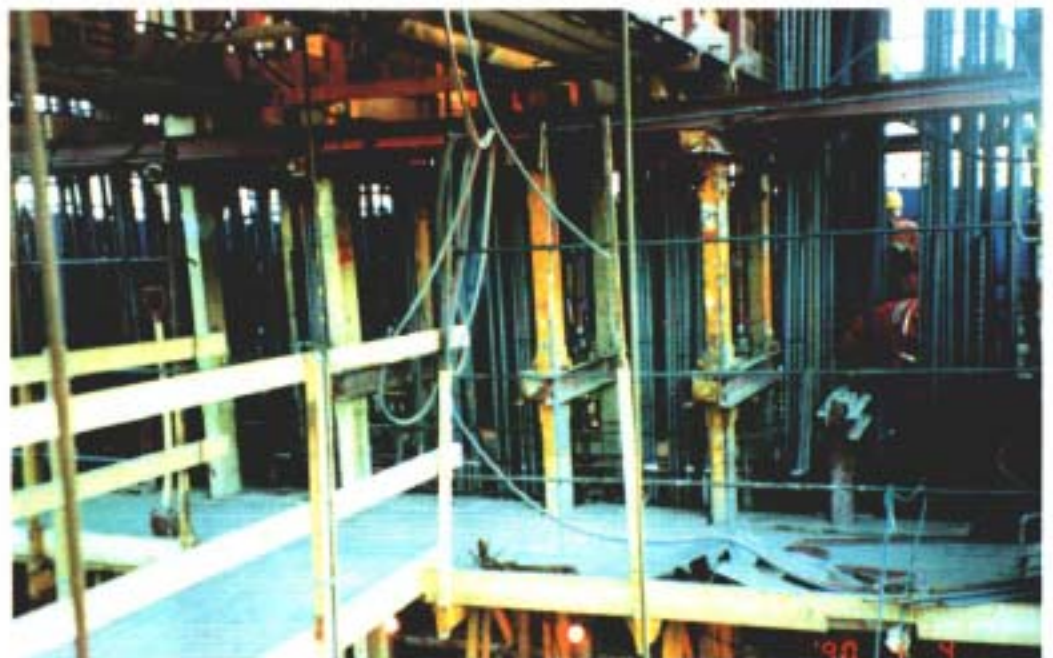
Fig. 2.15 Hovedgrunnen til at det tidvis ble trangt mellom armeringen er det plasskrevende glideformsystemet som "stjeler" mye av betongtverrsnittet.
