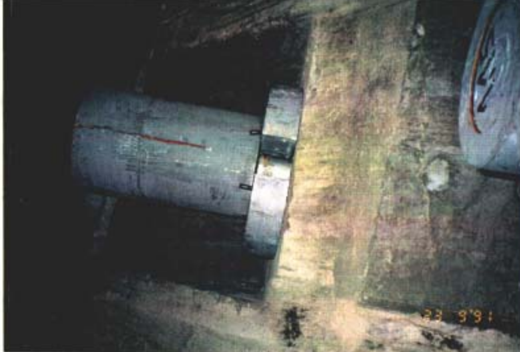
Fig. 2.34 Avlåsning av kabel i tårntopp. Bemerk "tapper" for sentrering av kabelhode mot låseplate (tilsvarende mellom låseplate og rør-åpning).
