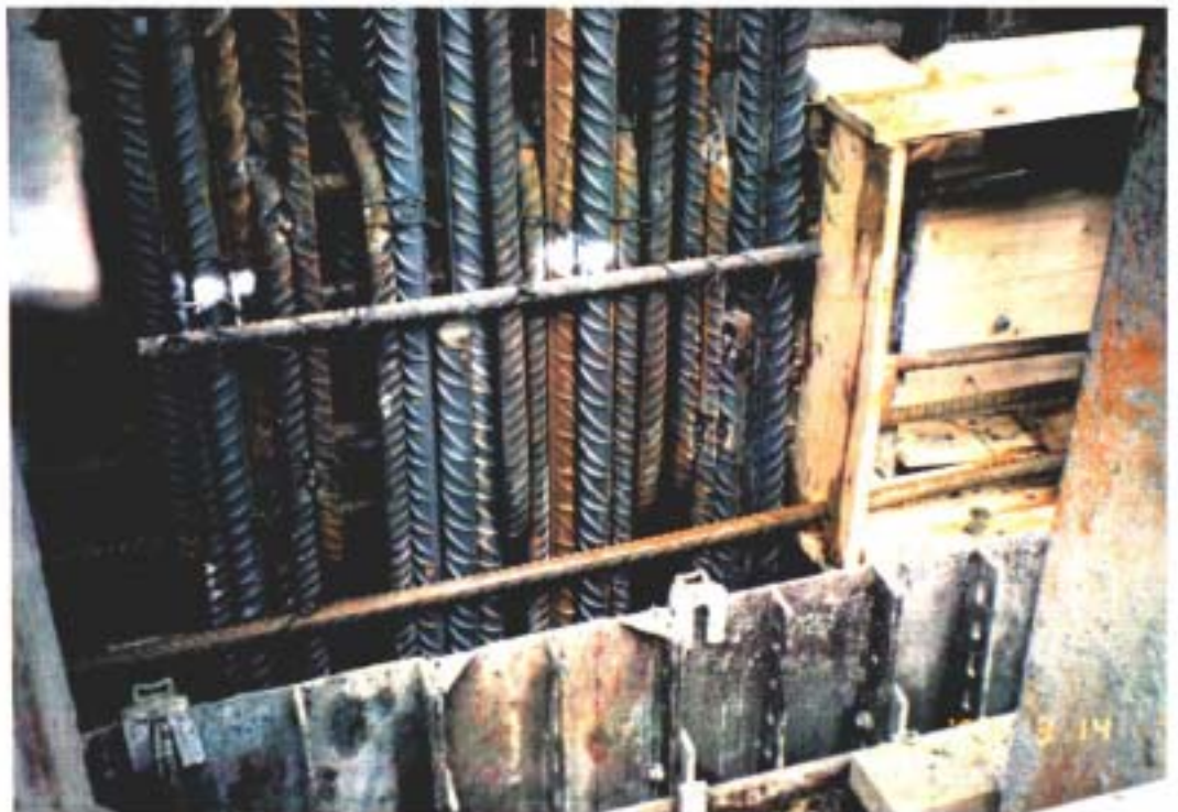
Fig. 2.14 Vertikalarm., skjøtarm. til planumsrigel, utsparring for spennkabelforankringer. Det blir trangt. Bemerkt plateelementene i stålformen, som er enkle å montere/demontere.
