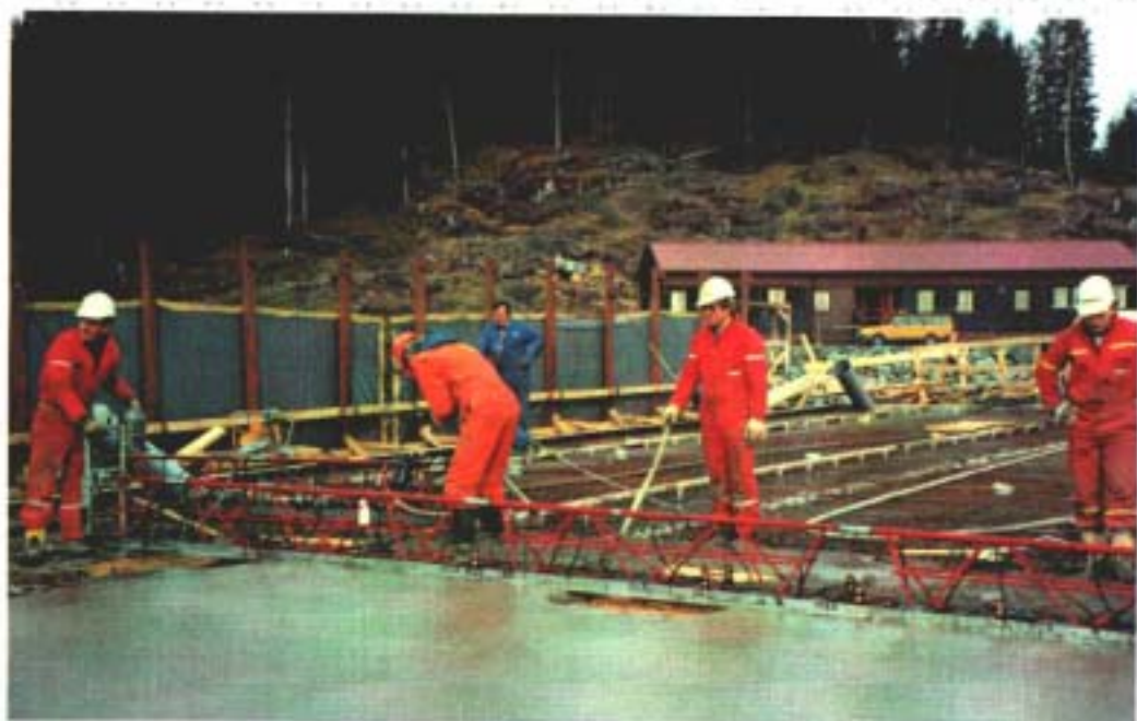
Fig. 2.9 Støping av dekkefelt i viadukt akse 1-5. Vegve- senets kontorforlegning i bakgrunnen.
