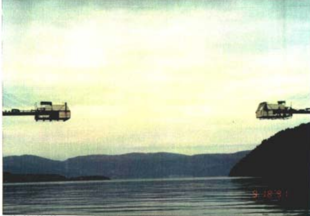
Fig. 2.40 Kragarmene nærmer seg hverandre med 2 x 10 m pr. 4 ½ døgn. En del av presenningsarealet er tatt bort for å redusere vind- kreftene.
