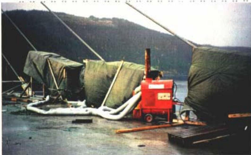
Fig. 2.33 Tildekking og oppvar- ming for maling av kabler i "rørskygger".
