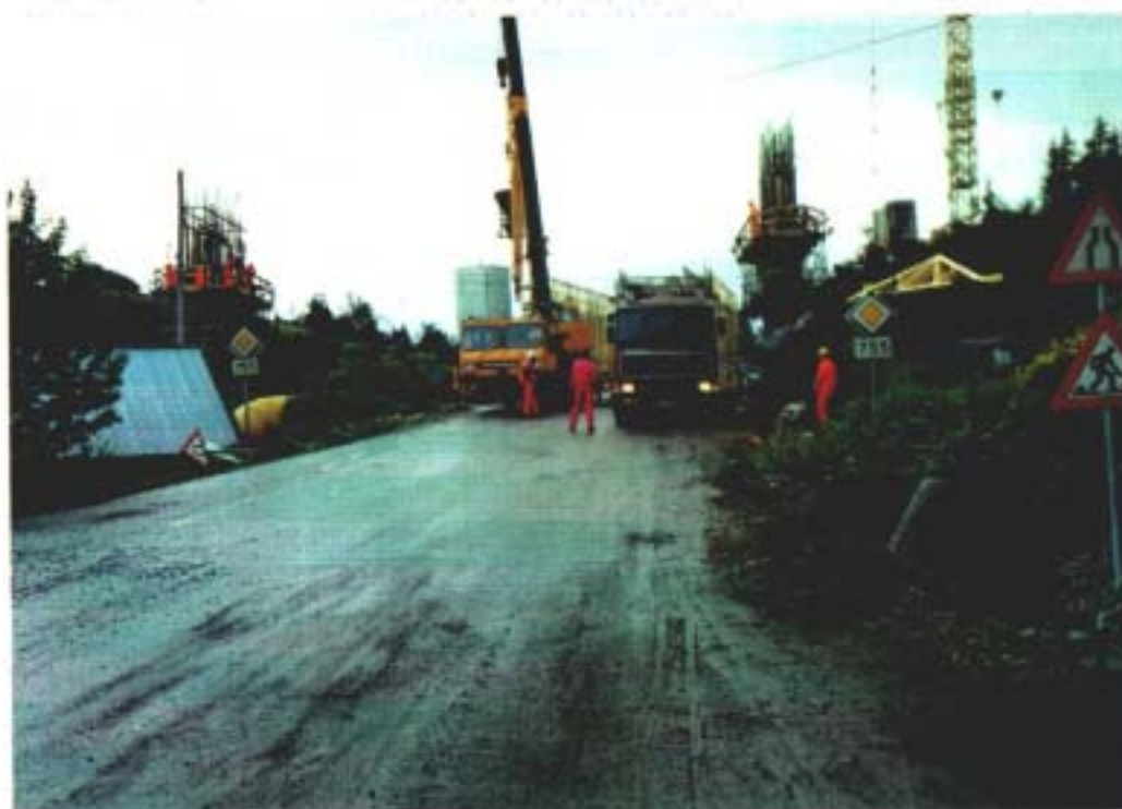
Fig 2.2 Glidestop søyler akse 8 og 9 igang. Rv. 755 går gjen- nom anleggsområdet, og overbygg over riksvegen settes opp.
