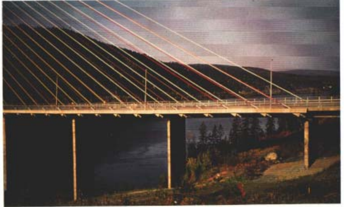
Fig. 3.15 Illustrasjon av malingsarbeidet.
