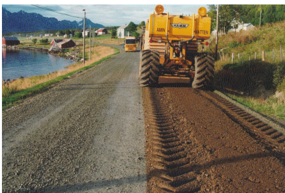
Venstre side: tørrfrest og avrettet vegprofil Høyre side: dypstabilisering (E6 i Troms, Lyngen)
