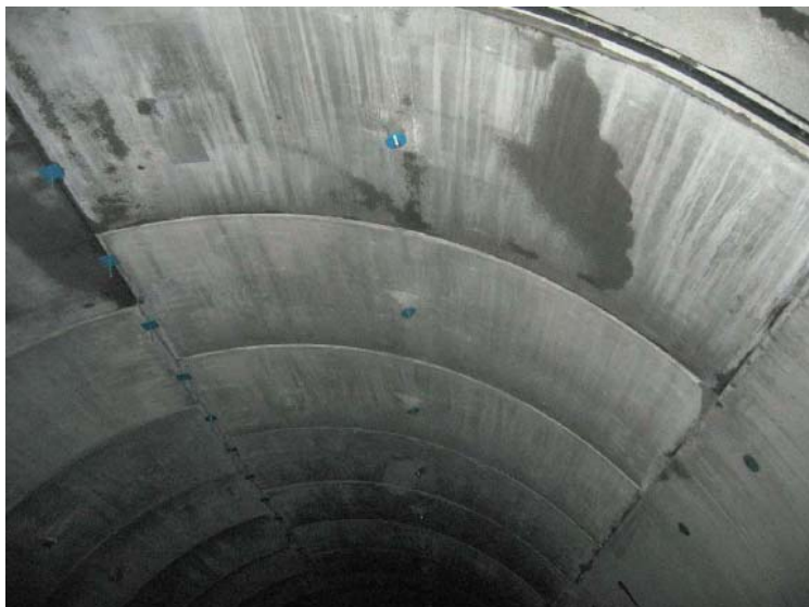
Figur 6 Lettbetongelement i tak
