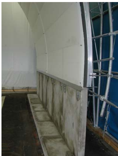
Figur 17 Flexihvelvet i kombinasjon med betongkant
