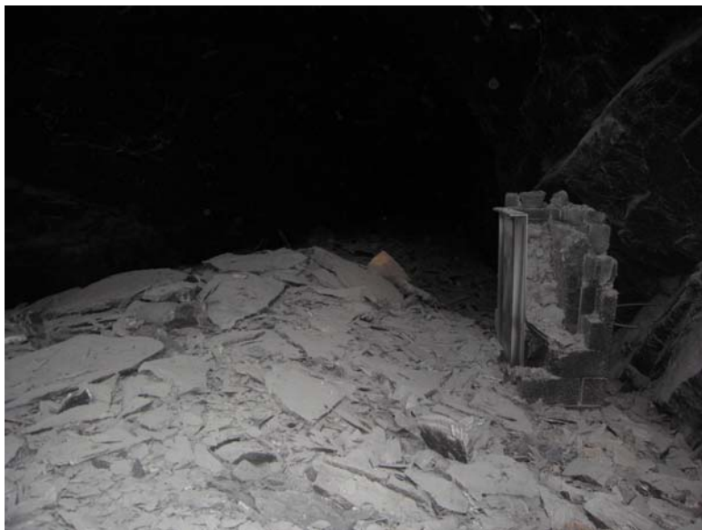
Figur 23 Nedfall 10 m nedstrøms ved vegg
