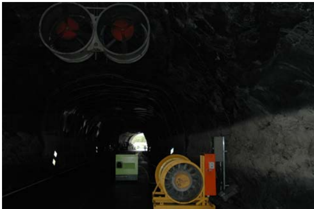
Figur 2 Fastmonterte og mobil vifte
