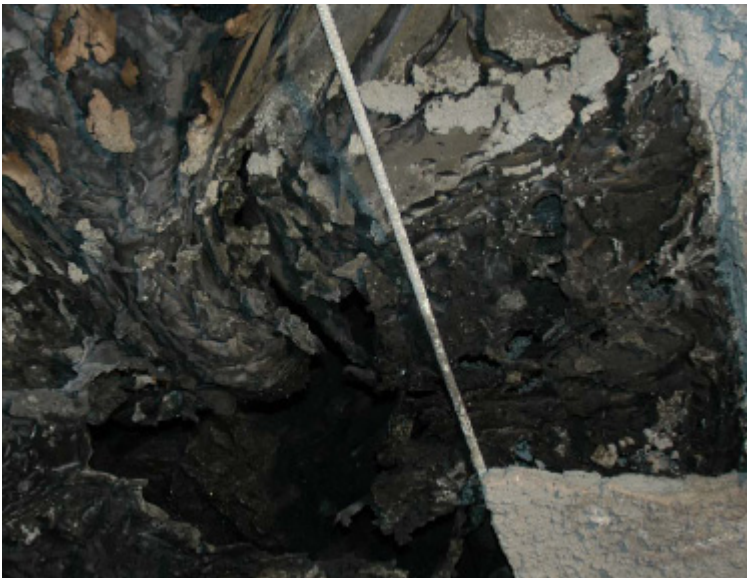
Figur 19 Smeltet/forkullet PE-skum bak sprøytebetonghvelv
