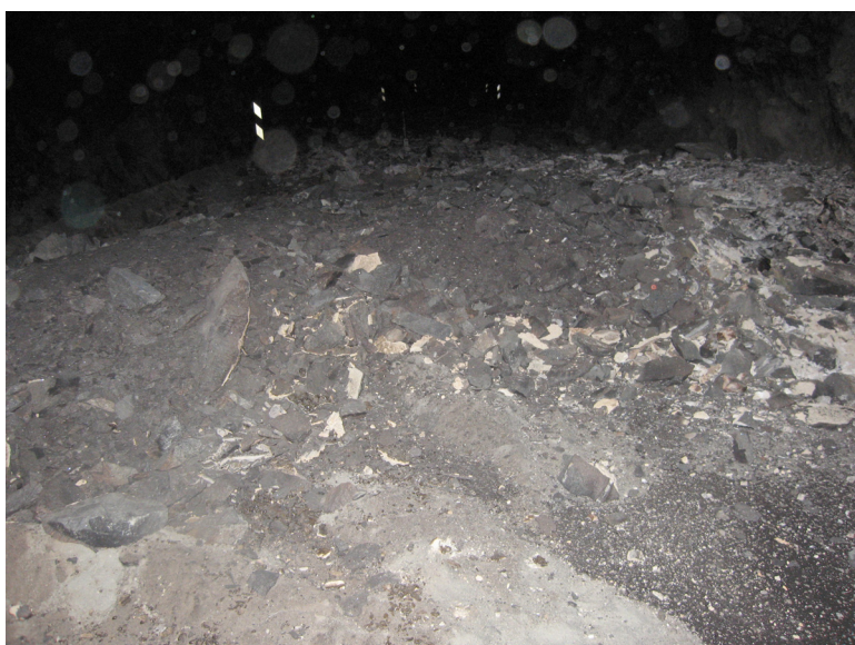
Figur 22 Nedfall nedstrøms brannstedet
