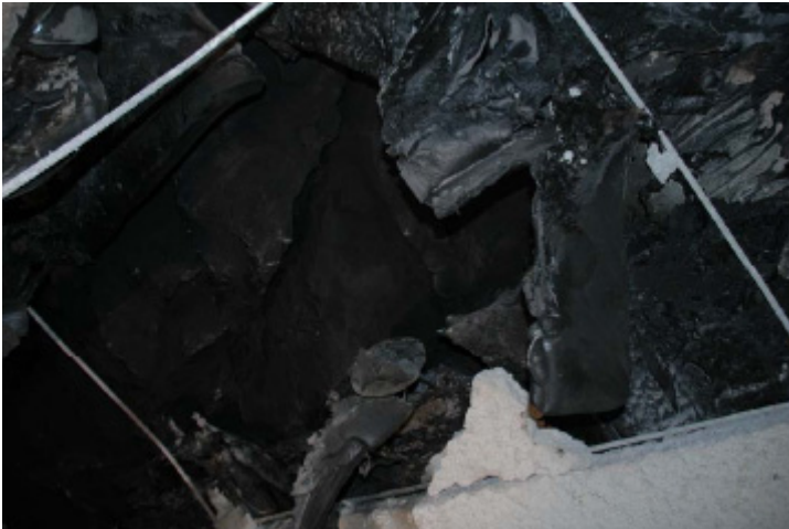
Figur 18 Smeltet PE-skum bak sprøytebetonghvelv
