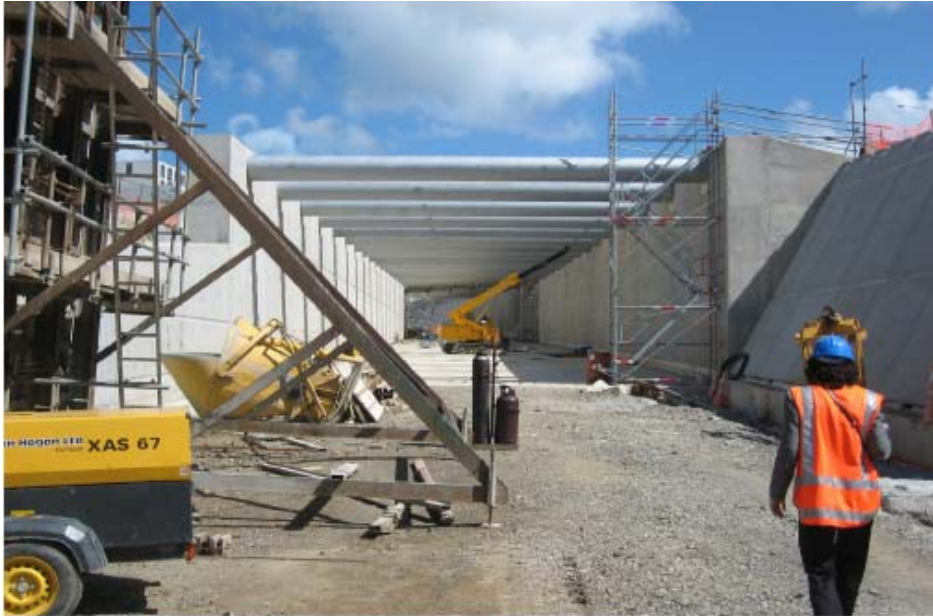
Springflo-kulvert med jordskjelvavstiving.
