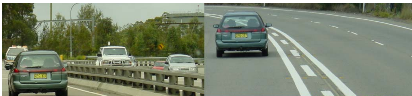
Skille mellom kjøreretninger: Vi fant mange ulike løsninger. Enkel oppmerking, sperrefelt, kjørefelt på ulike nivå (Harbour Bridge, Sydney, se kapittel om trafikkavvikling), lav betongkant mellom kjørefelt og hyppig bruk av wirerekkverk både som midtskille og siderekkverk.
