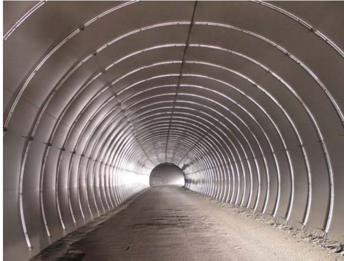
Figur 1. WG Tunnelhvelv T100 ble montert i 75 m lengde
