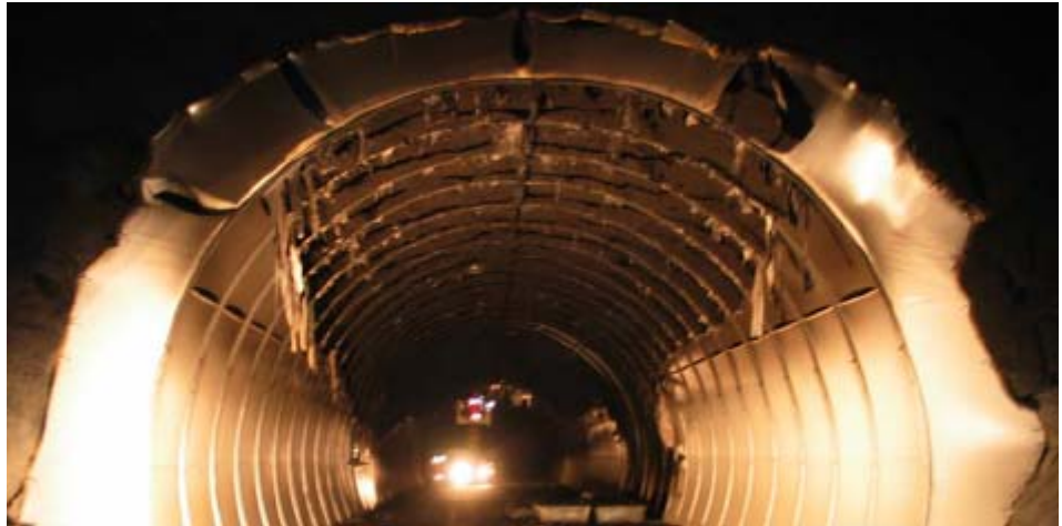
Figur 9. Tunnelhvelvet etter brannen sett oppstrøms brannkilden. Duken er oppbrent i taknivå mens veggene er intakte.
