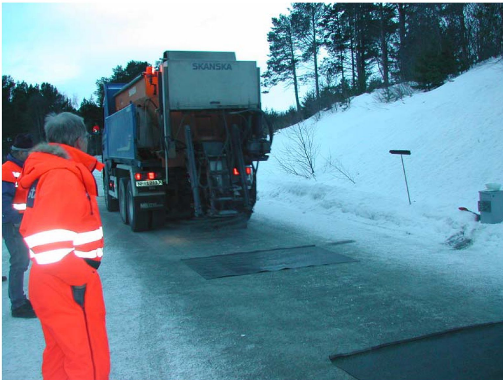
Figur 3.1: Kontroll av vekten på tørrstoffet
