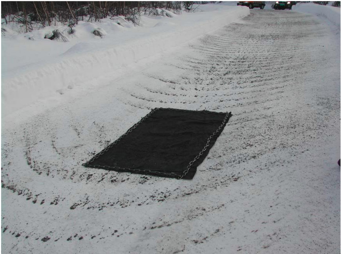
Figur 3.33: Fiberduk for kontroll av utlagte mengder
