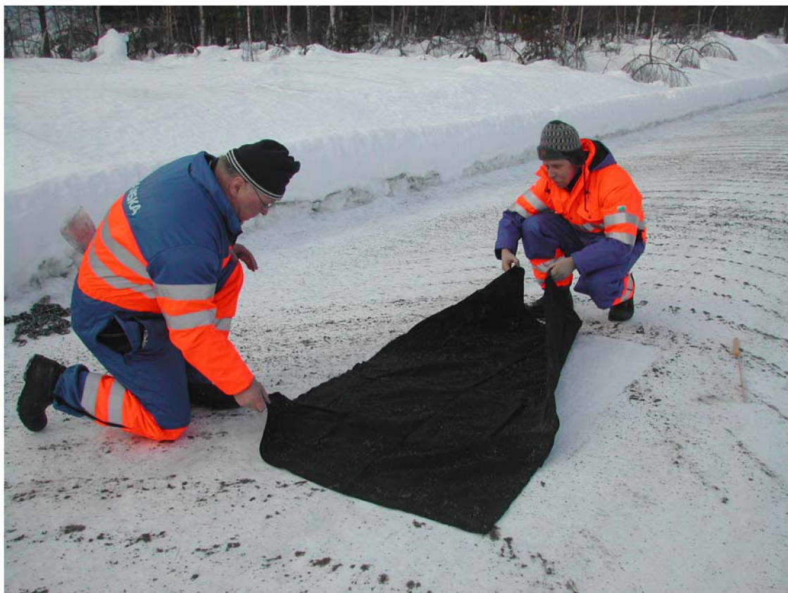
Figur 3.34: Sammenbretting av fiberduk
