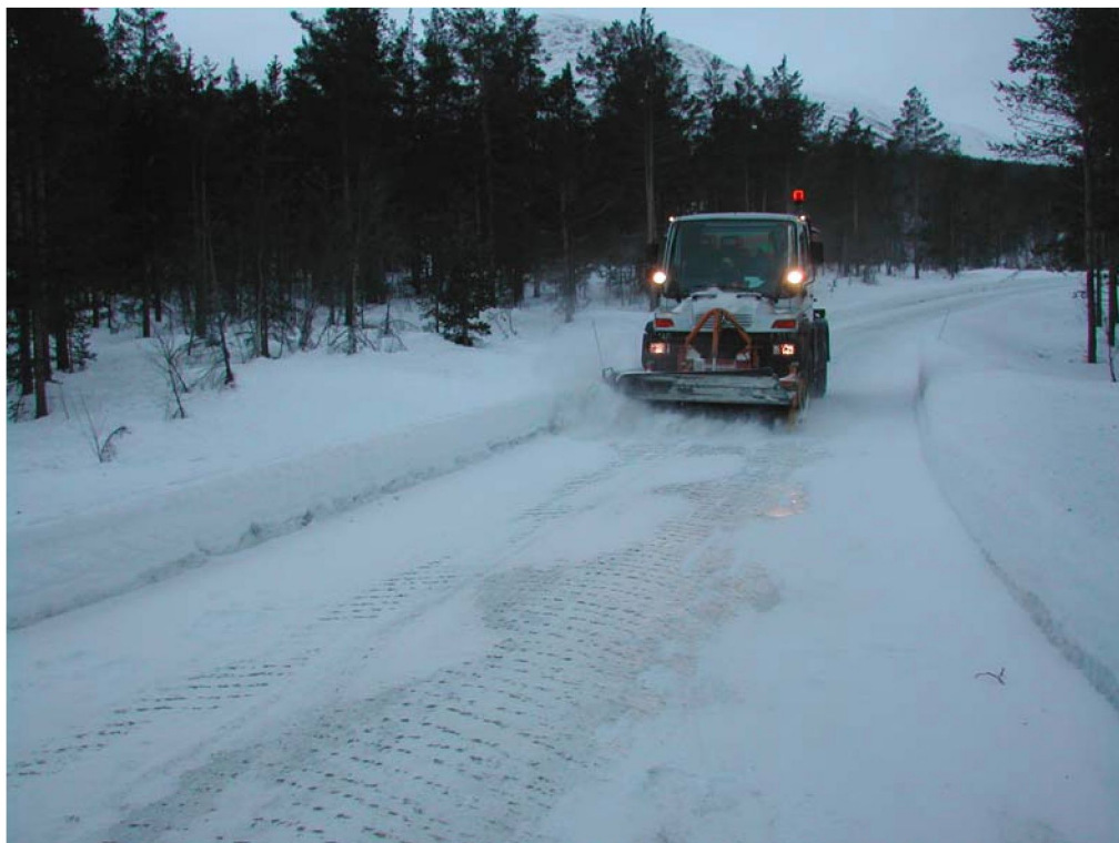
Figur 3.29: Kosting på atkomstveg til flyplass, 19. januar
