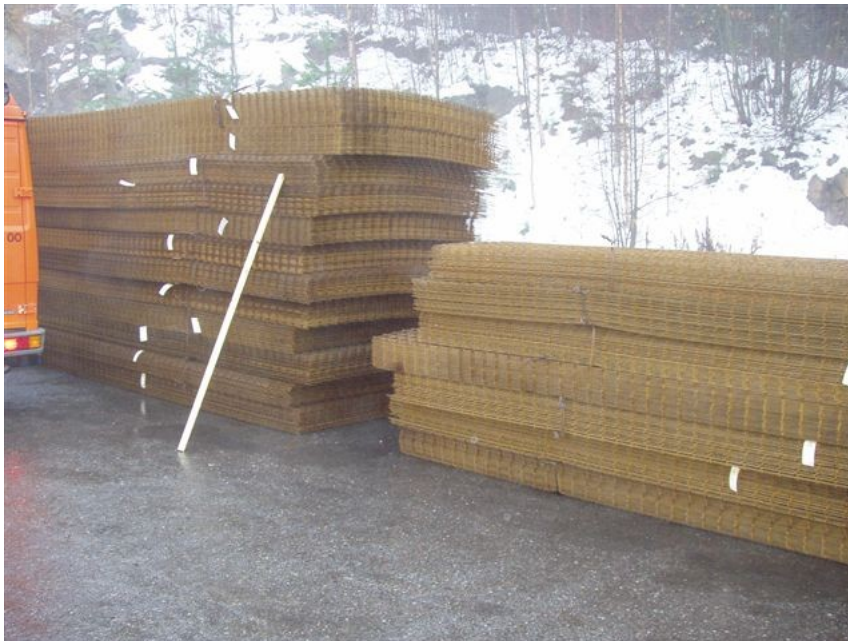
E6 Eidsvolltunnelen, oktober 2005. Stålarmoring er lesset av bilene.
