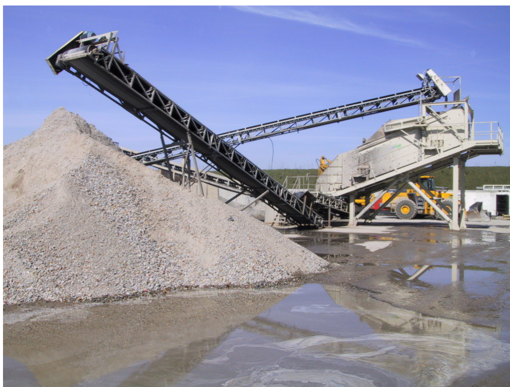
Et av knuseverksoppstillingene til RGS90 på Amager i København.
