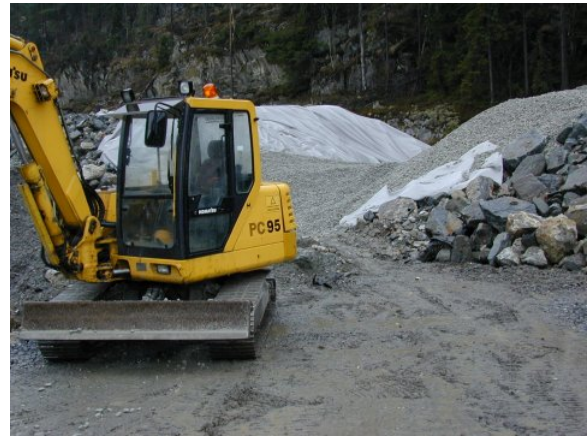
Bilde 5. Utlegging av skumglass på E6
