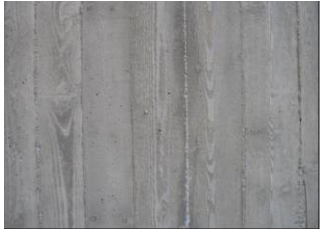
Bilde 10: Perfekt overflate på betong med resirkulert tilslag
