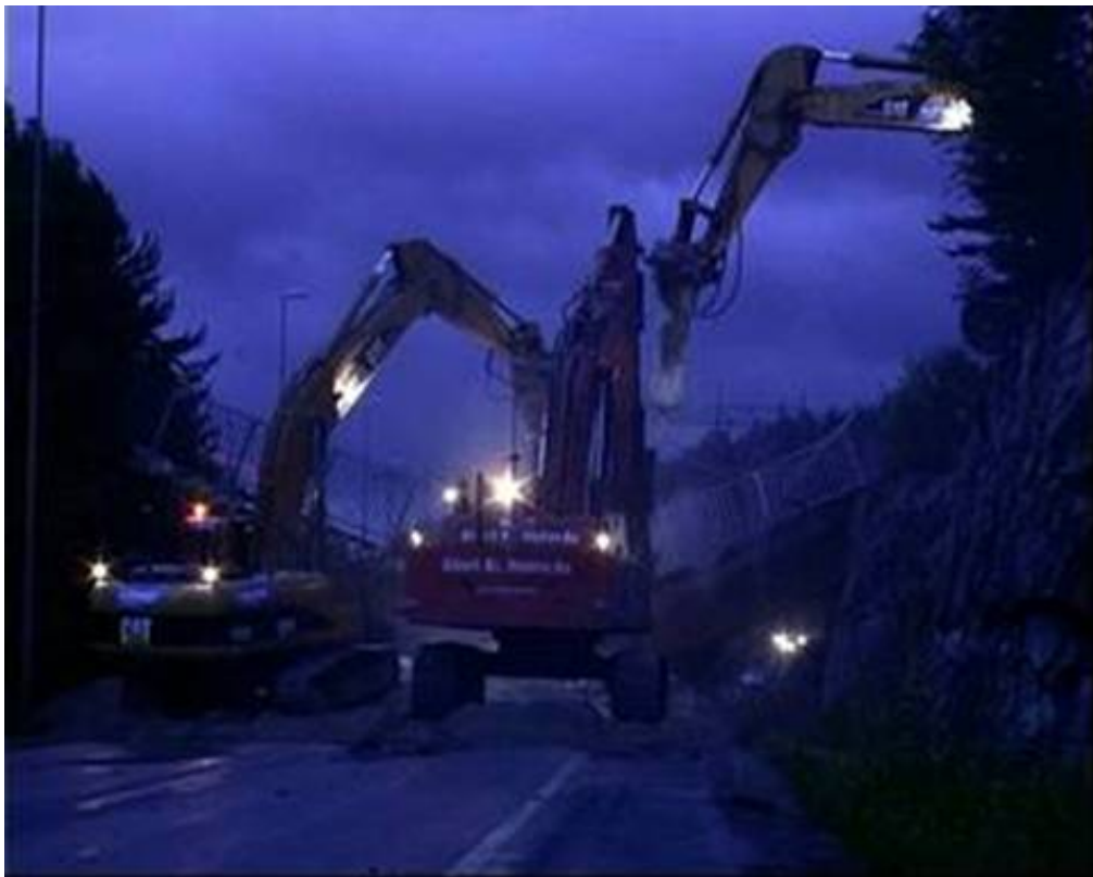
Bilder 1a og 1b: Fra riving av en gangbru over E6 høsten 2003 (foto: NORFILM as)
