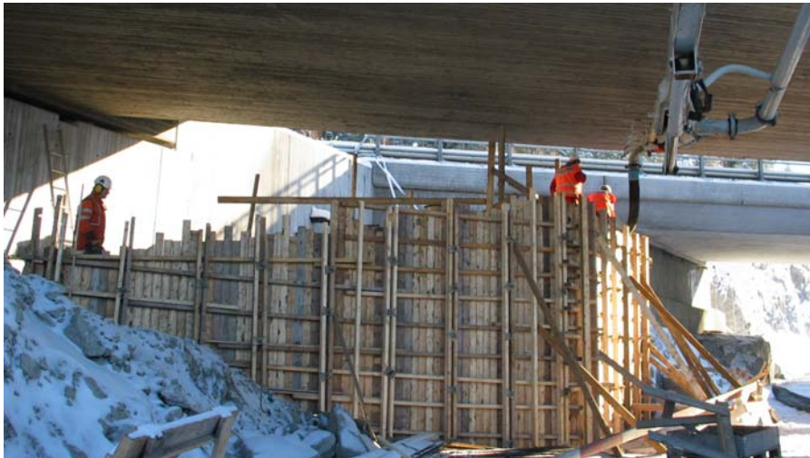
Bilde 7: Støttemuren under Taraldrud bru støpes med betong med 100 % resirkulert tilslag
