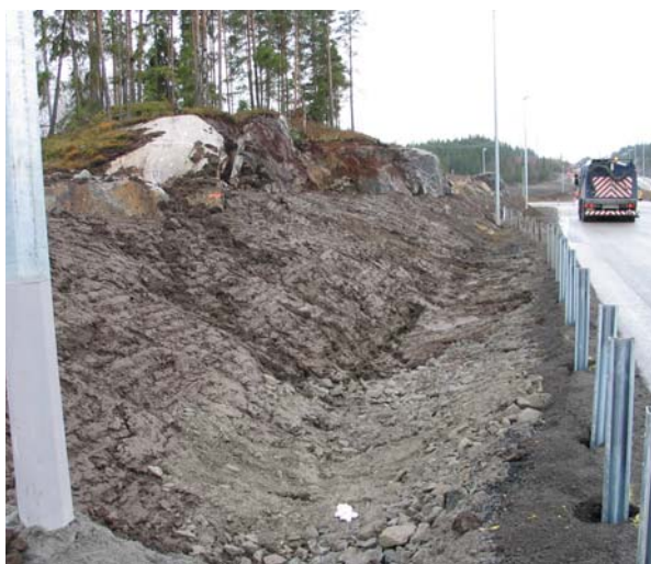
Bilde 11: Ferdig utlagt masse...
