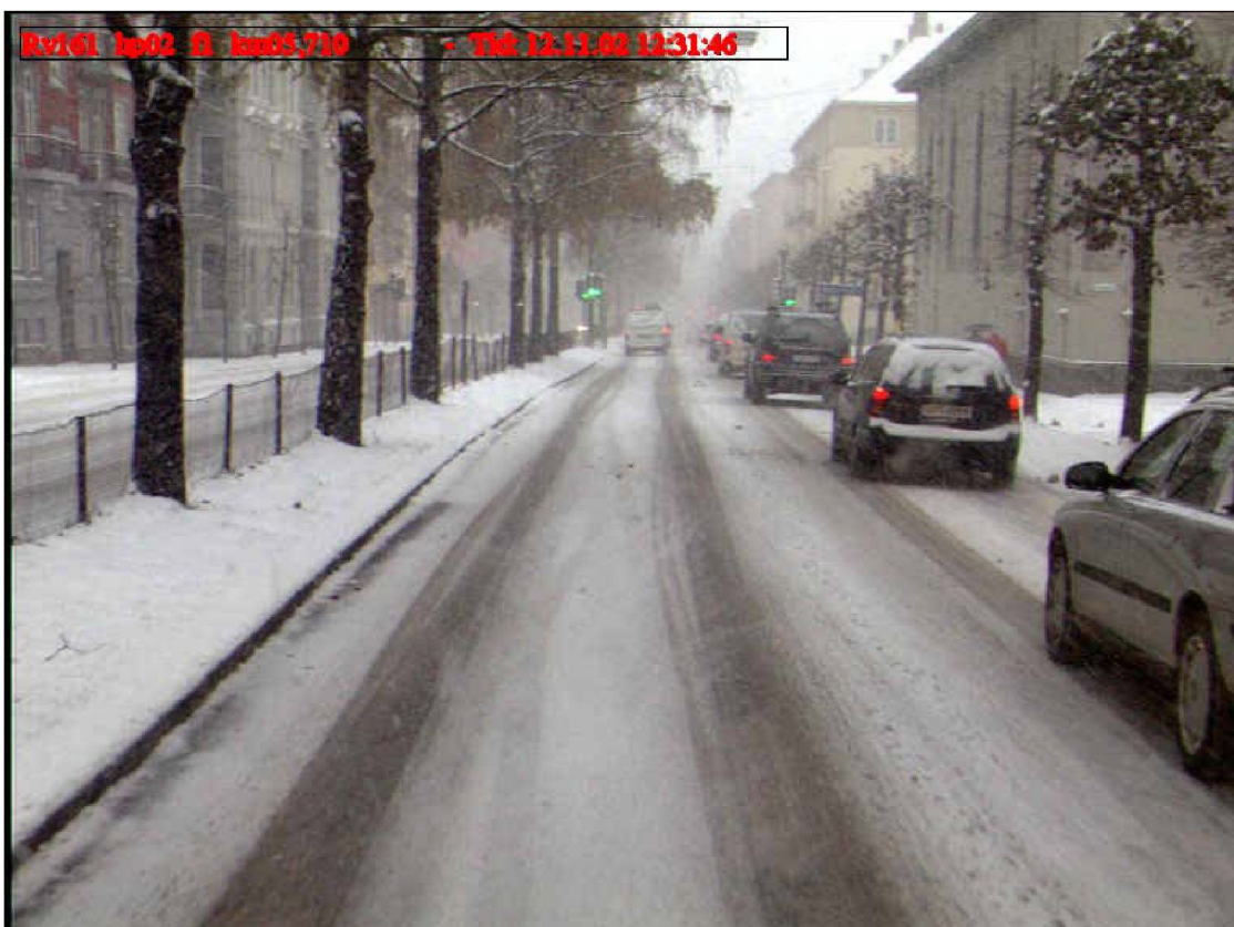
Figur VI.2: Rv 161, ny asfalt
