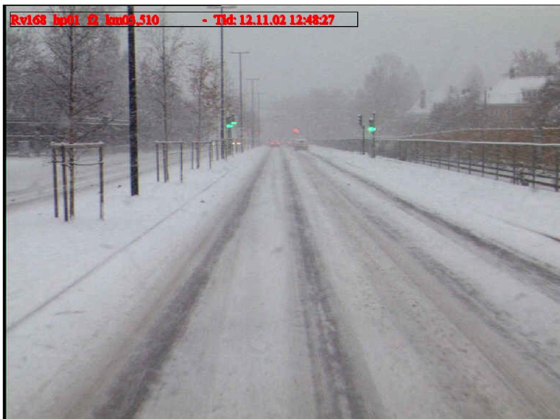
Figur V1.6: Rv 168, ny asfalt
